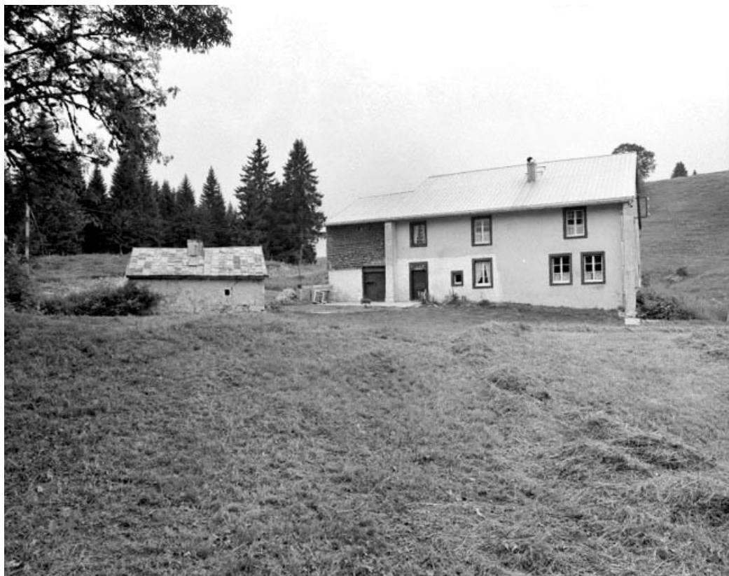
Bellecombe, ferme située au lieu-dit Les Grosses Coupes : ferme à coches symétriques et fournil, façade antérieure.
