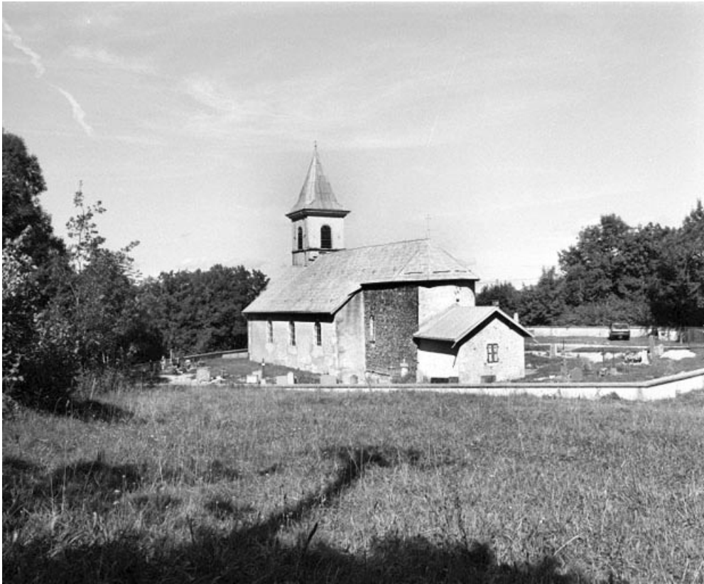
Extérieur : vue générale depuis le sud-ouest.
