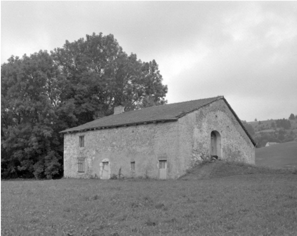
Façade postérieure et face droite.
