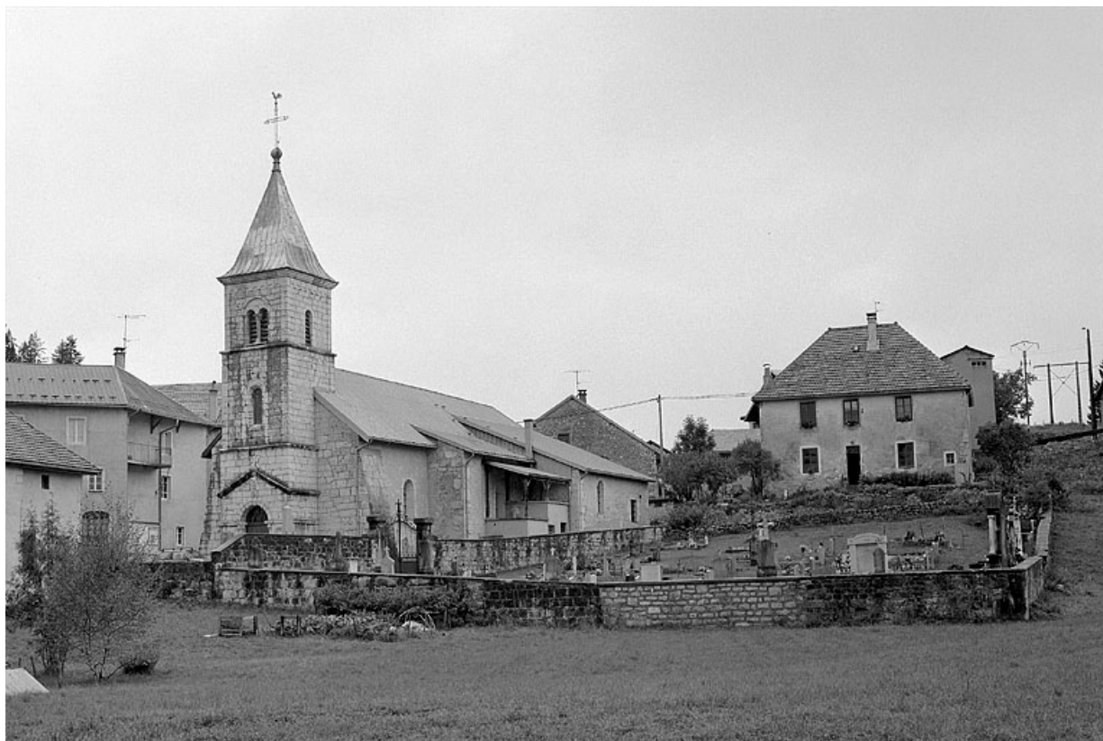
Extérieur : vue générale depuis le sud-ouest.
