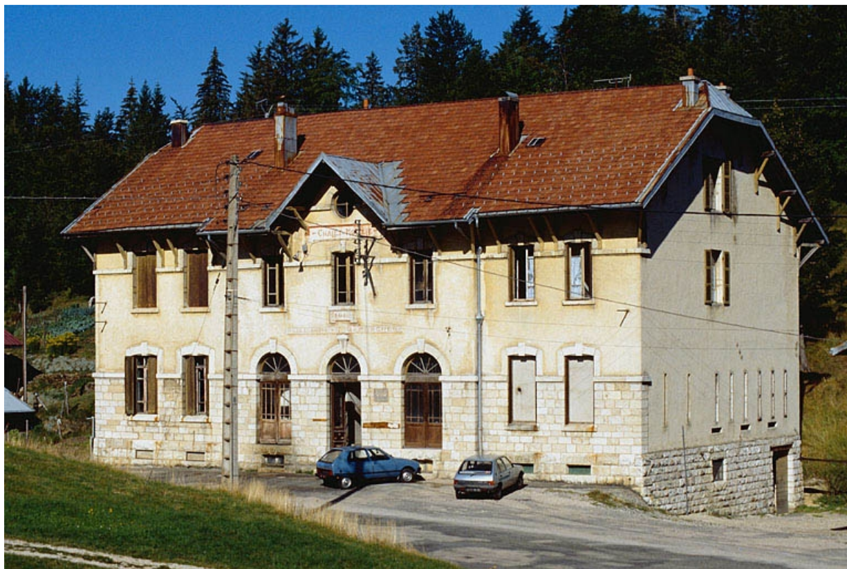
Fromagerie vue de trois quarts droit.
