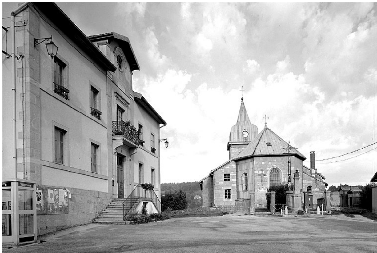
Extérieur : l'église et la mairie-école vues depuis la place.
