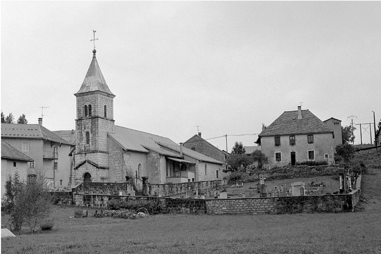
Extérieur : vue générale depuis le sud-ouest.
