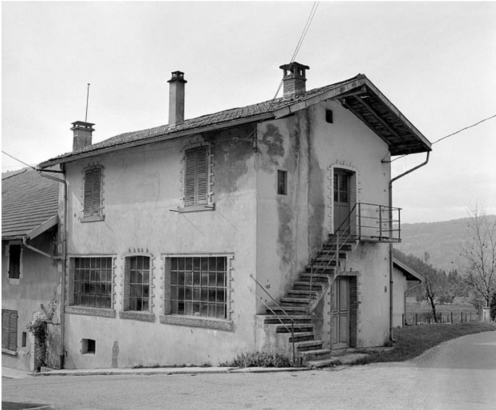
Façade longitudinale et pignon.
