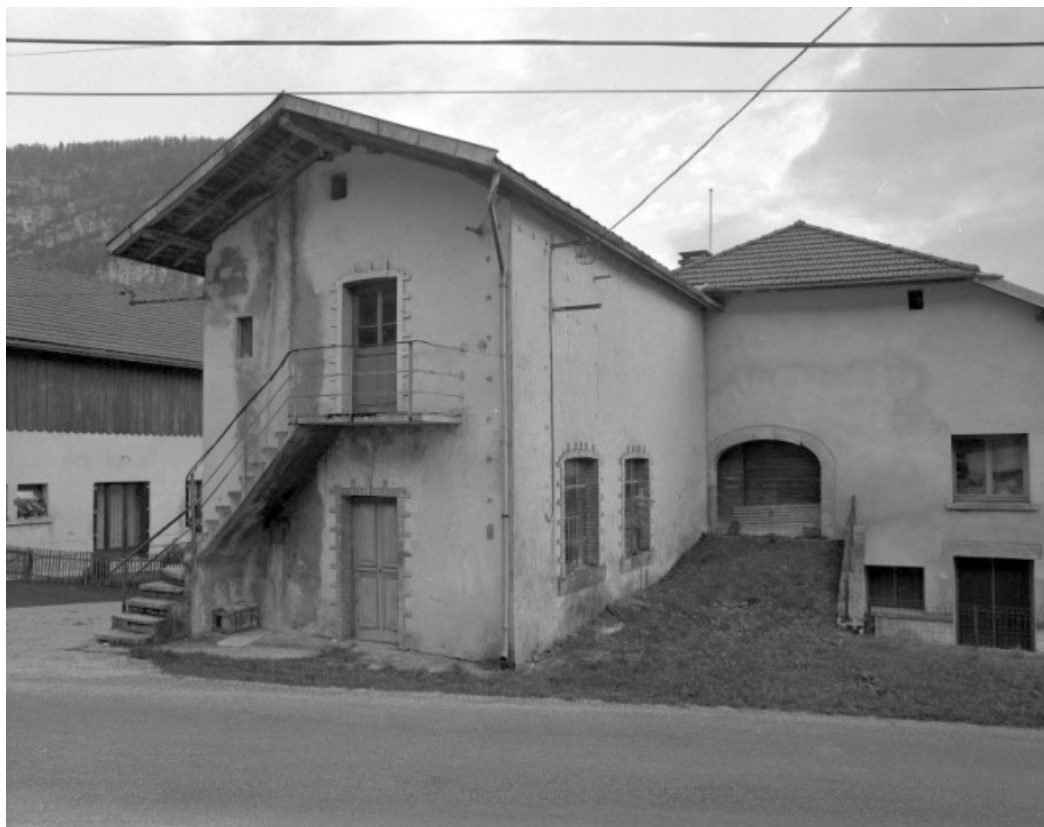
Pignon, façade postérieure et accès à la grange haute de la ferme mitoyenne.
