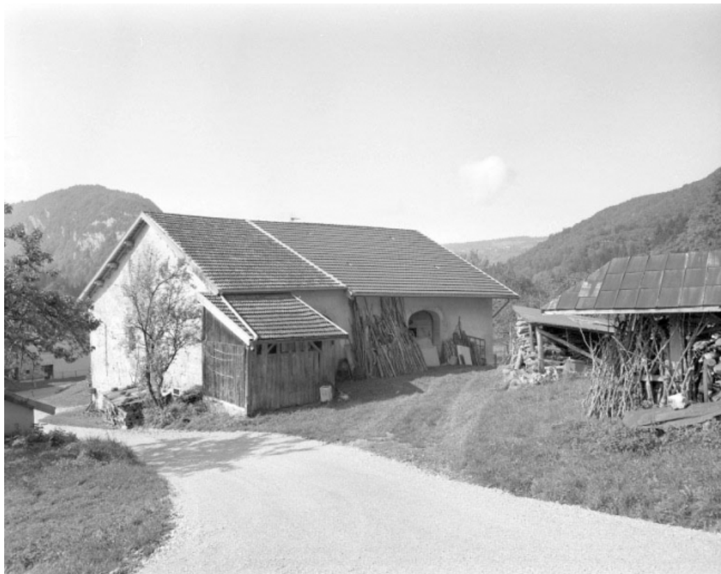
Vue générale de la façade postérieure.
