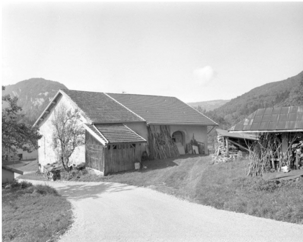
Vue générale de la façade postérieure.
