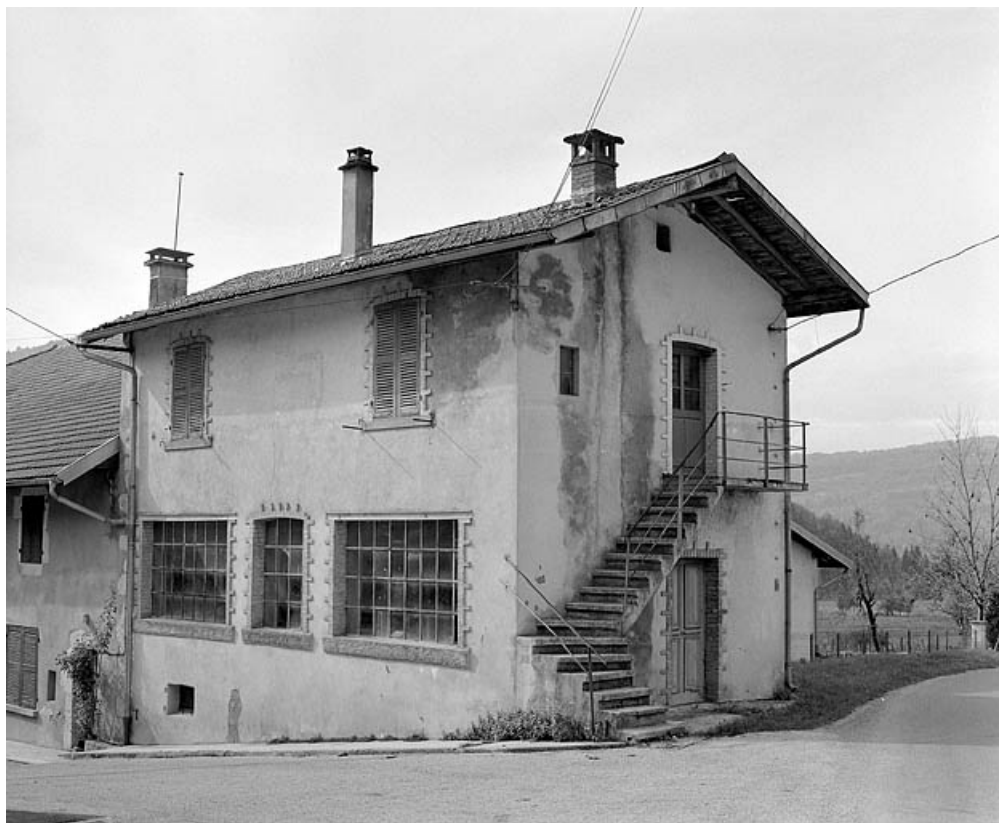
Façade longitudinale et pignon.
