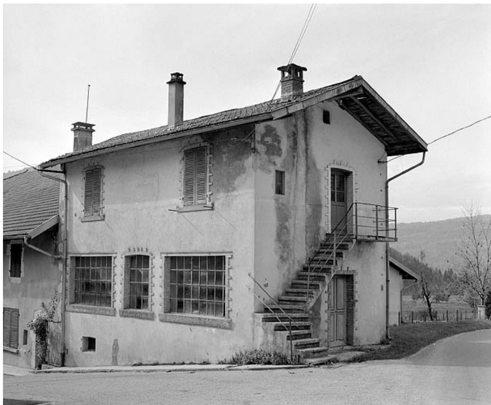
Façade longitudinale et pignon.
