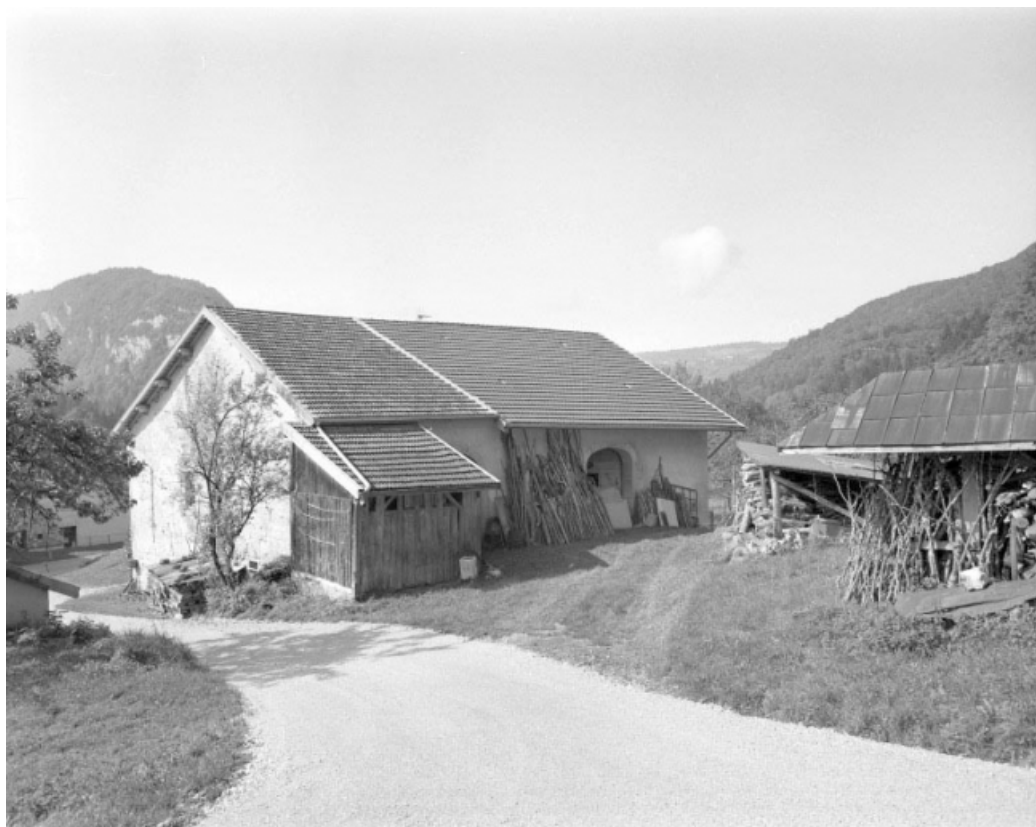
Vue générale de la façade postérieure.
