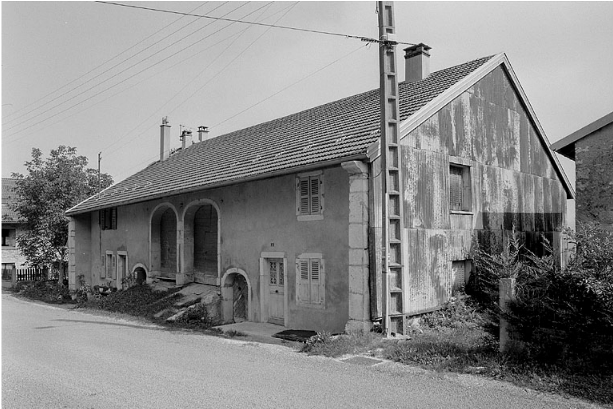
Ferme vue depuis le CD 293 E1.
