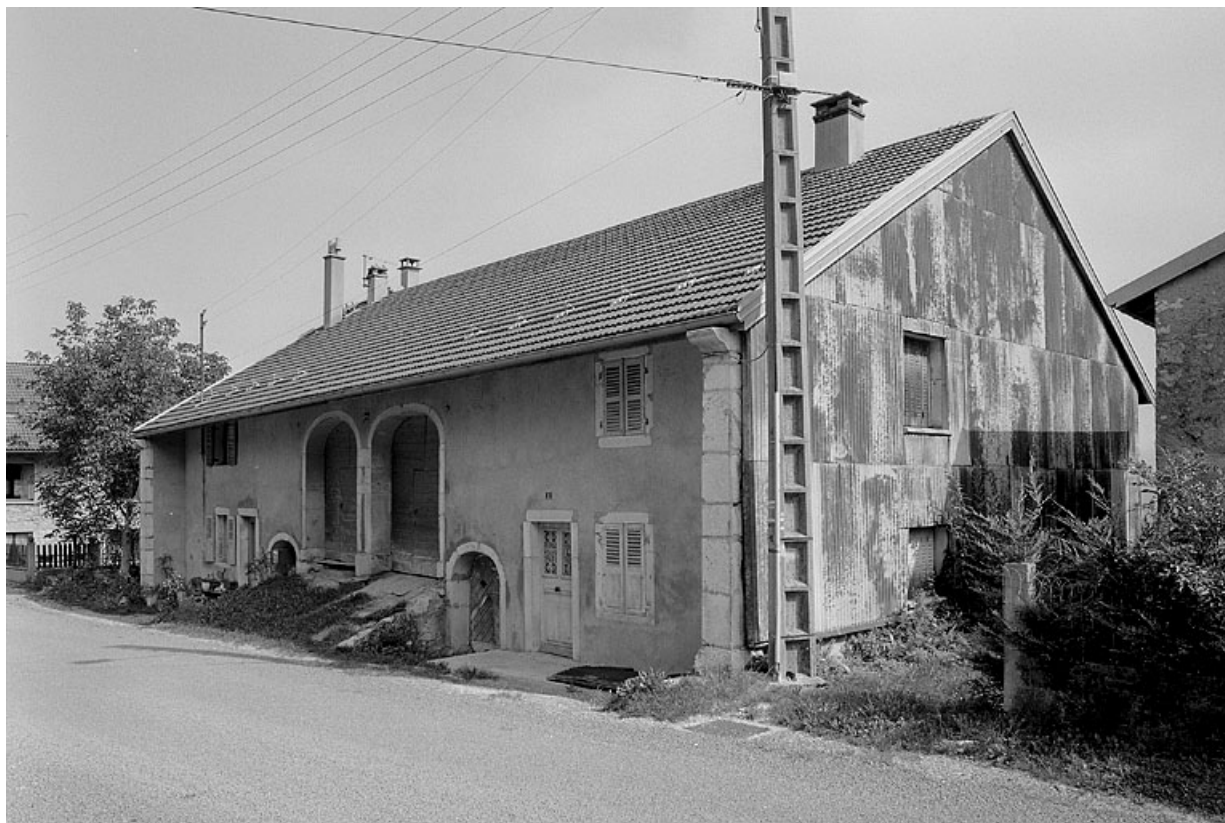
Ferme vue depuis le CD 293 E1.
