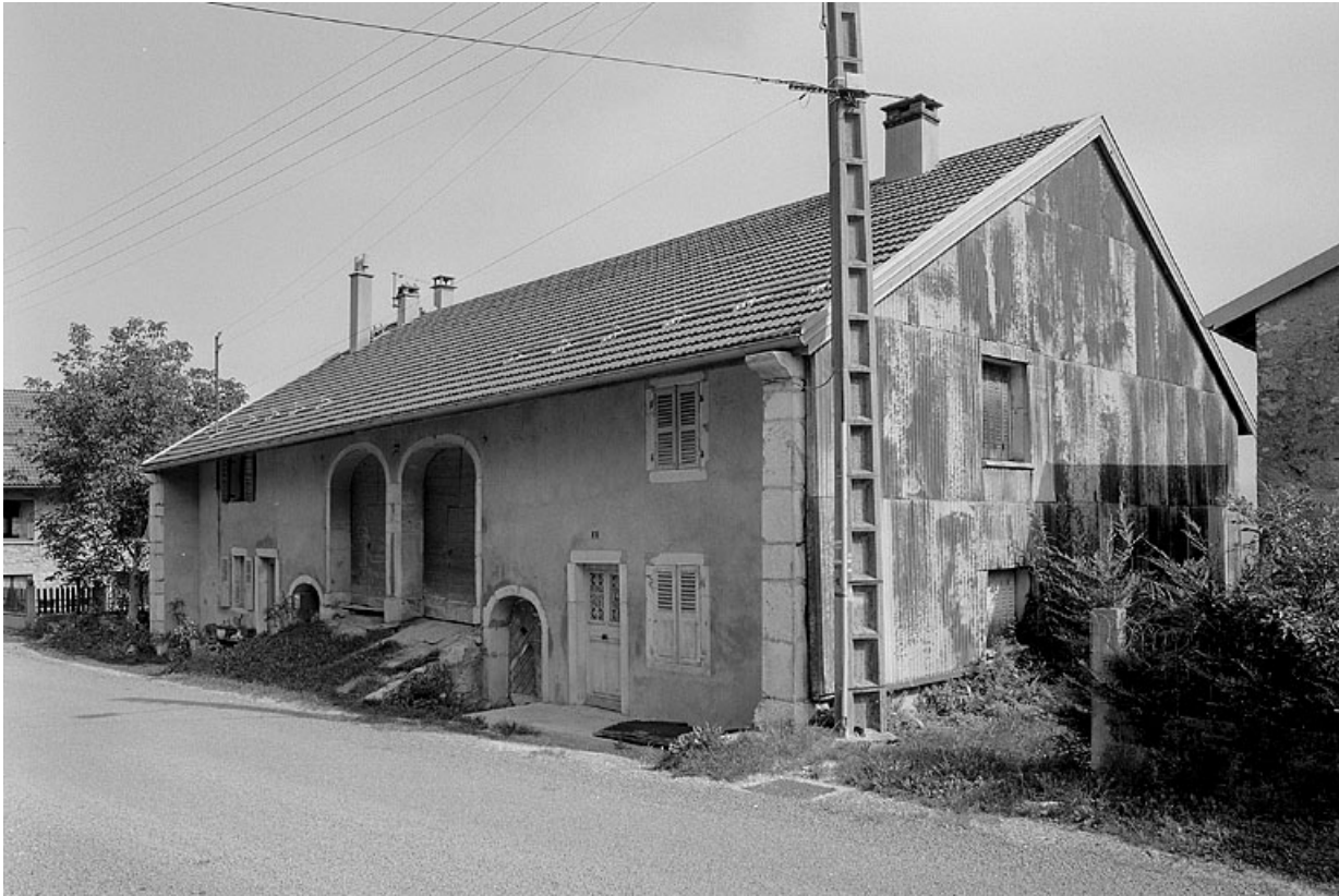
Ferme vue depuis le CD 293 E1.
