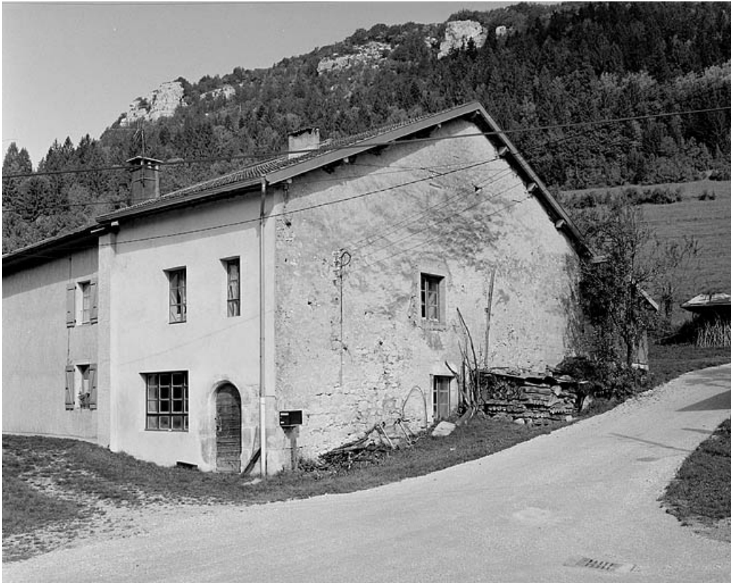
Façade antérieure et face droite.
