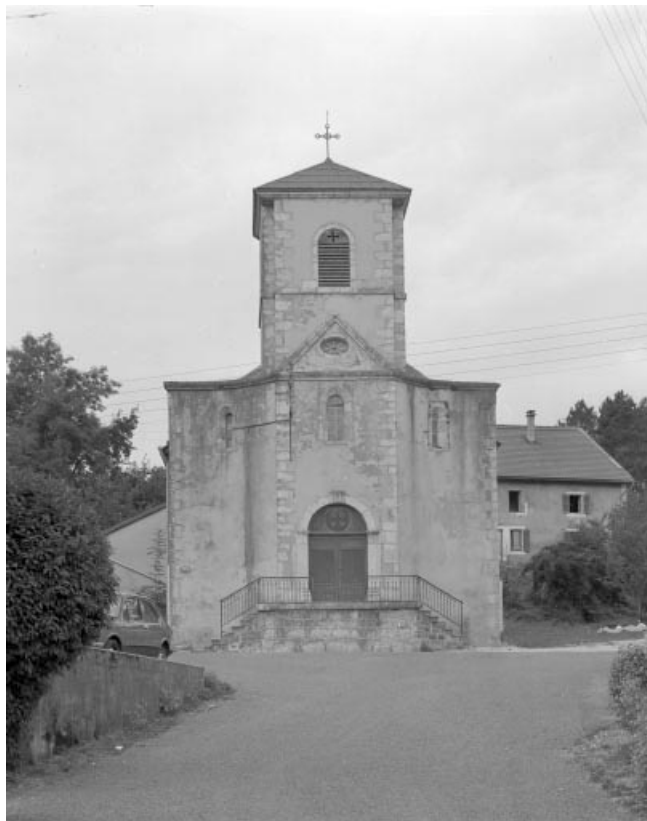
Extérieur : façade ouest.
