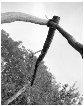
Détail des crochets retenant les cables qui permettaient de descendre le lait jusqu'à la fromagerie. 39, Larrivoire
