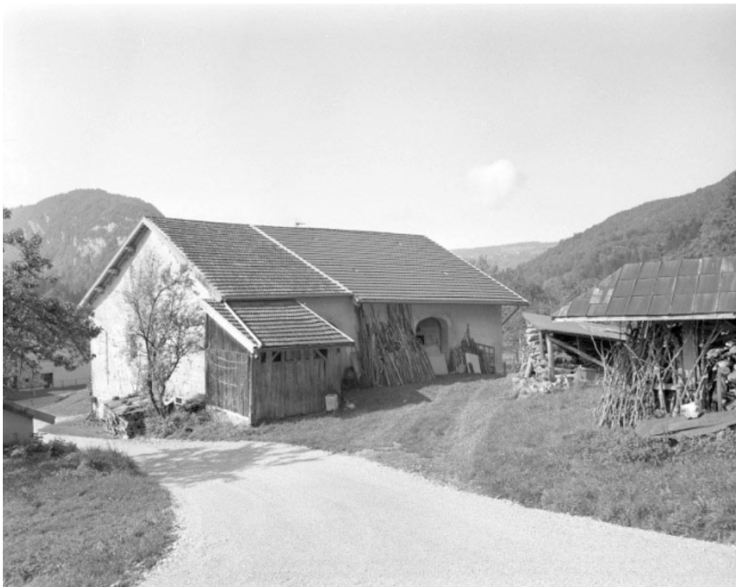
Vue générale de la façade postérieure.
