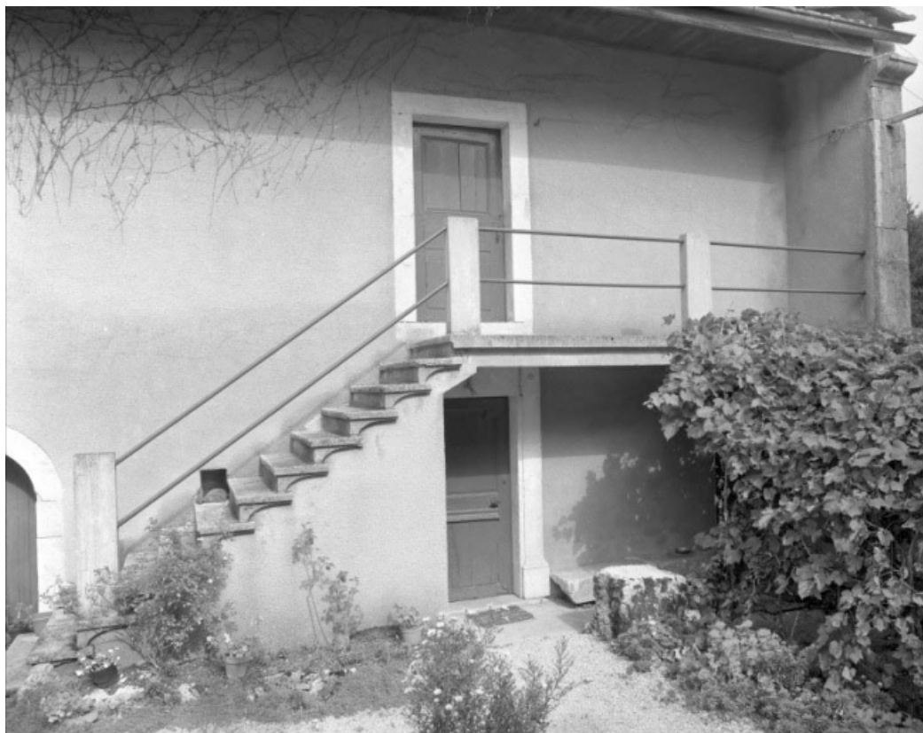
Façade antérieure, les accès aux logis.
