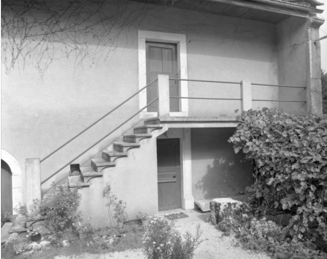
Façade antérieure, les accès aux logis.
