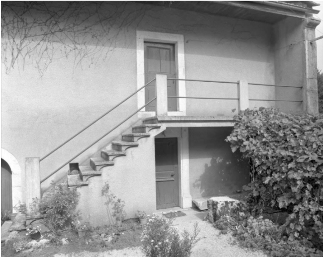
Façade antérieure, les accès aux logis.
