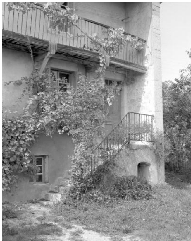
Façade antérieure, accès au logis de droite.
