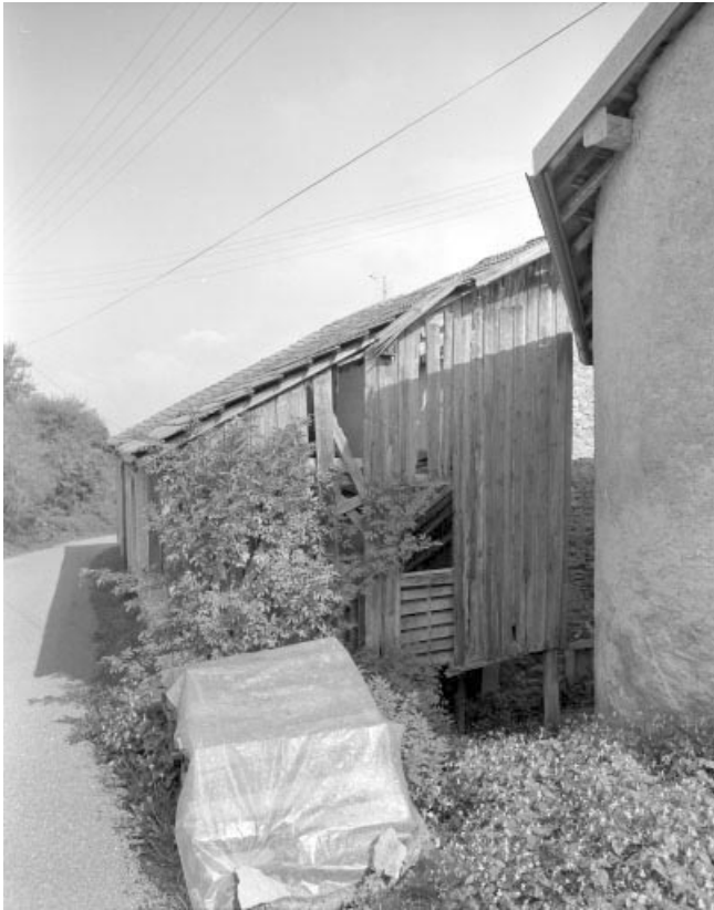
Face gauche, avec bûcher et dessous, accès à l'étable.
