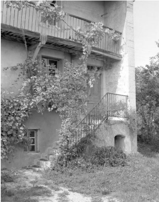
Façade antérieure, accès au logis de droite.
