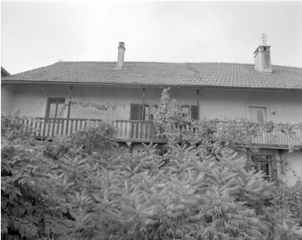
Façade antérieure, balcon.
