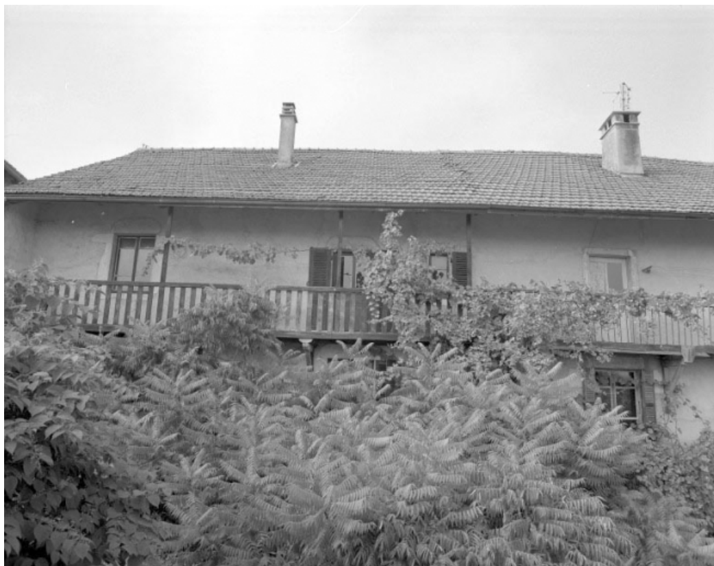
Façade antérieure, balcon.
