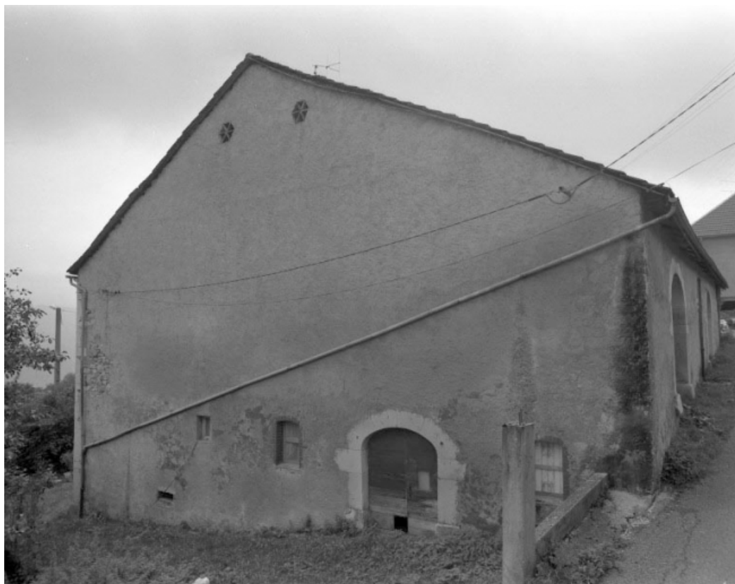
Face droite avec accès à l'étable.
