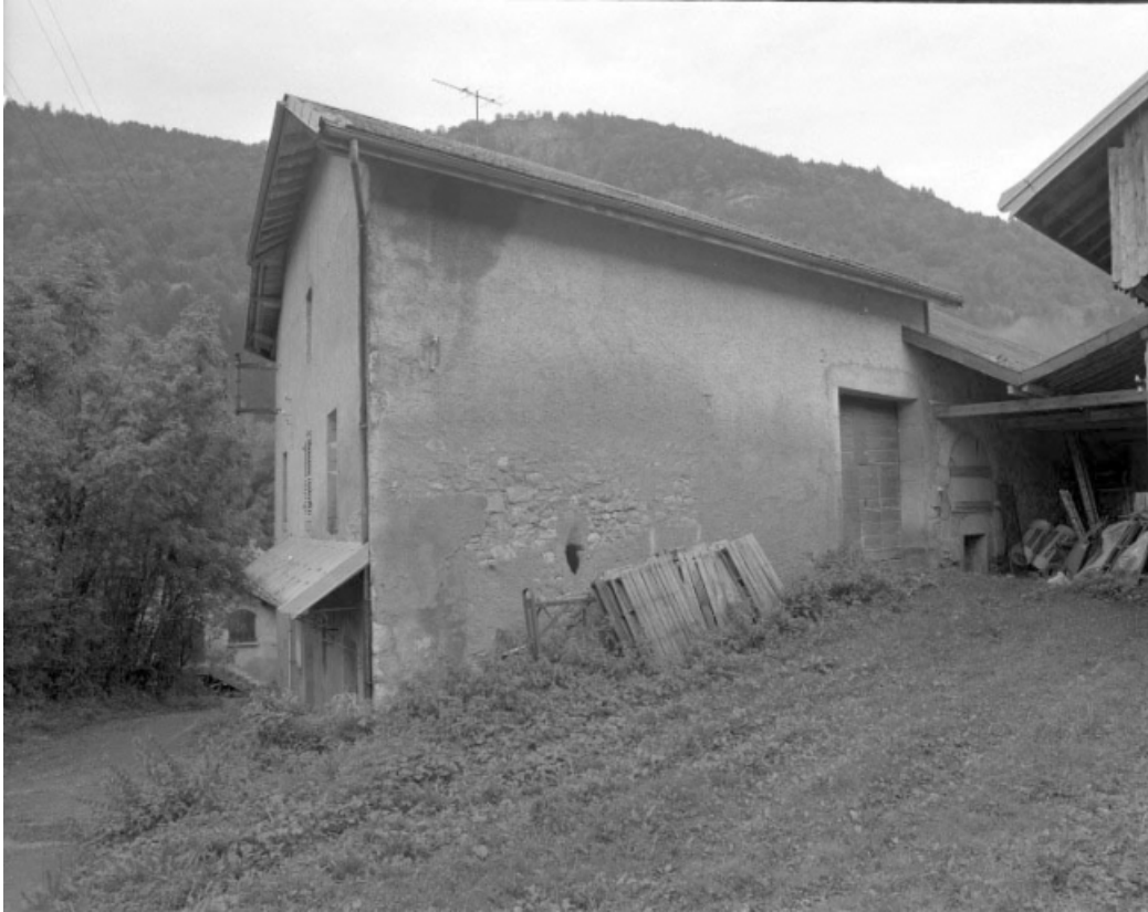
Mur gouttereau sur lequel se trouve l'accès à la grange. 39, Coiserette
