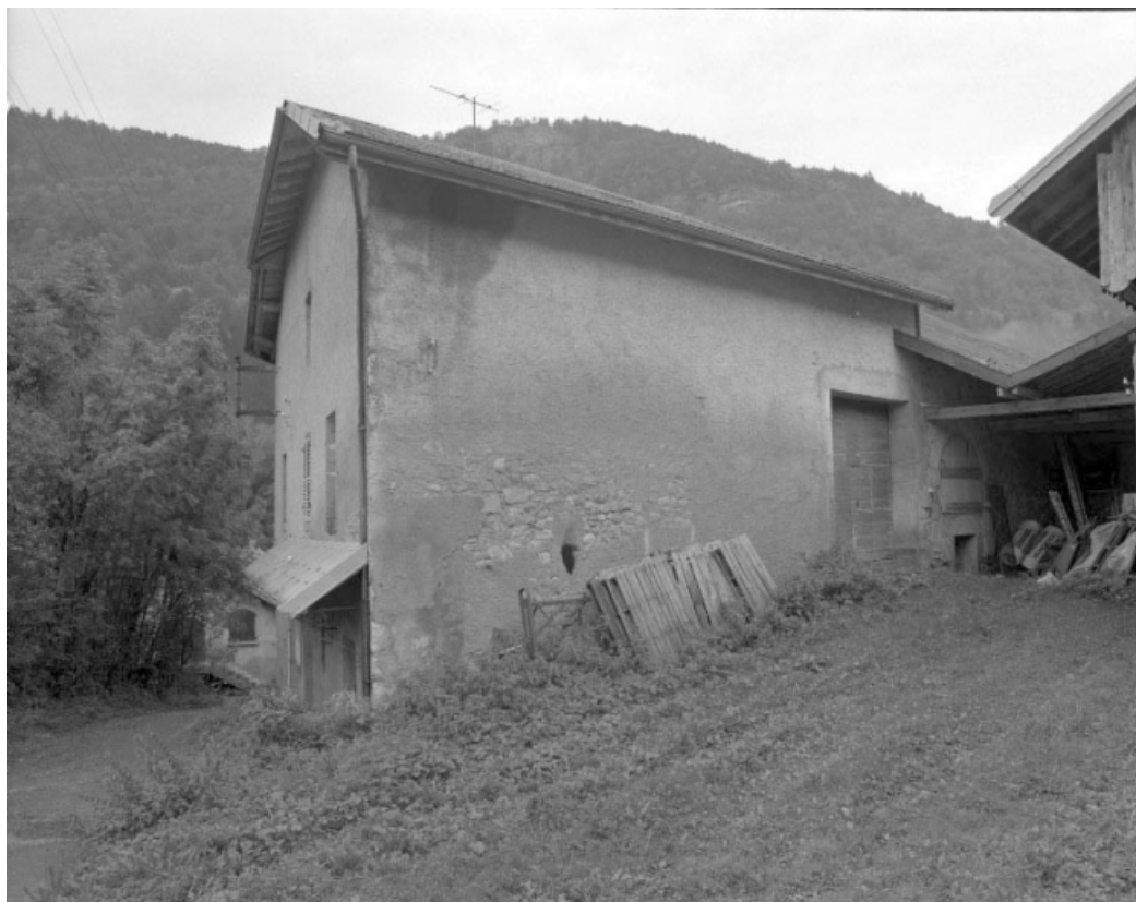
Mur gouttereau sur lequel se trouve l'accès à la grange.
