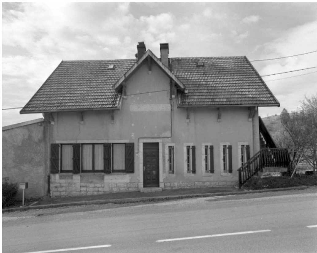
Façade antérieure du chalet du Rosay.
