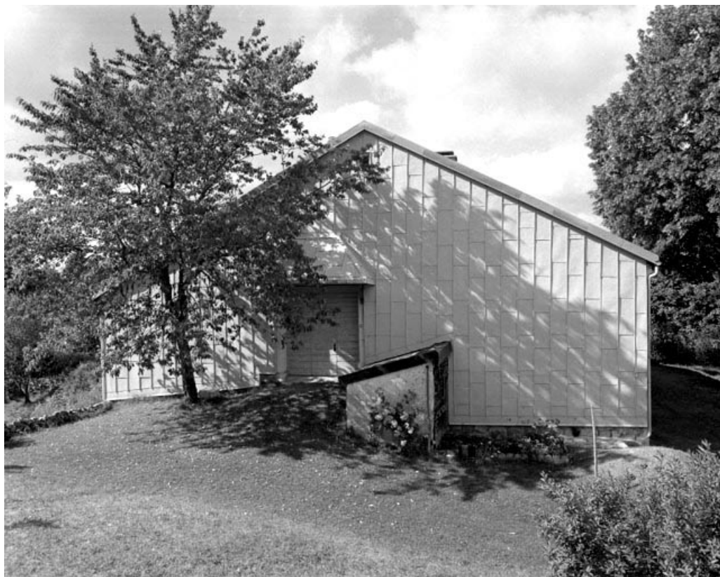
La Pesse, ferme située au lieu-dit Sur les Couronnes : facade gauche recouverte d'un essentage de zinc.
