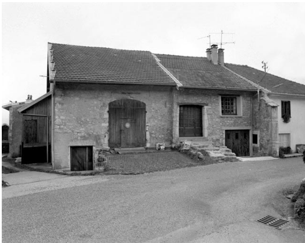
Rogna, ferme : accès à l'étable et à la grange sur la façade postérieure.
