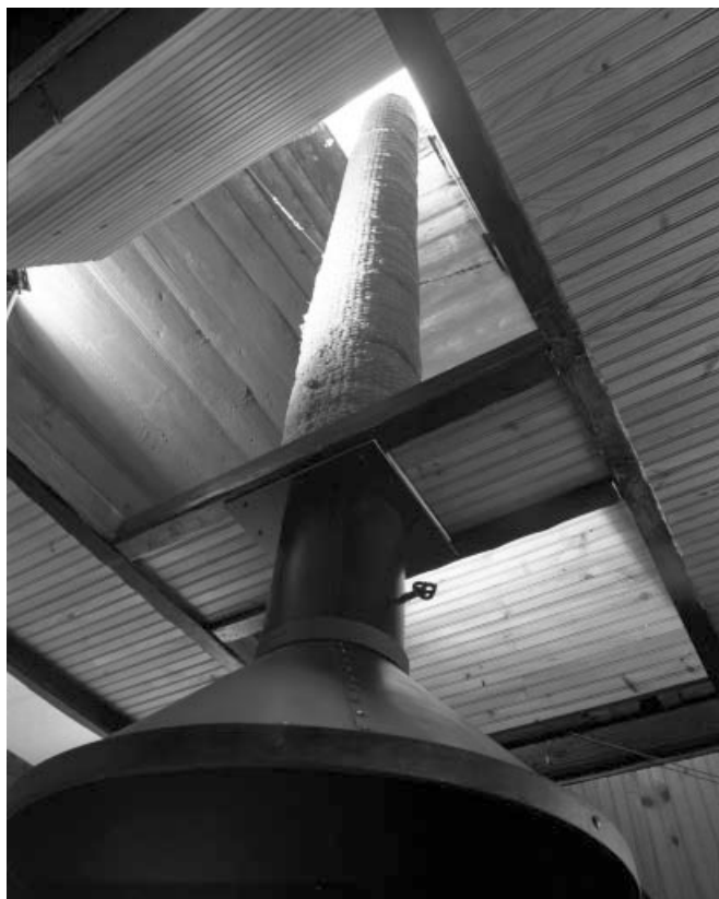
Les Moussières, ferme : intérieur du conduit de la cheminée en bois, un nouveau conduit isolé a été ajouté pour la cheminée actuelle.
