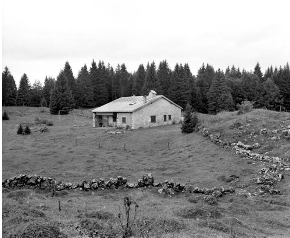
Les Moussières, ferme située au lieu-dit Montechoux : ferme appelée «loge», vue d'ensemble.
