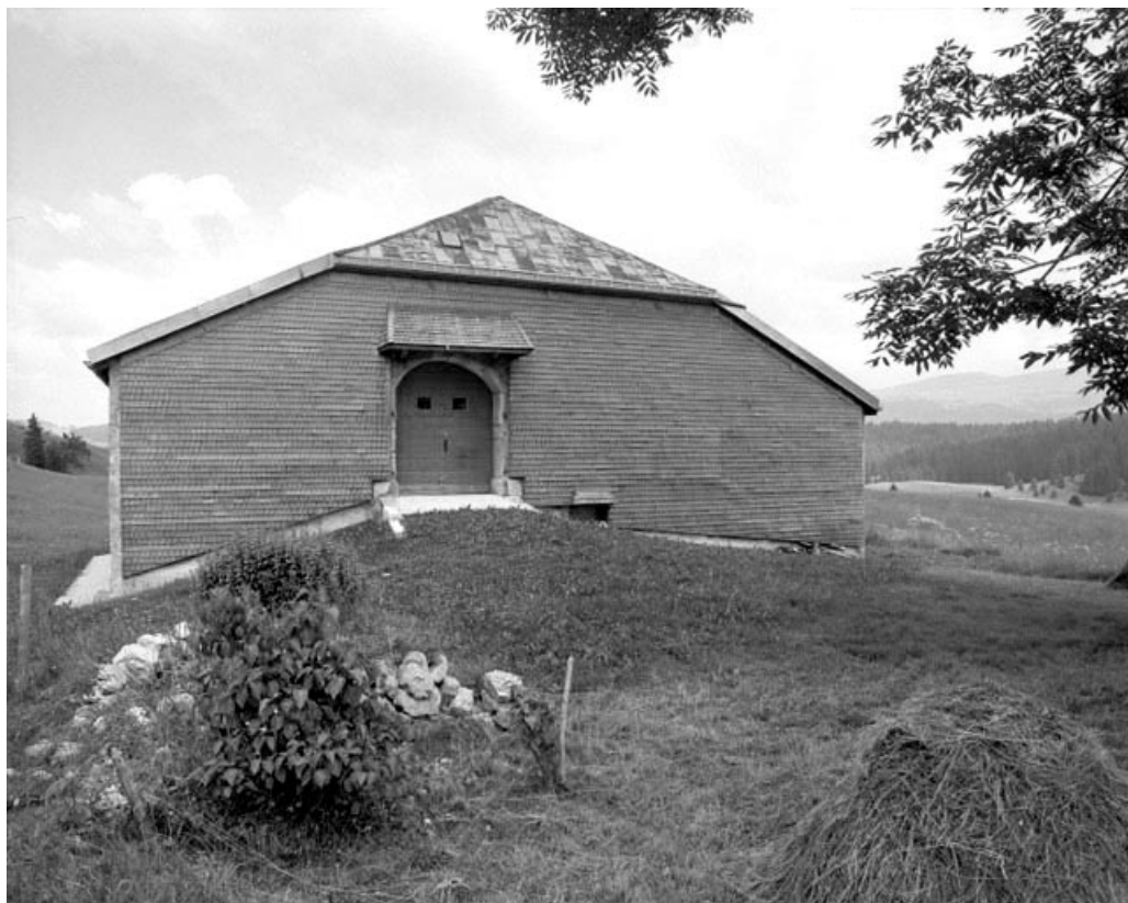
Bellecombe, ferme : pignon avec essentage de tavaillons et grange haute.
