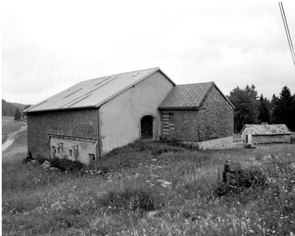
Bellecombe, ferme située au lieu-dit Les Grosses Coupes : extension sur la face latérale d'une ferme.
