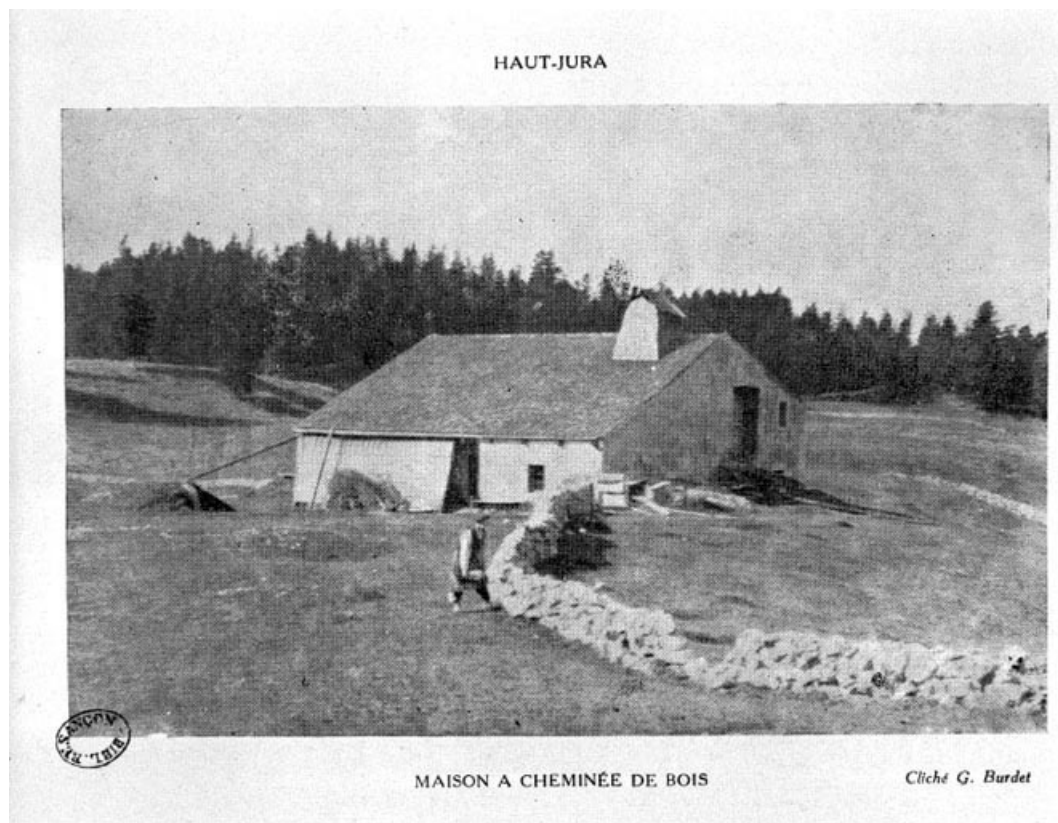
Les Bouchoux : maison à cheminée en bois.
