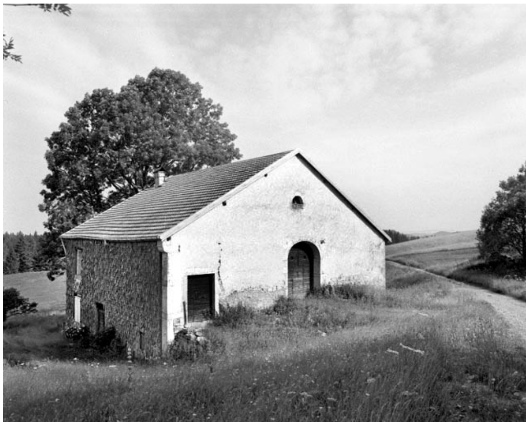
La Pesse, ferme située au lieu-dit Le Reculet : accès à la grange haute par le terrain naturel.
