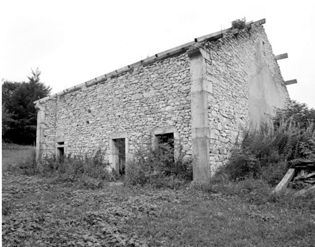
Les Bouchoux, ferme située au lieu-dit Sur Beau Regard : appareillage peu soigné de moellons.
