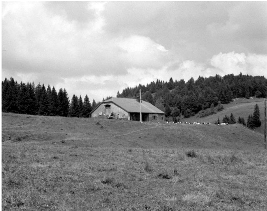
Bellecombe, ferme de la Lugonne : vue générale d'une ferme en rez-de-chaussée.
