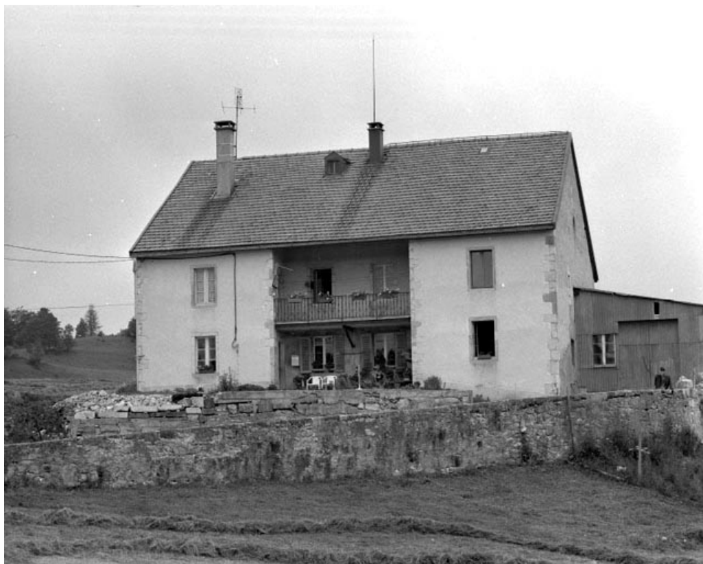
Bellecombe, ferme située au lieu-dit Le Cernois : façade antérieure d'une ferme à galerie centrale.
