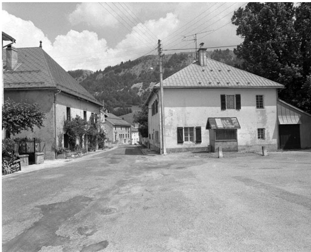
La rue Principale depuis la place du village.
