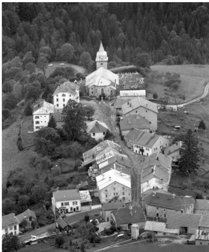
Vue rapprochée du village des Bouchoux depuis la Croix des Couloirs. 39, Les Bouchoux
