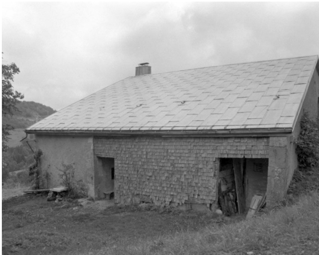
Façade antérieure avec galerie fermée en tavaillons.
