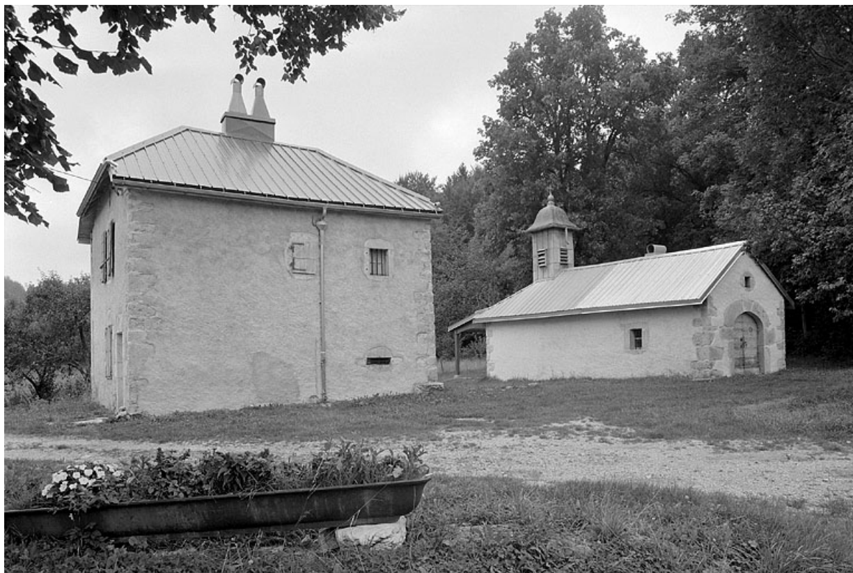
Façade postérieure de la chapelle, à ses côtés la maison d'habitation.
