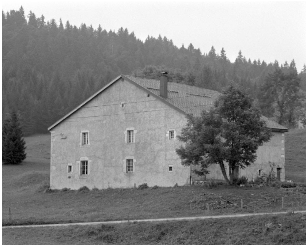
Face droite et façade postérieure.
