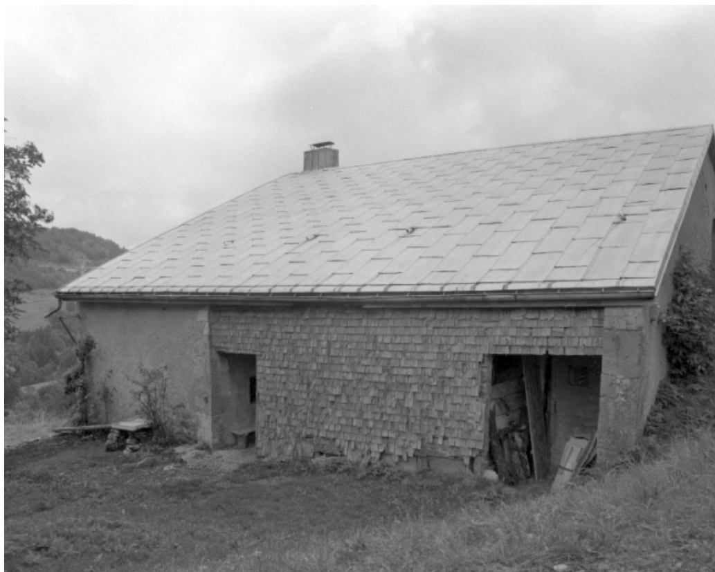
Façade antérieure avec galerie fermée en tavaillons.
