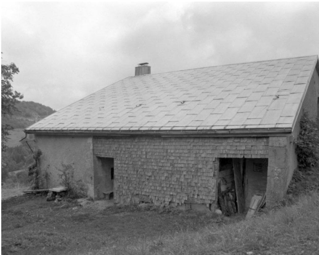
Façade antérieure avec galerie fermée en tavaillons.
