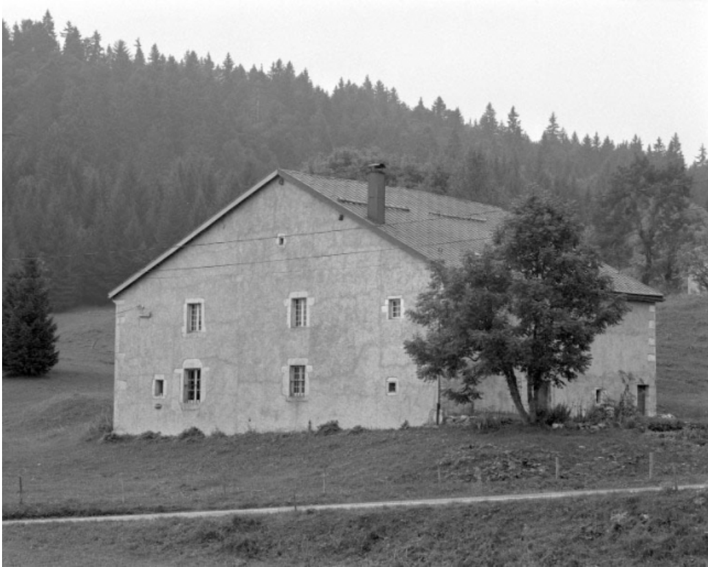
Face droite et façade postérieure.
