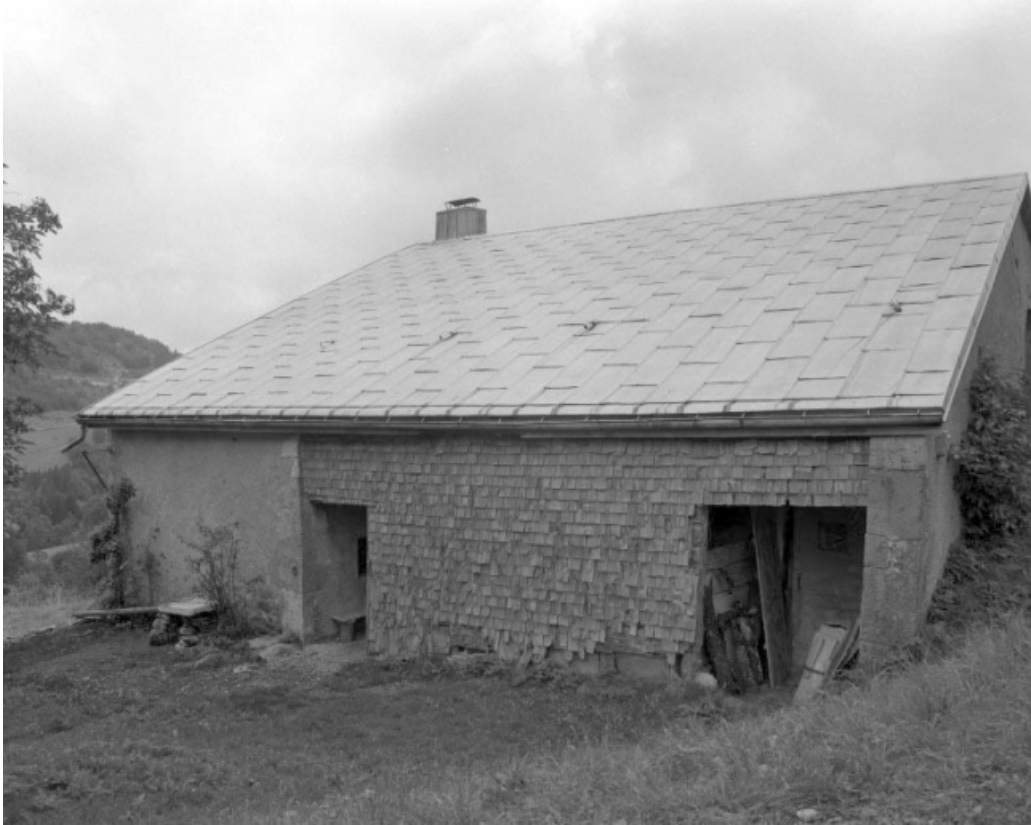
Façade antérieure avec galerie fermée en tavillons.
