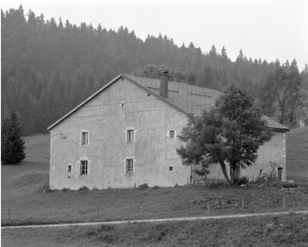
Face droite et façade postérieure.
