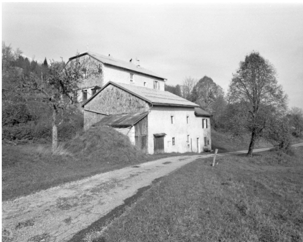
Façade postérieure et face droite.
