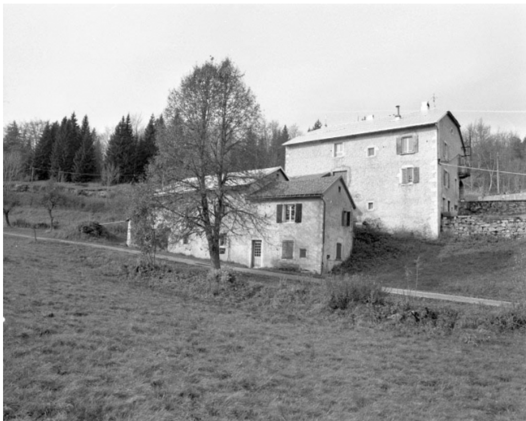
Façade postérieure, vue générale.
