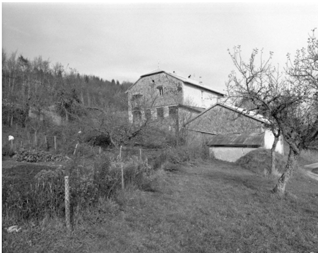
Vue générale de la face droite de la maison et de l'abattoir.
