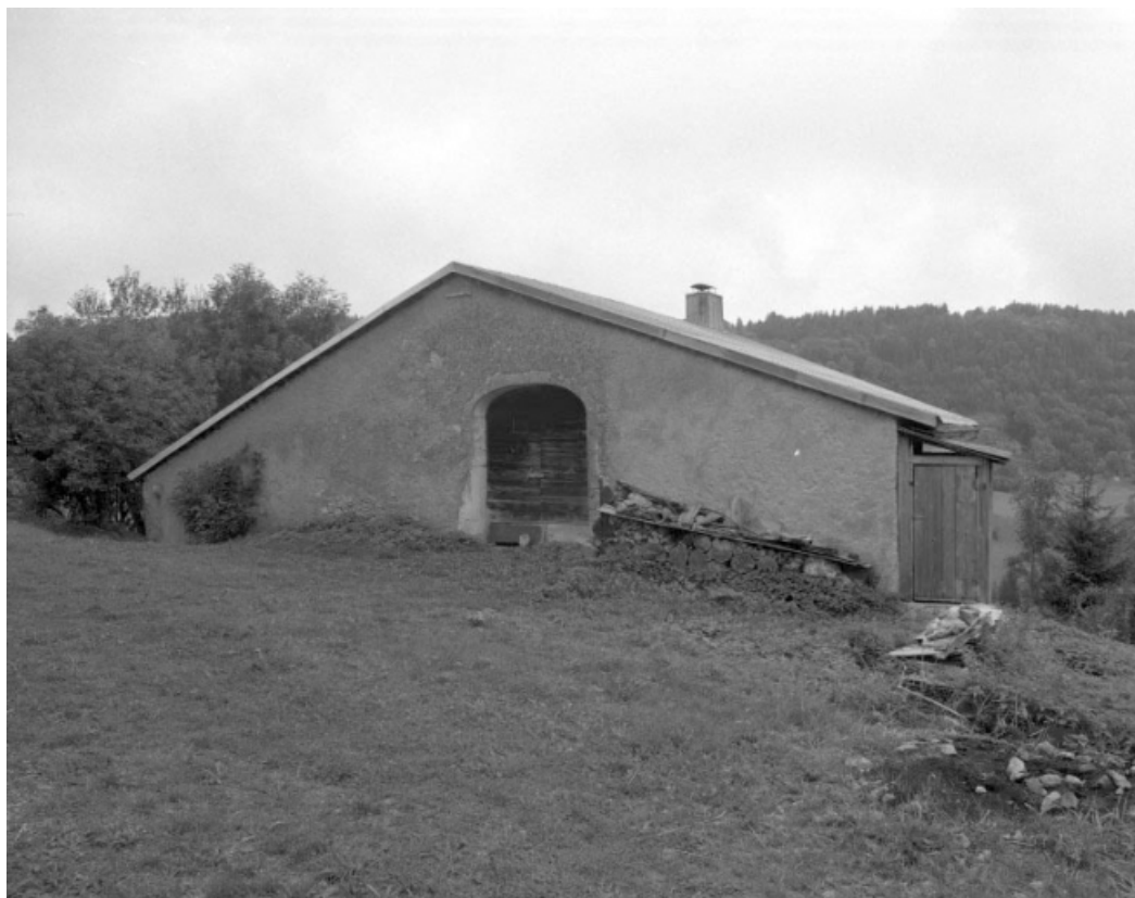
Face droite et accès à la grange haute.
