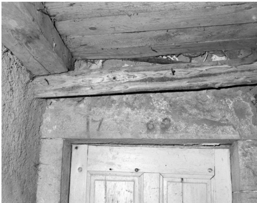
Porte d'accès au logis.
