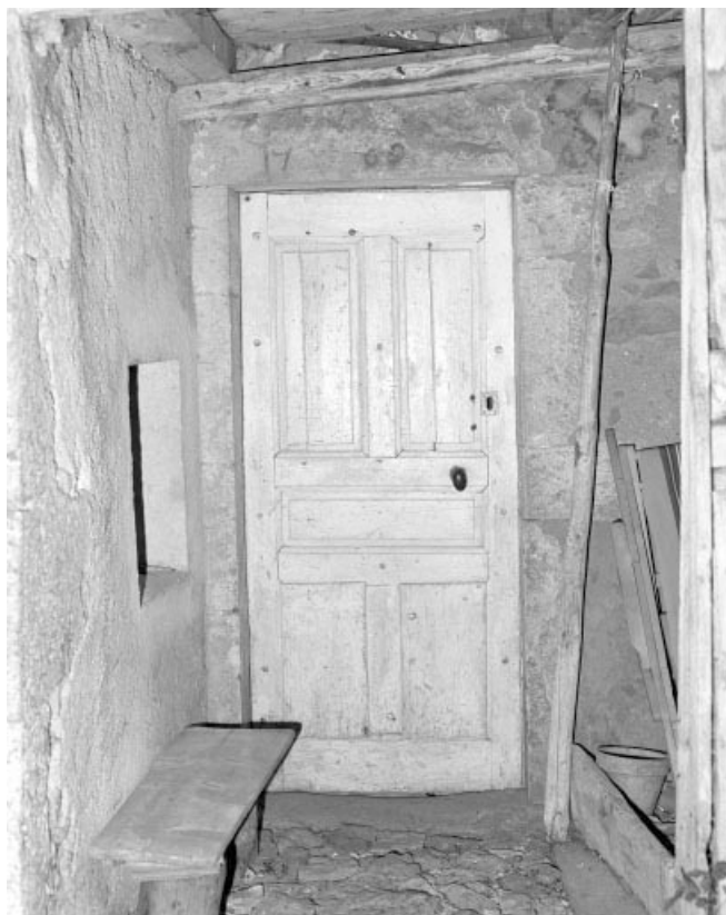
Le linteau de la porte d'accès au logis, daté 1769.
