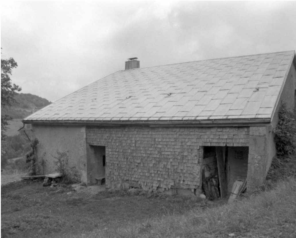
Façade antérieure avec galerie fermée en tavaillons.
