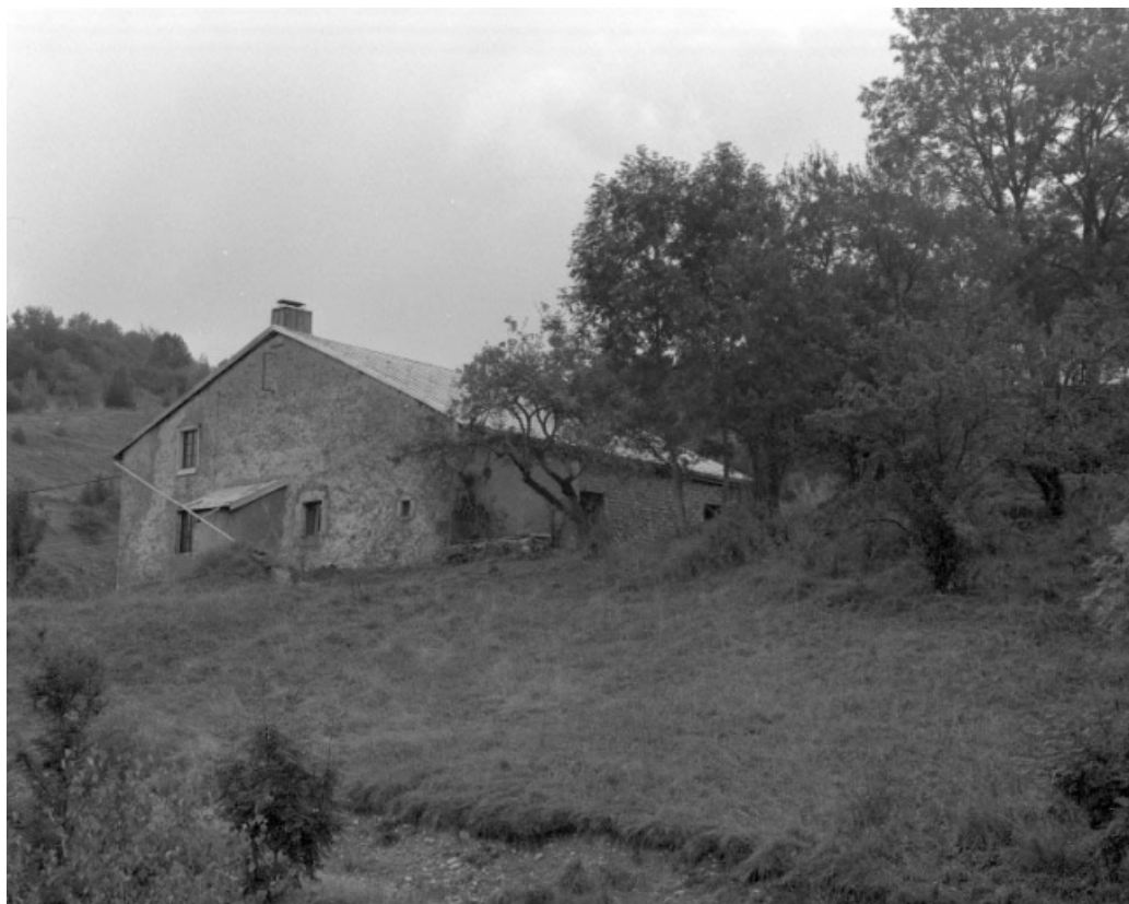
Face gauche avec son four en appentis et façade antérieure de trois quarts.
