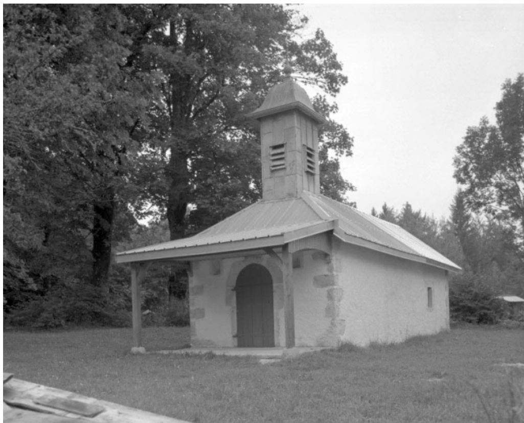
Façade antérieure de la chapelle.
