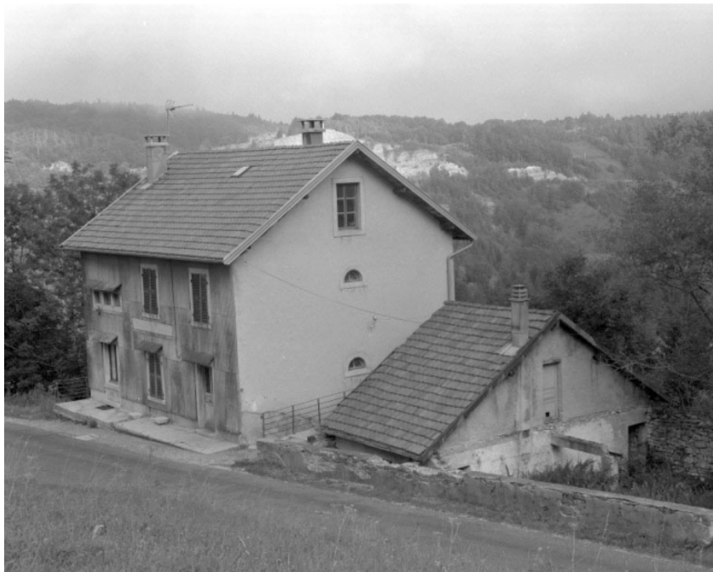
Façade antérieure et face droite de la fromagerie, en contrebas : ruines de la porcherie. 39, Les Bouchoux
