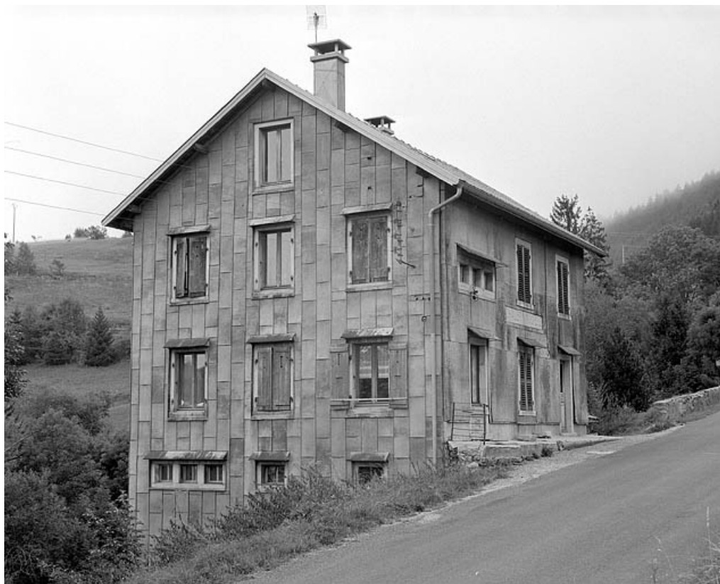
Façade antérieure et face gauche, recouvertes d'un essentage de feuilles de zinc. 39, Les Bouchoux
