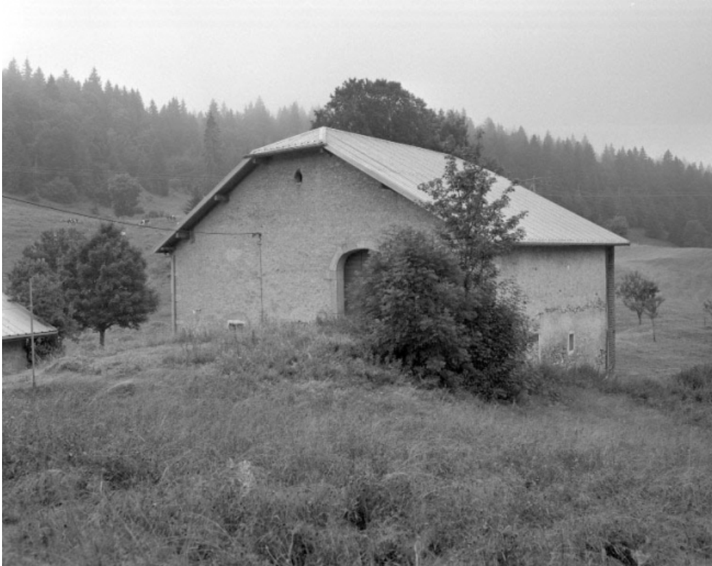
Face droite avec accès à la grange haute.
