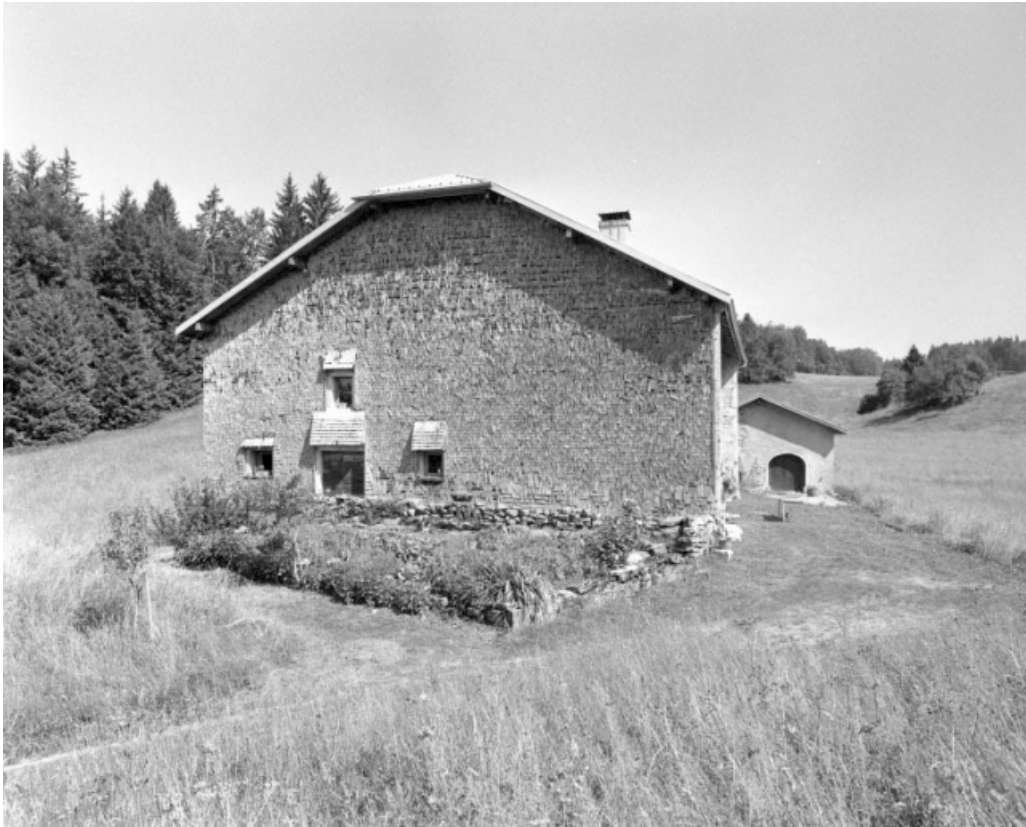
Face gauche recouverte d'un essantage de tavillons.
