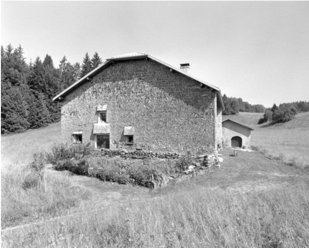
Face gauche recouverte d'un essantage de tavaillons.
