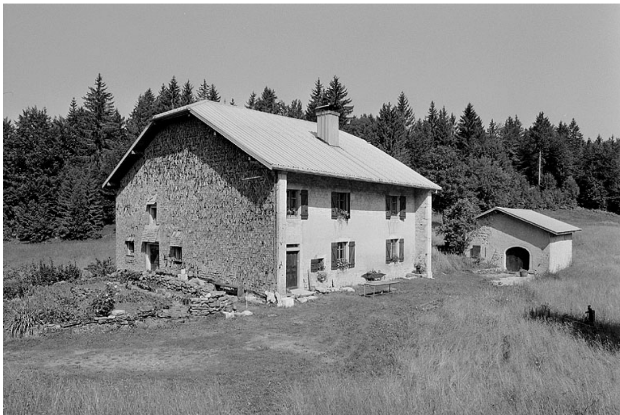
Façade antérieure et face gauche avec essentage de tavaillons. A l'arrière-plan, le fournil.
