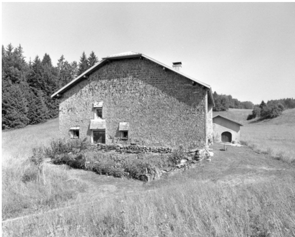
Face gauche recouverte d'un essantage de tavillons.
