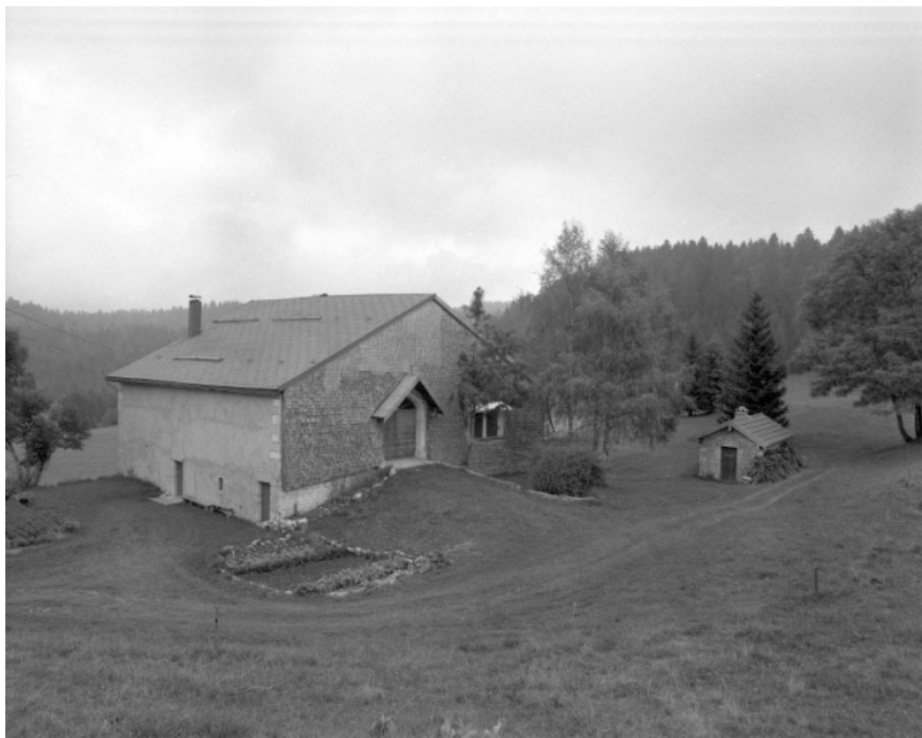
Façade postérieure et face gauche recouverte d'un essentage de tavaillons, le fournil est à droite. 39, Les Bouchoux, lieudit : sur la Roche
