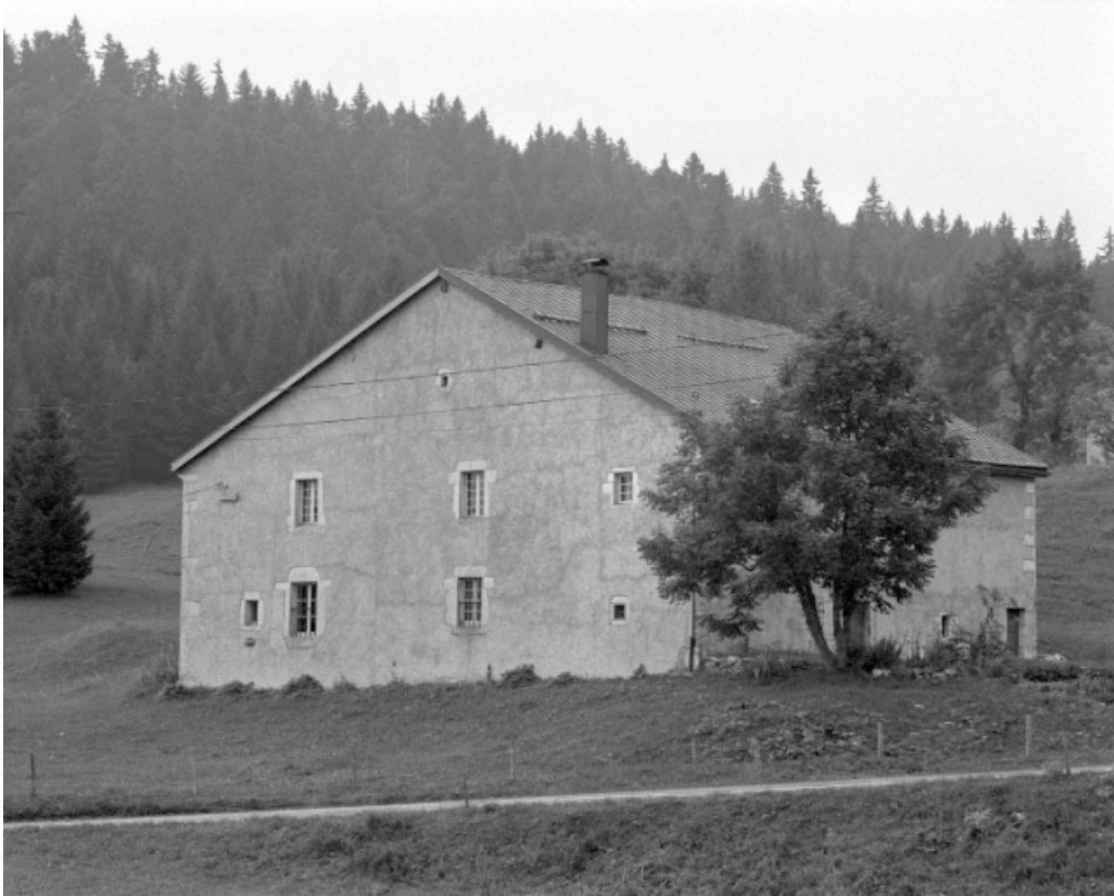
Face droite et façade postérieure.
