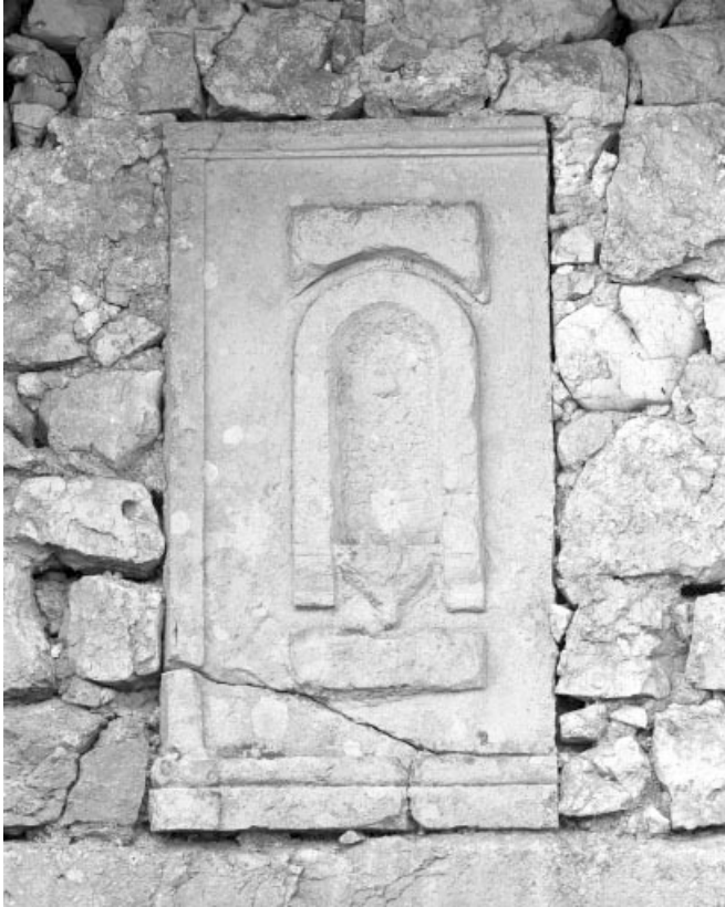
La niche au-dessus de la porte du grenier fort.
