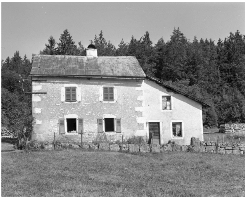
Façade antérieure de la maison de douaniers.
