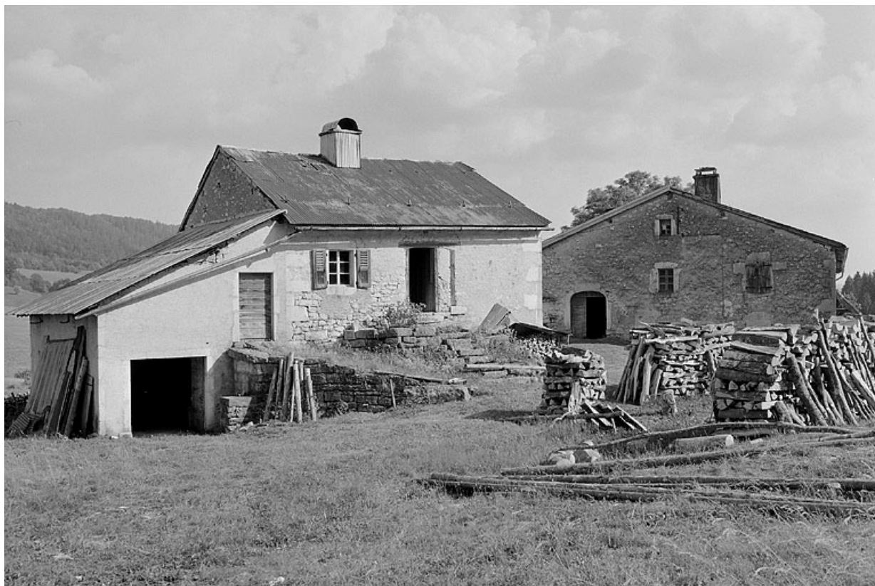
Face droite de la ferme avec au premier plan la façade postérieure de la maison de douaniers.
