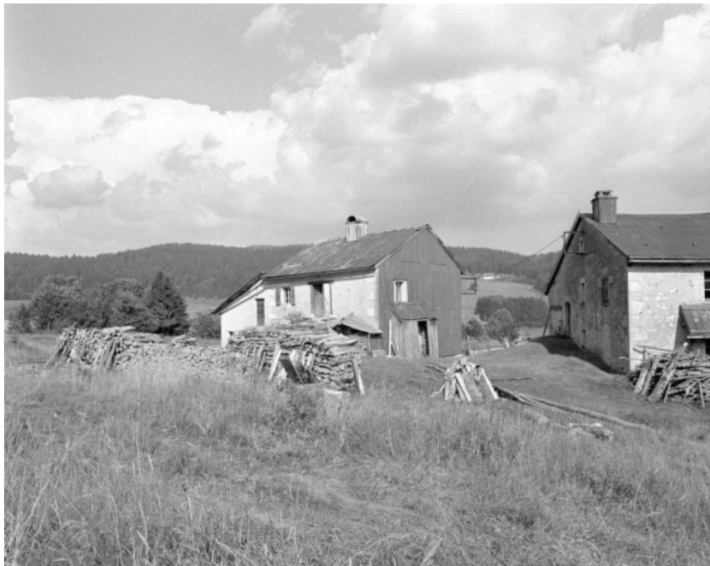
Façade postérieure et face gauche de la maison de douaniers, recouvertes d'un essentage de tôle. 39, Les Bouchoux, lieudit : en Désertin sud
