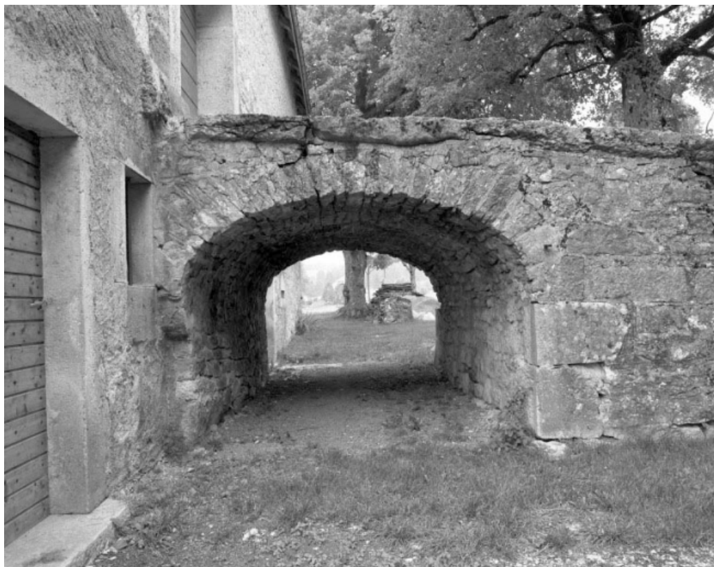
Détail du pont de grange sur la façade postérieure.
