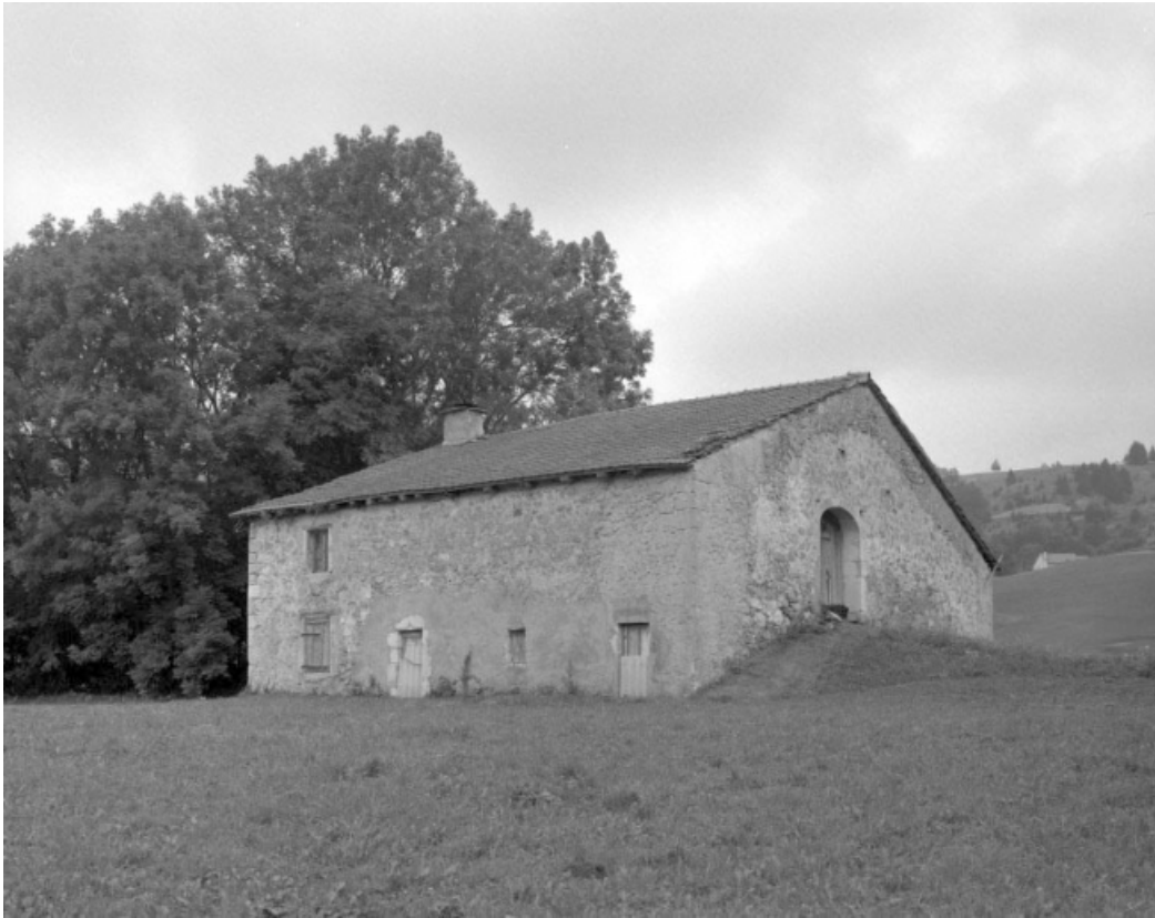
Façade postérieure et face droite.
