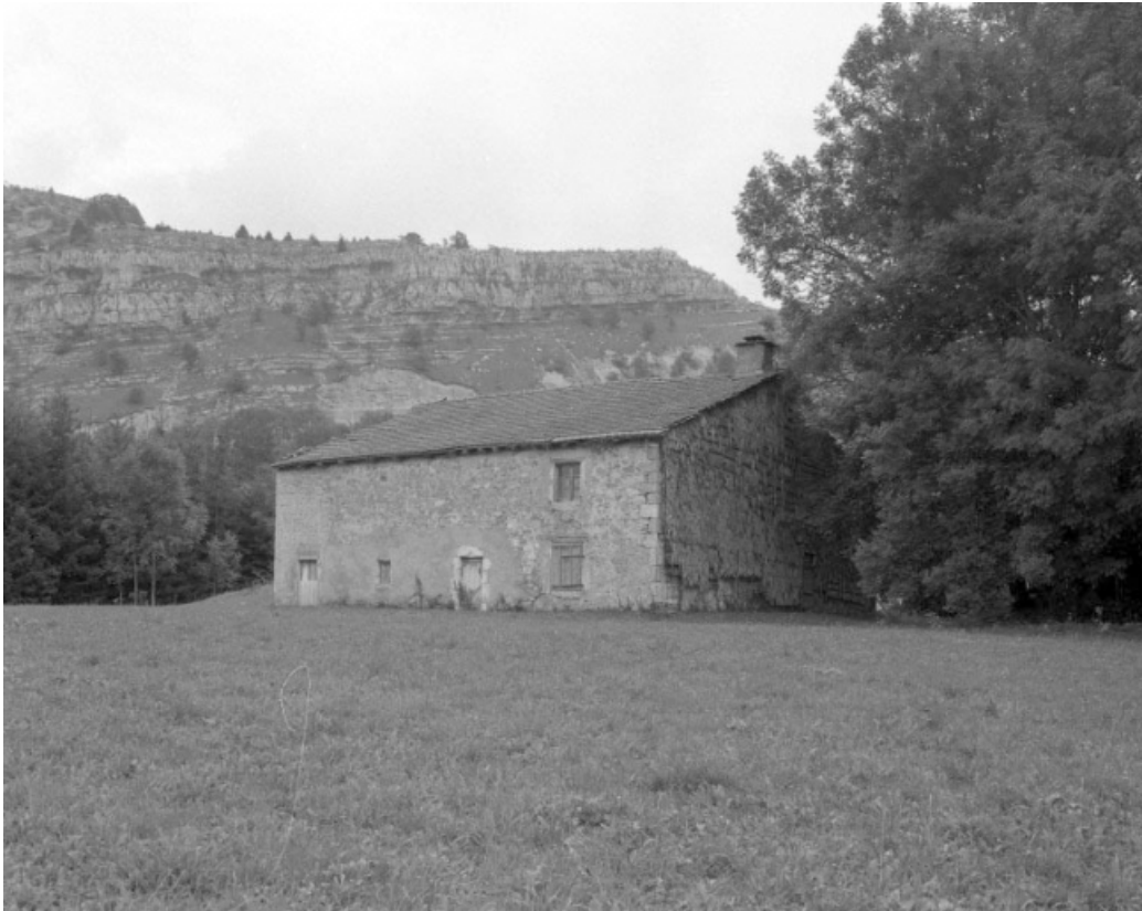
Façade postérieure et face gauche recouverte d'un essentage de tavaillons.
