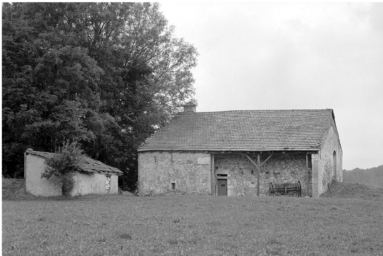
Vue générale, façade antérieure et fournil à gauche.
