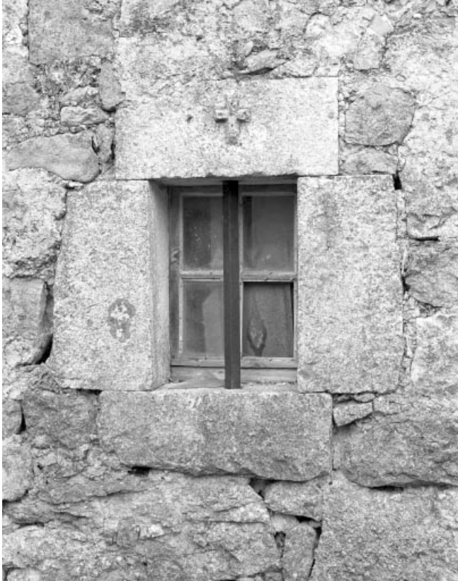
Détail de la fenêtre de la façade antérieure.
