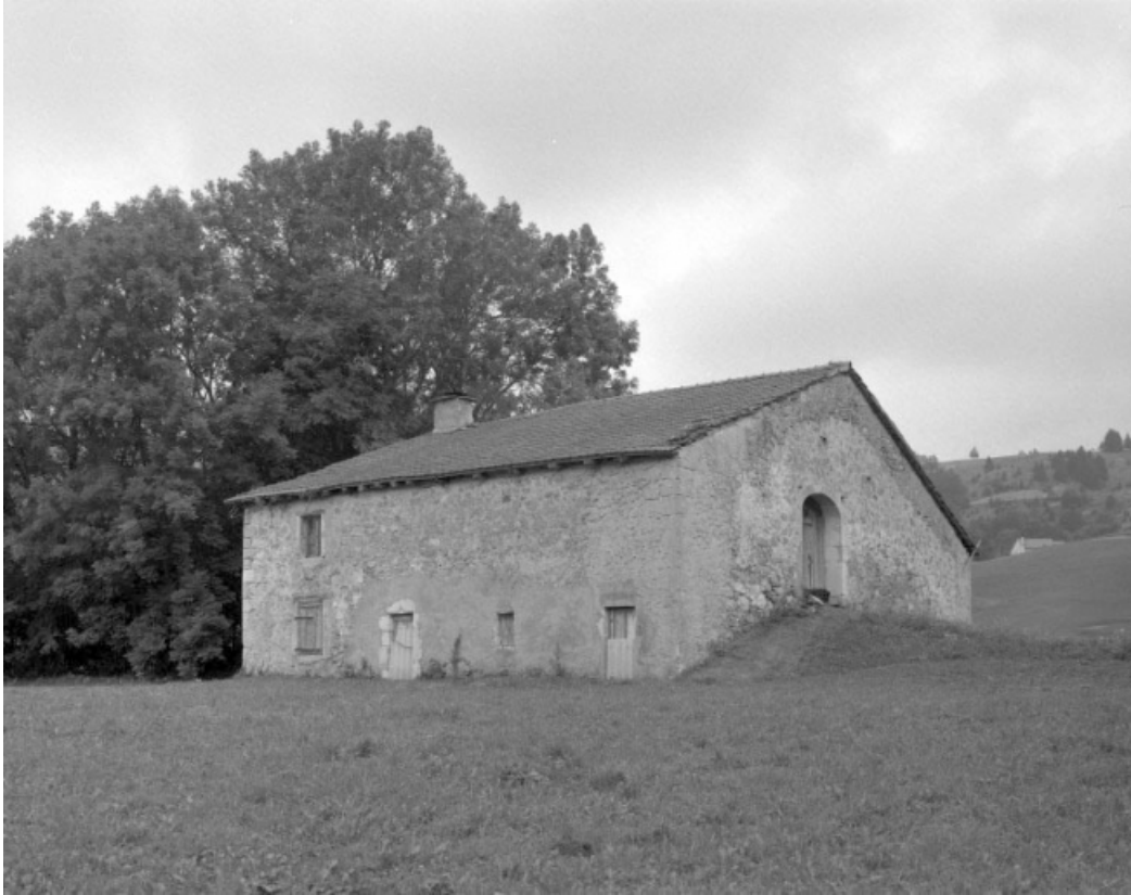
Façade postérieure et face droite.
