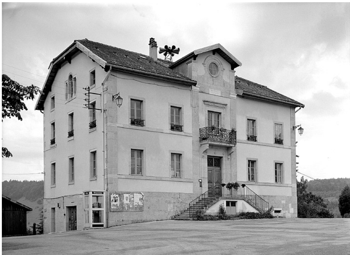
Façade antérieure et face droite.
