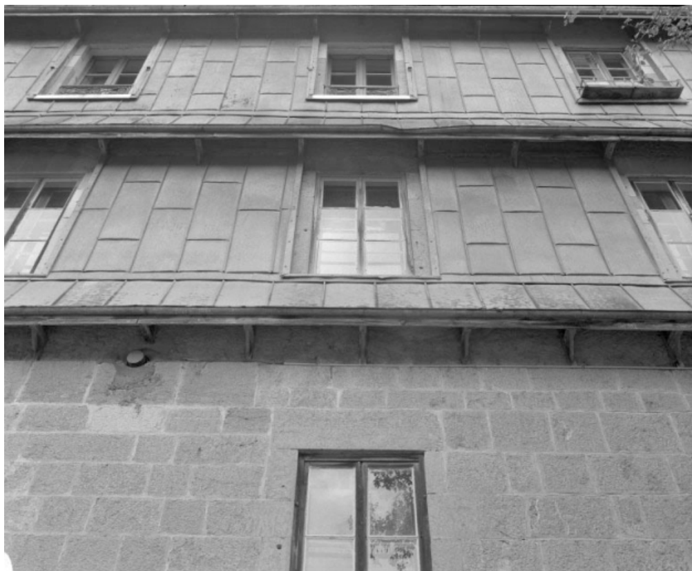
Détail des auvents en zinc de la façade postérieure.
