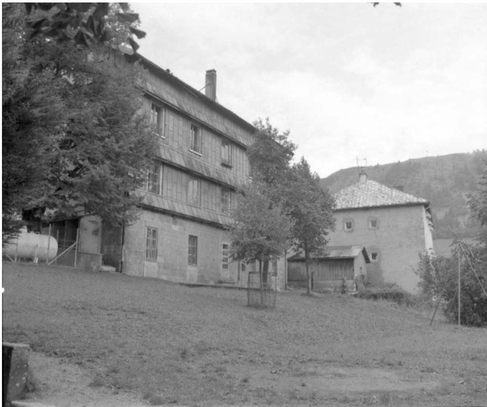
Façade postérieure couverte d'un essentage en feuilles de zinc. 39, Les Bouchoux
