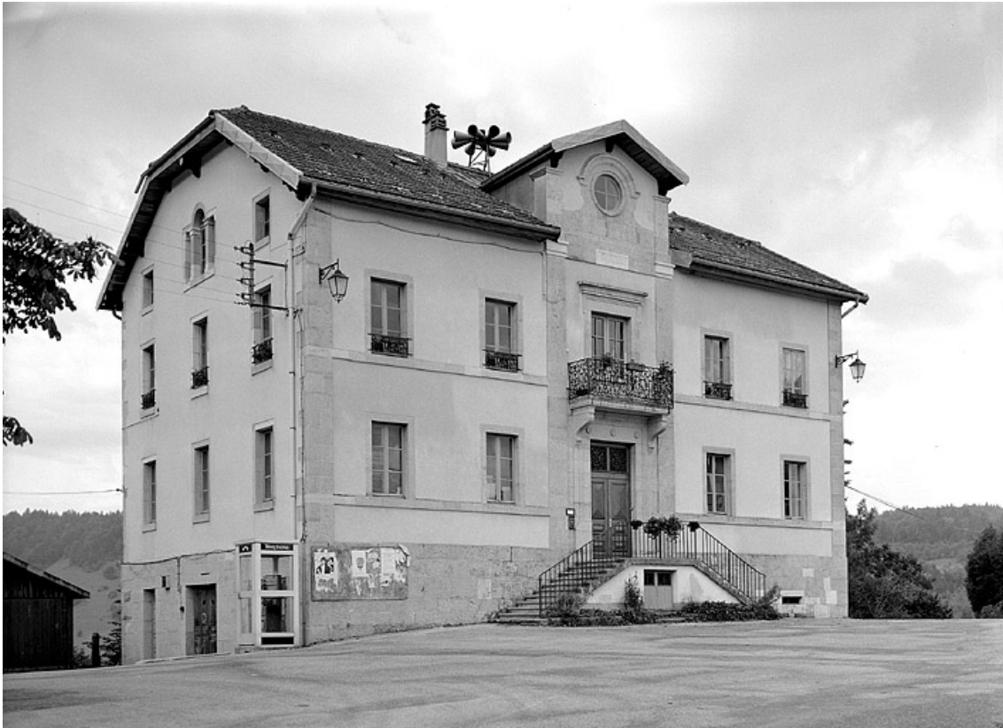
Façade antérieure et face droite.
