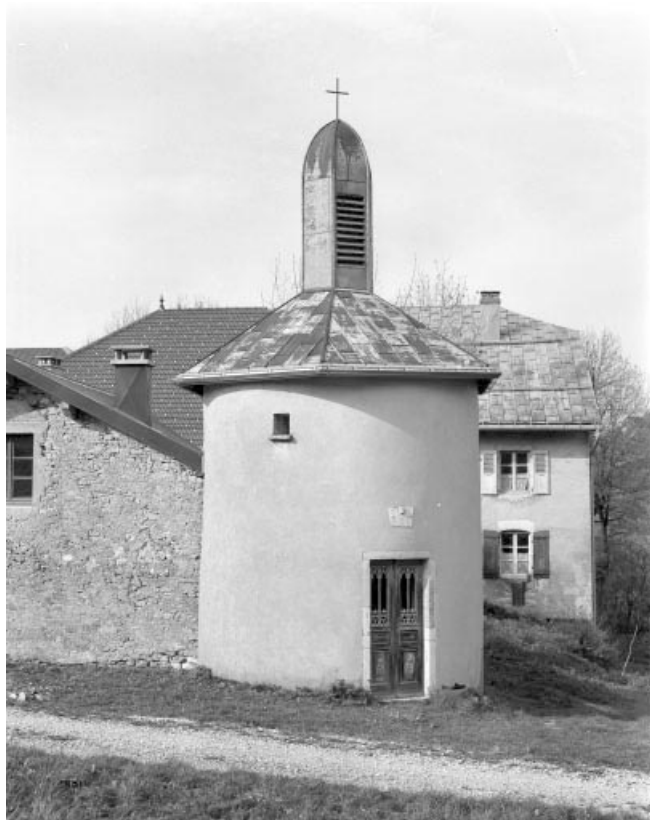
Tour transformée en oratoire.
