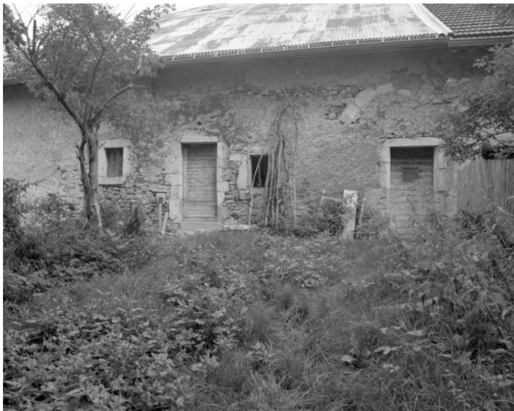
Façade nord-ouest, arrière de la partie utilisée comme ferme.
