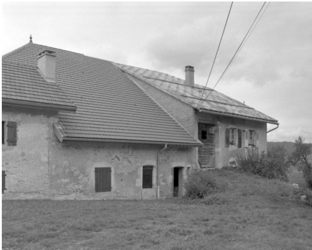
Façade sud-est, vue rapprochée avec trace du réhaussement de la partie occupée aujourd'hui par la ferme.
