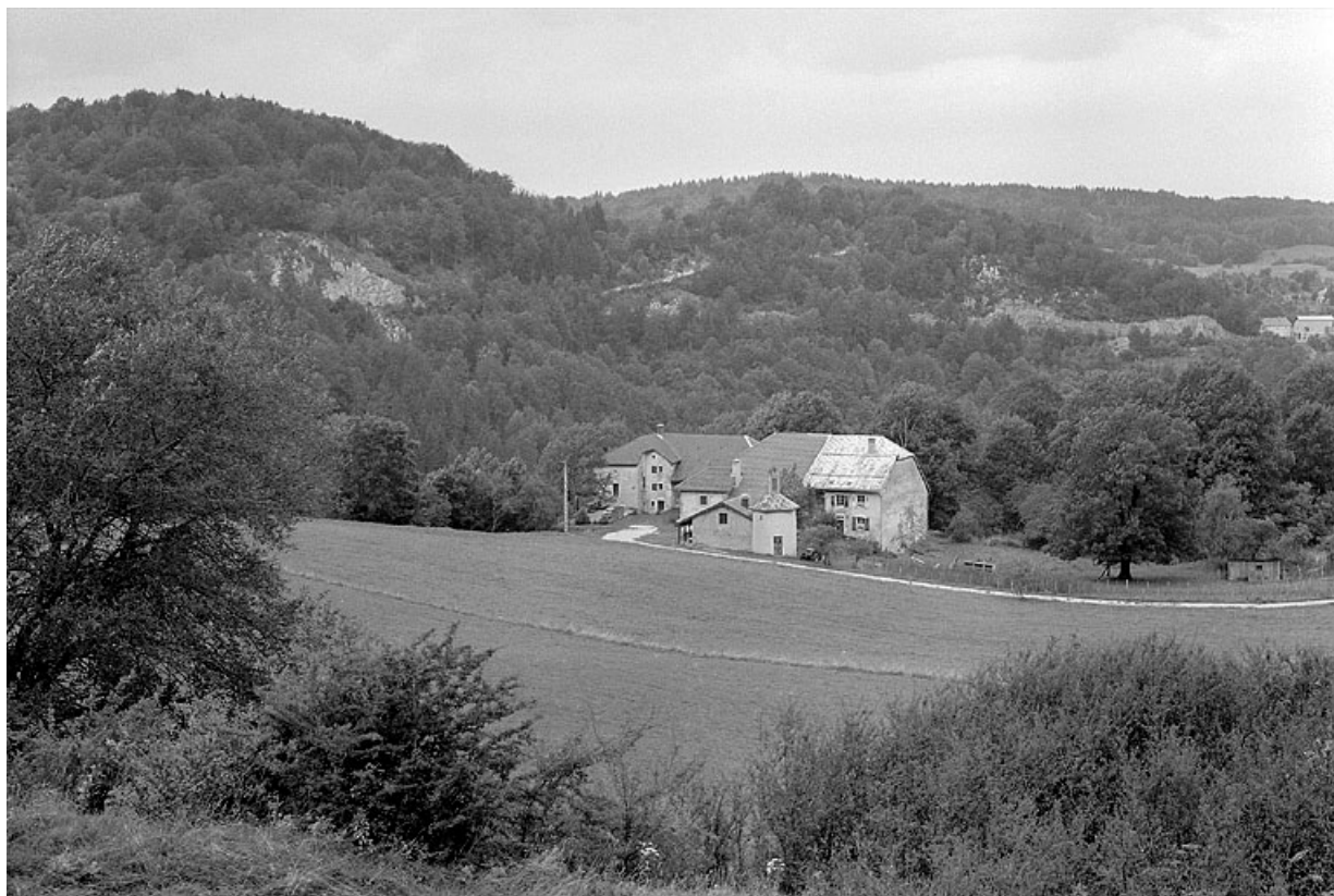
Vue générale, façade sud-est.
