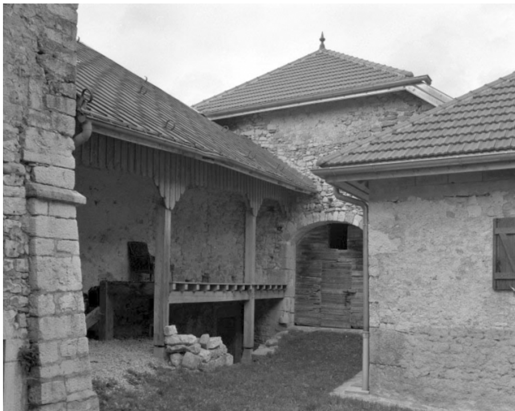
Accès à la grange avec en contrebas un accès à une cave.
