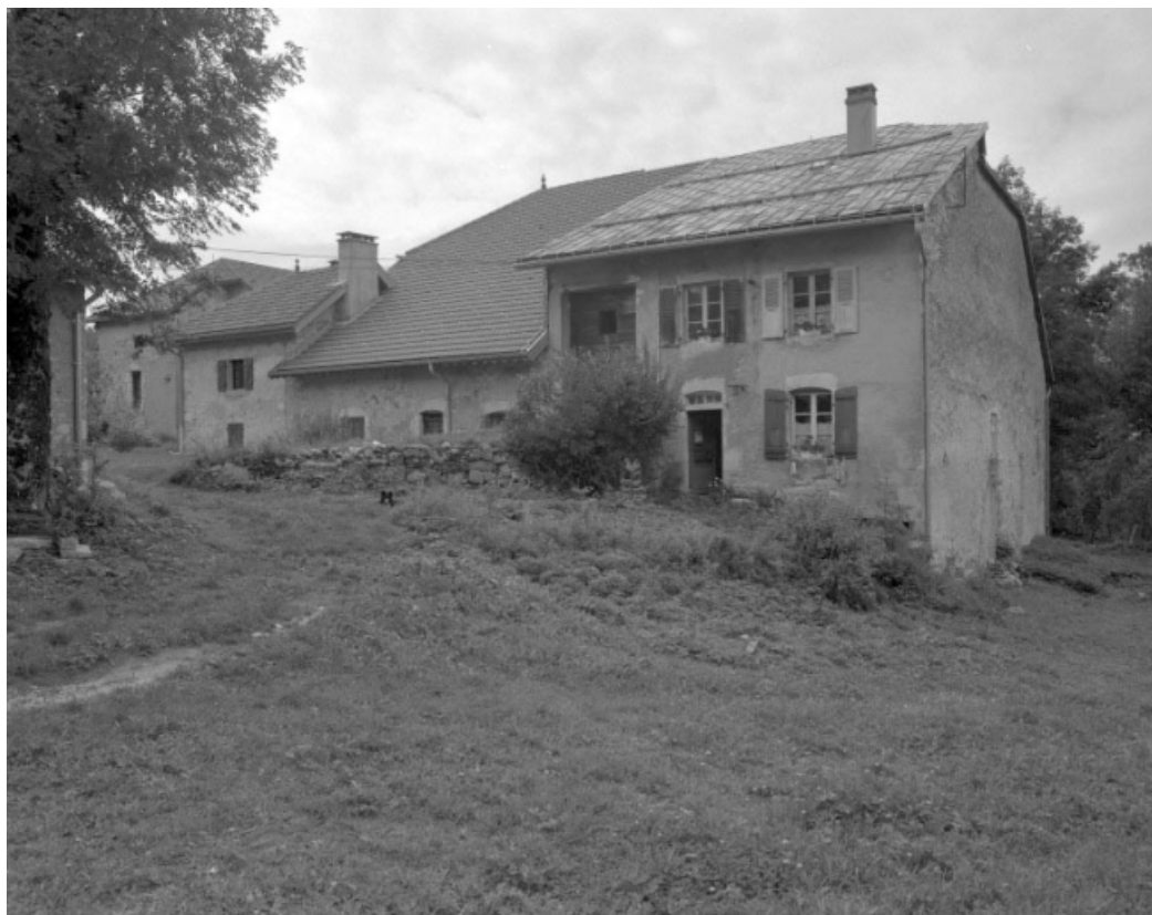
Ensemble de la façade sud-est avec à l'extrême droite la partie de l'édifice utilisée comme ferme aujourd'hui.
