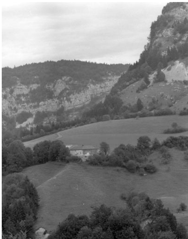
Vue générale, façade nord-ouest.
