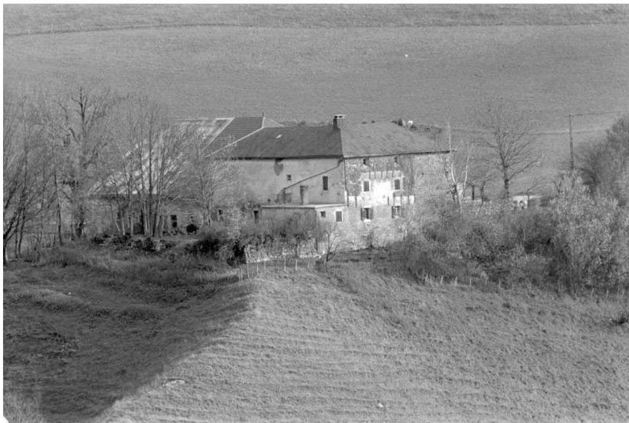
Vue rapprochée de la façade nord-ouest.
