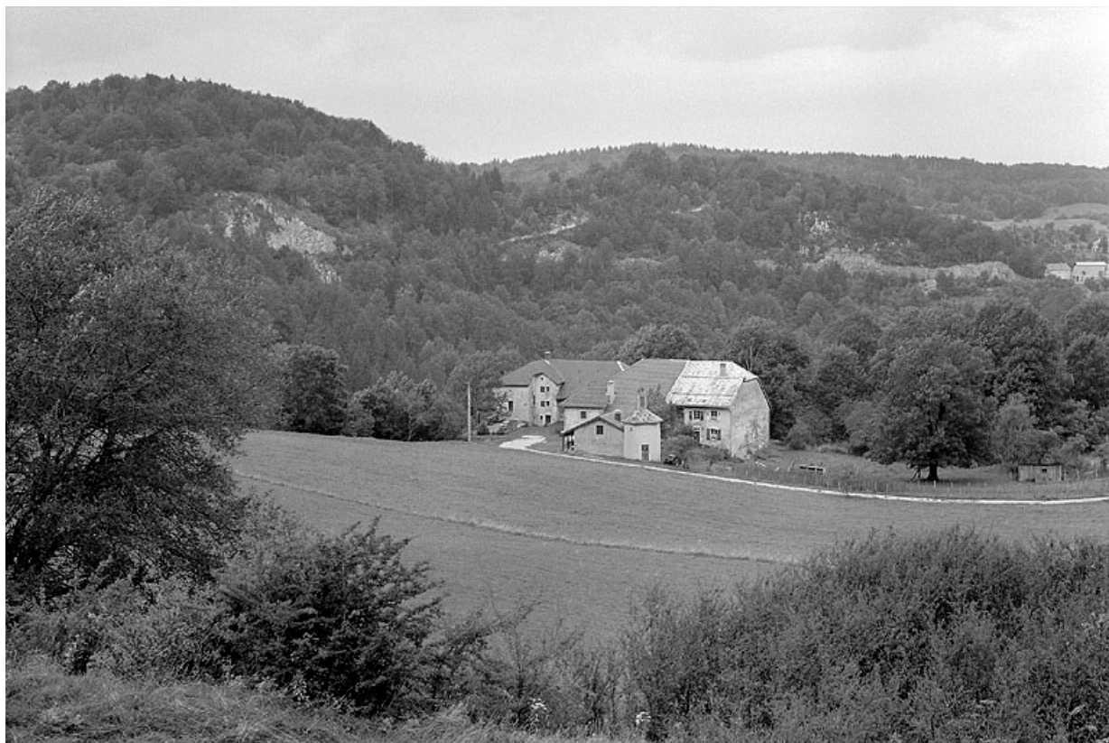
Vue générale, façade sud-est.
