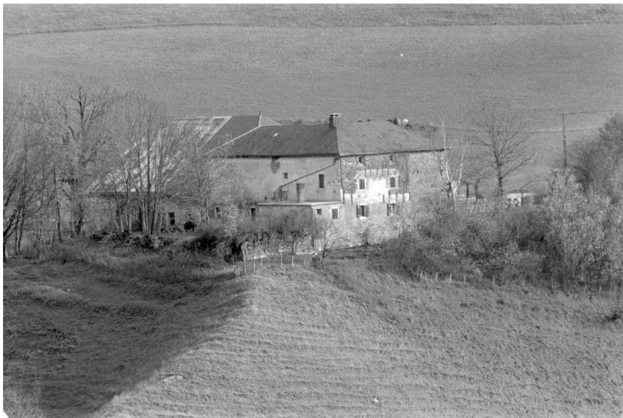
Vue rapprochée de la façade nord-ouest.
