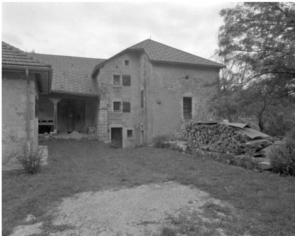
Façade sud-est, partie gauche du bâtiment.
