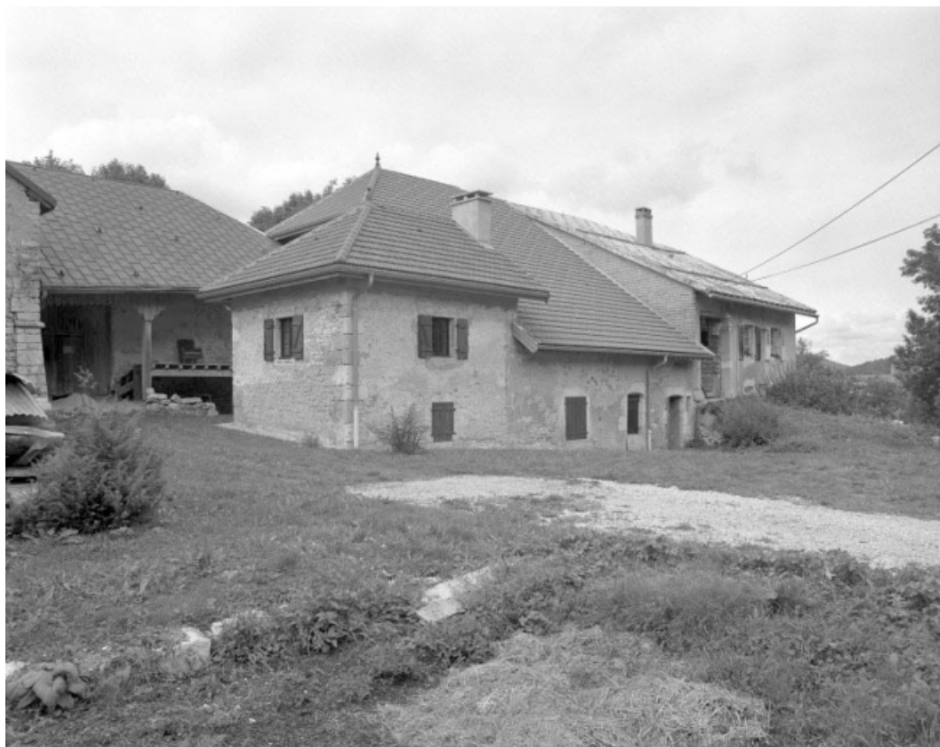
Façade sud-est, corps central du bâtiment dont une partie a été réhaussée.
