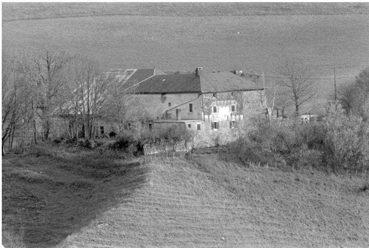
Vue rapprochée de la façade nord-ouest.
