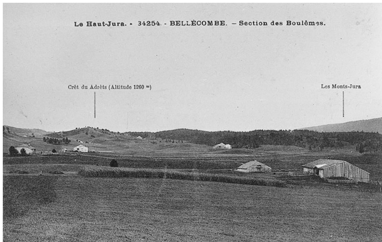
Vue générale de la section des Boulèmes. 39, Bellecombe
