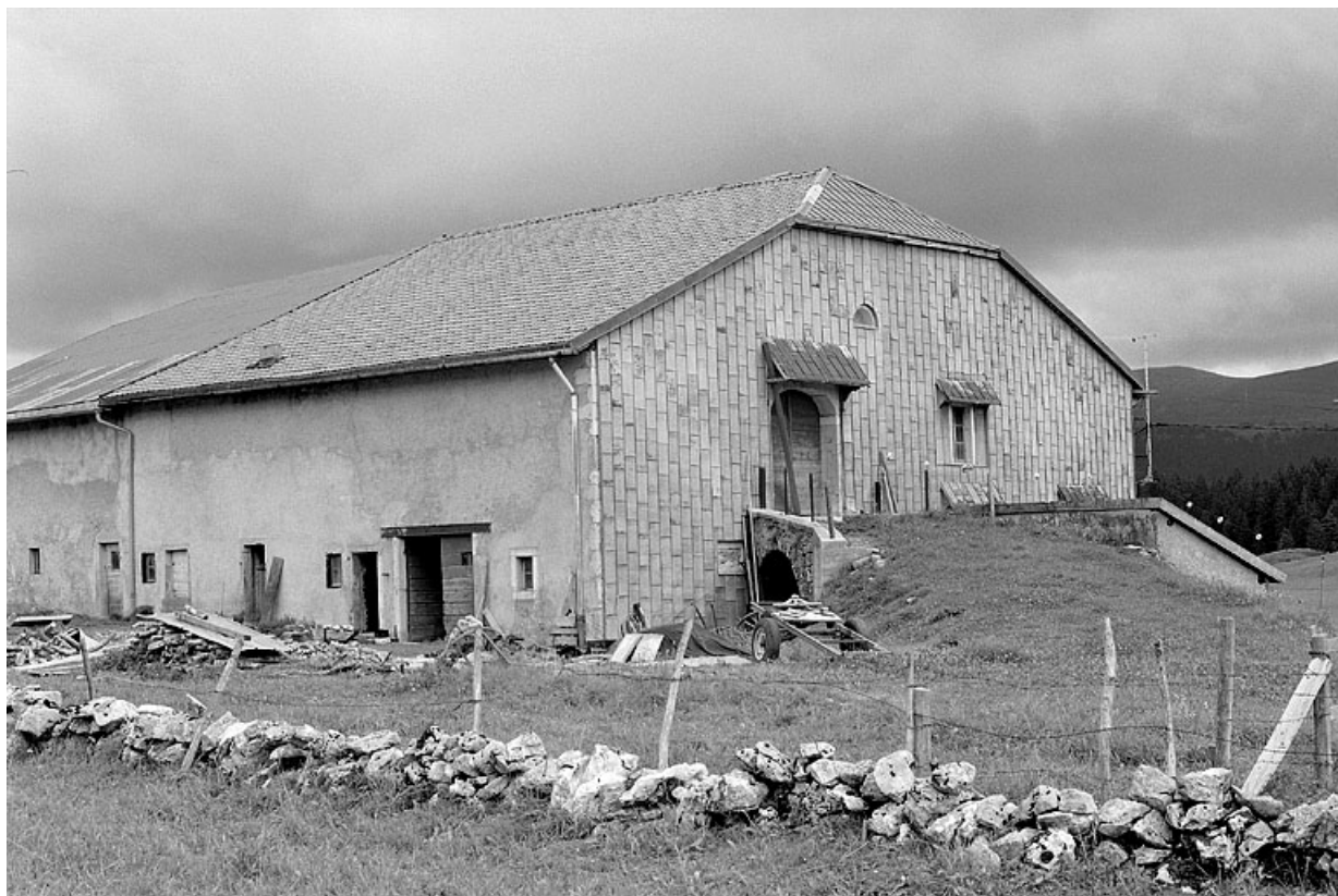
Façade postérieure et face gauche recouverte d'un essentage de zinc.
