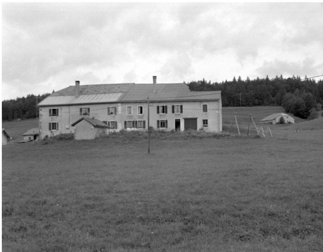
Vue générale des deux fermes mitoyennes et du fournil.
