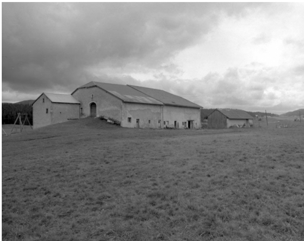
Façade postérieure des deux fermes mitoyennes.
