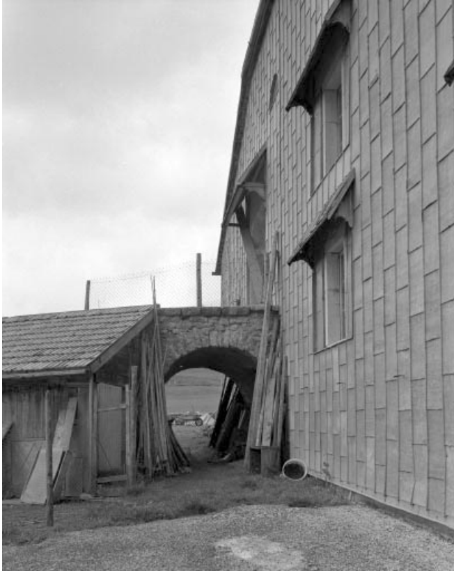
Détail de la face gauche avec pont de grange.
