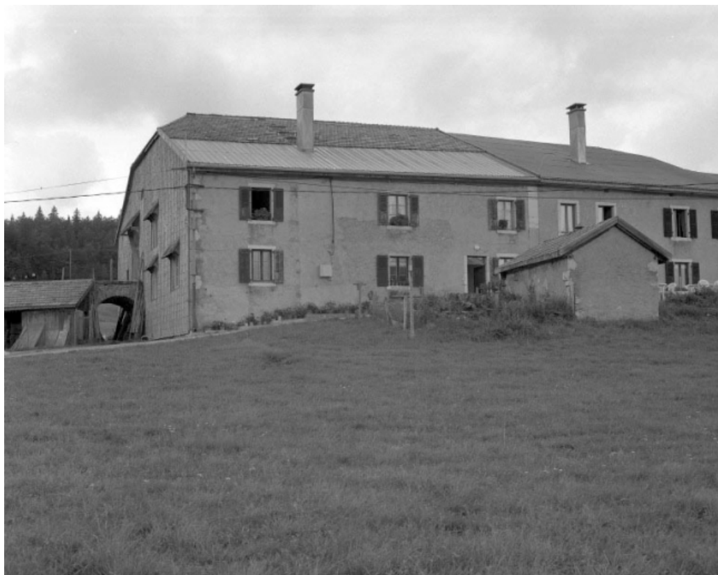
Façade antérieure, fournil au premier plan et pont de grange sur la face gauche. 39, Bellecombe, lieudit : à Boulème
