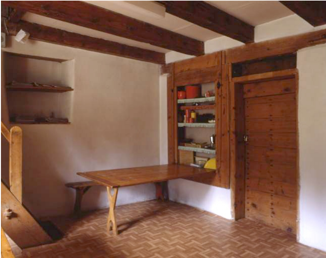
Intérieur du second logement, placard formant la table, ouvert.
