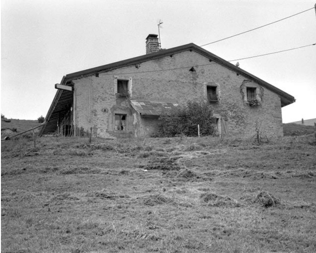
Face droite avec four en appentis.
