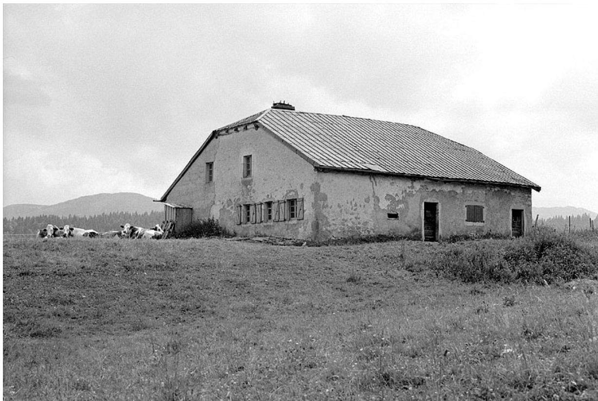
Façade postérieure et face droite.
