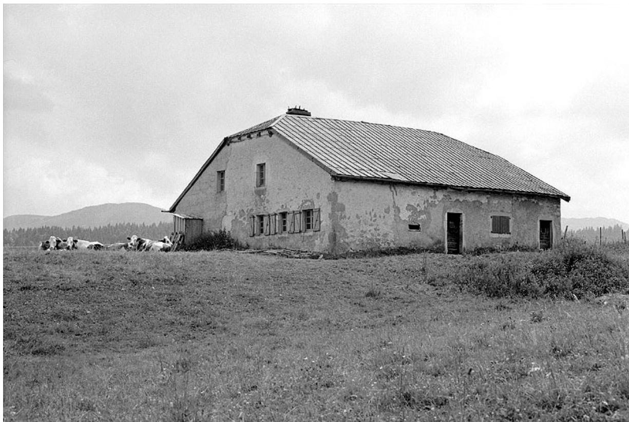
Façade postérieure et face droite.
