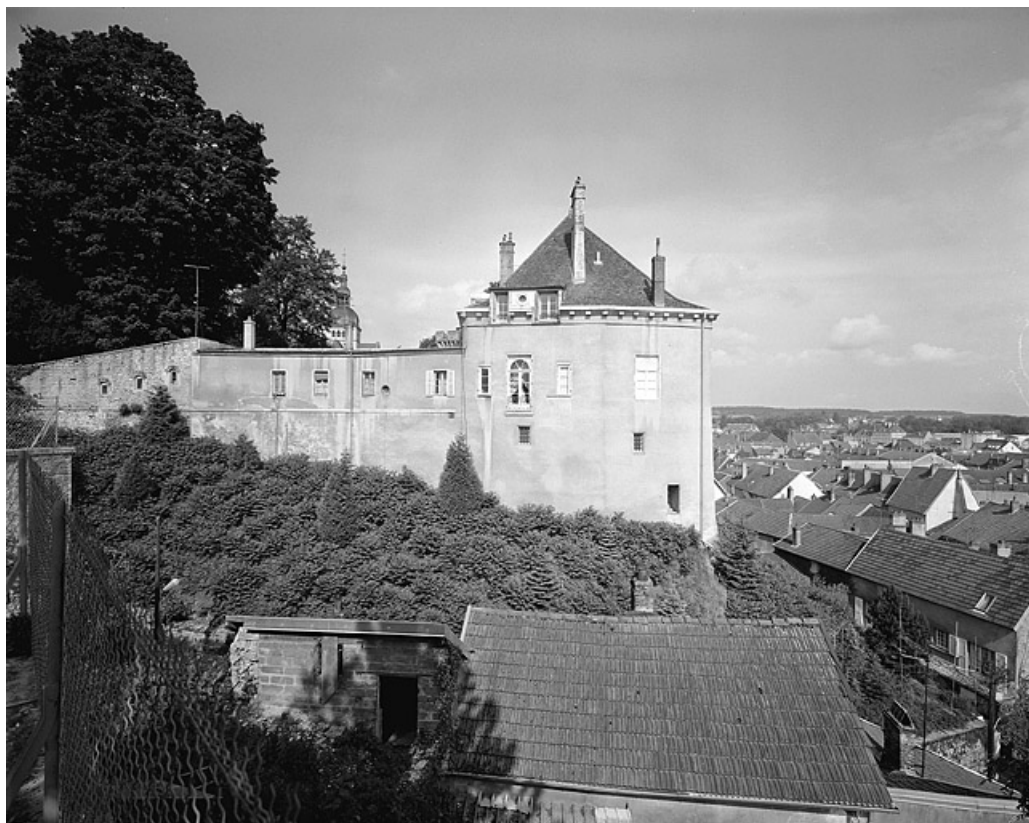
Vue d'ensemble depuis la rue du Tertre du Palais.
