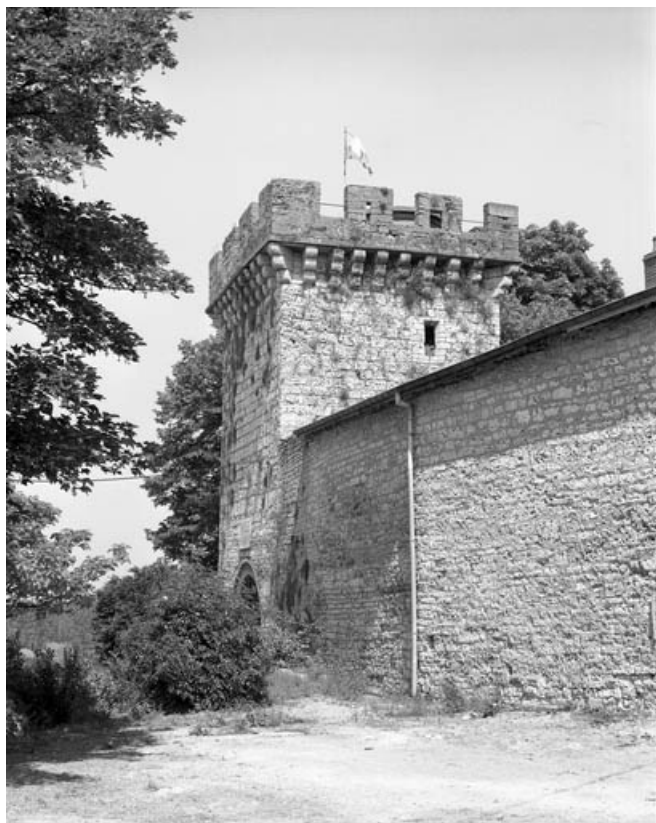
Ouvrage d'entrée, dit tour du Paravis : de trois quarts droit.
