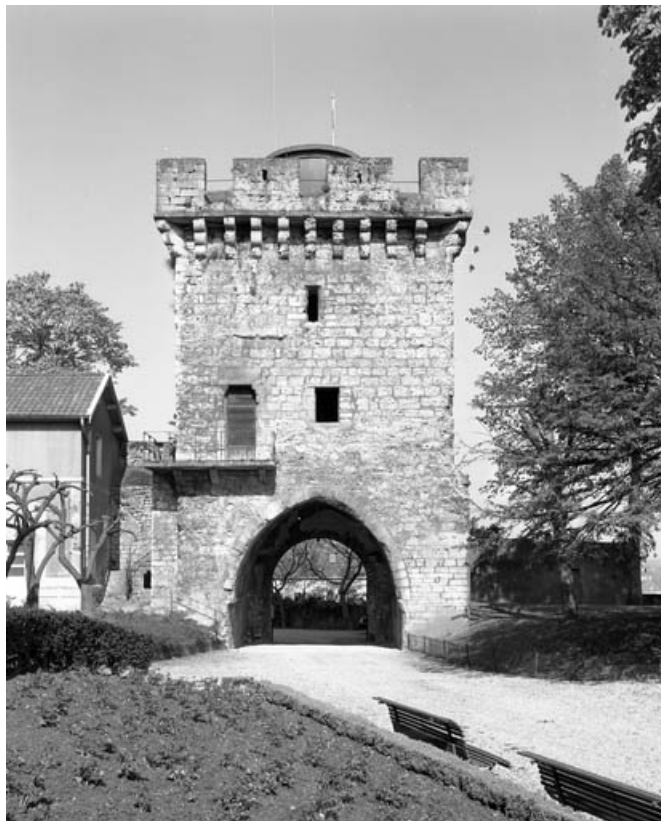
Ouvrage d'entrée, dit tour du Paravis : de face, depuis le parc du musée.
