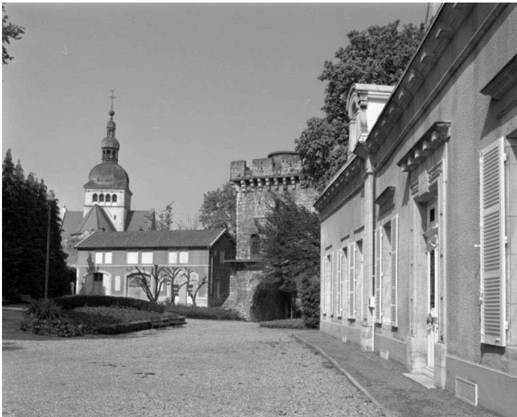
Vue de la cour avec remise et tour du Paravis à l'arrière-plan.
