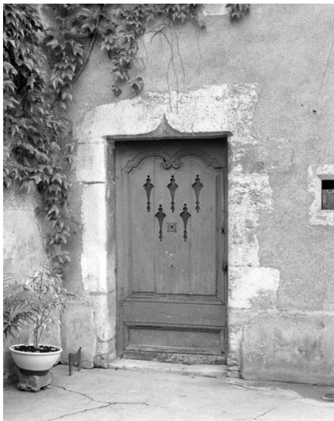
Tour Saint Pierre Fourier : détail de la porte d'entrée sur cour. 70, Gray, 4, 6, 8 rue du Marché
