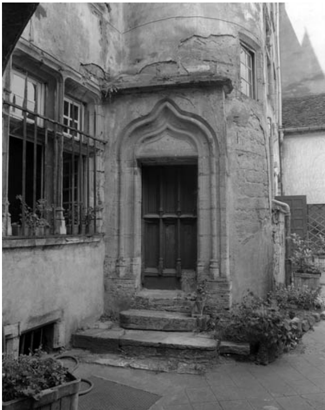
Façade sur cour : partie droite, détail de la porte de l'escalier en vis. 70, Gray, 4, 6, 8 rue du Marché
