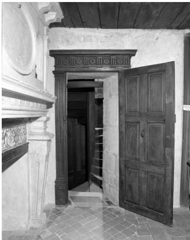
Cellule de saint Pierre Fourier, porte ouverte montrant l'accès à l'escalier pivotant. 70, Gray, 4, 6, 8 rue du Marché
