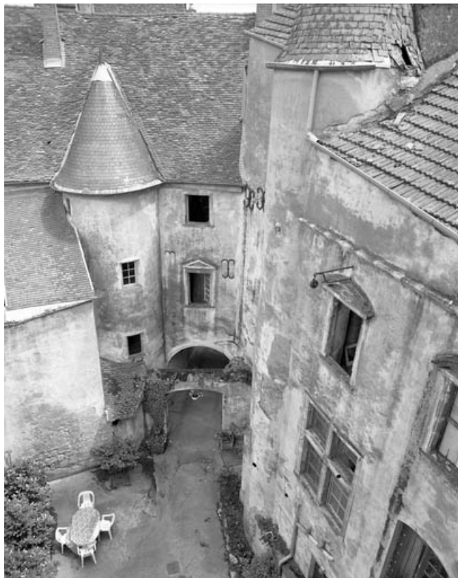
Bâtiment droit : vue plongeante depuis la cellule de saint Pierre Fourier. 70, Gray, 4, 6, 8 rue du Marché
