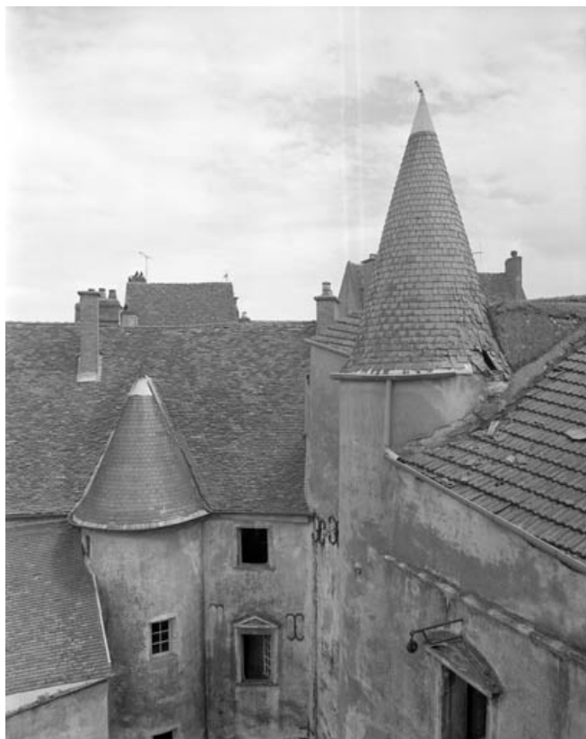
Bâtiment droit : vue des toitures, depuis la cellule de saint Pierre Fourier. 70, Gray, 4, 6, 8 rue du Marché
