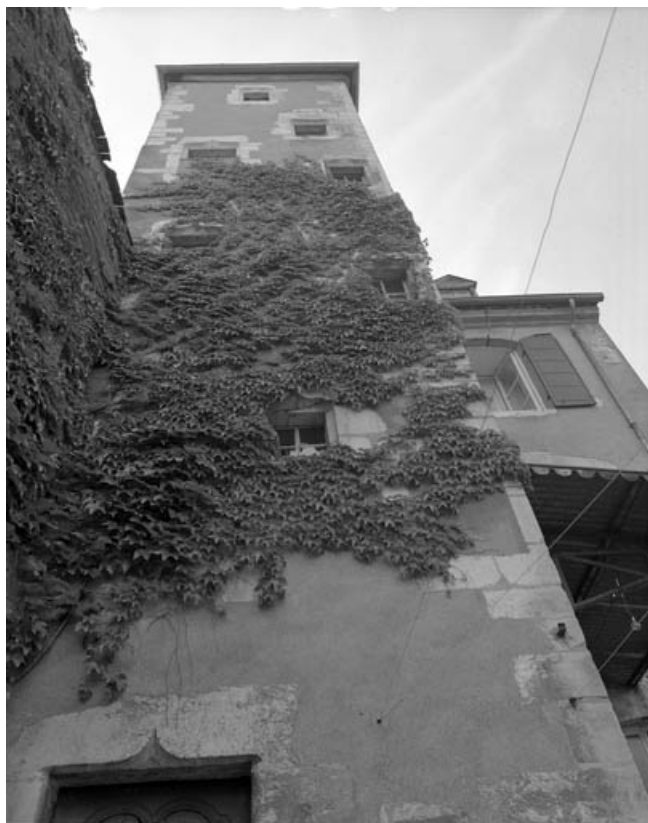
Détail de la tour Saint Pierre Fourier, vue en contre-plongée. 70, Gray, 4, 6, 8 rue du Marché
