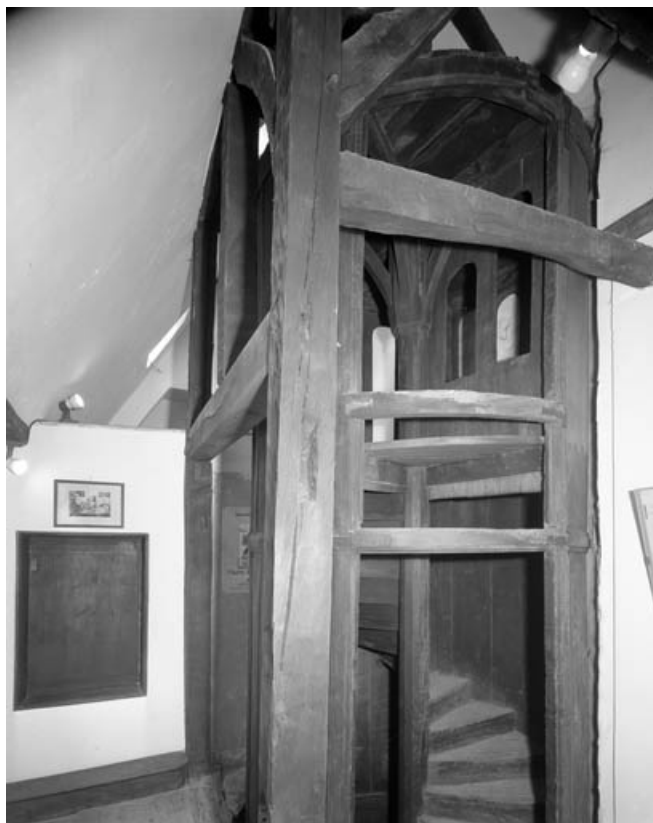
Détail du cylindre pivotant sommet compris, vu au niveau de la cellule de saint Pierre Fourier. 70, Gray, 4, 6, 8 rue du Marché
