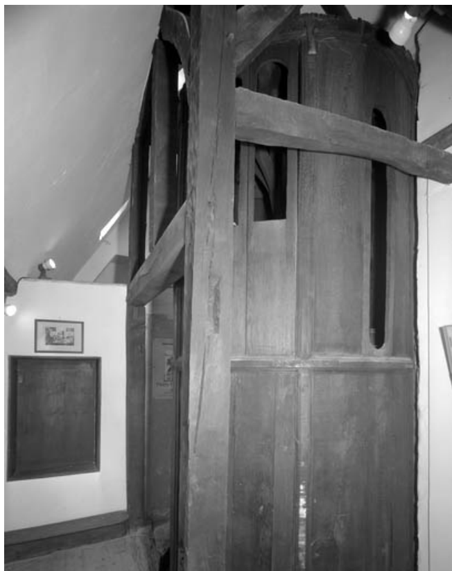
Détail du cylindre pivotant fermé, vu au niveau de la cellule de saint Pierre Fourier. 70, Gray, 4, 6, 8 rue du Marché
