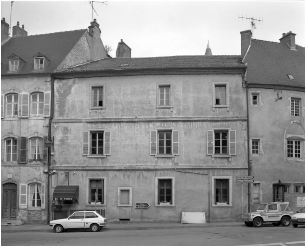
Bâtiment central : façade antérieure, de face.
