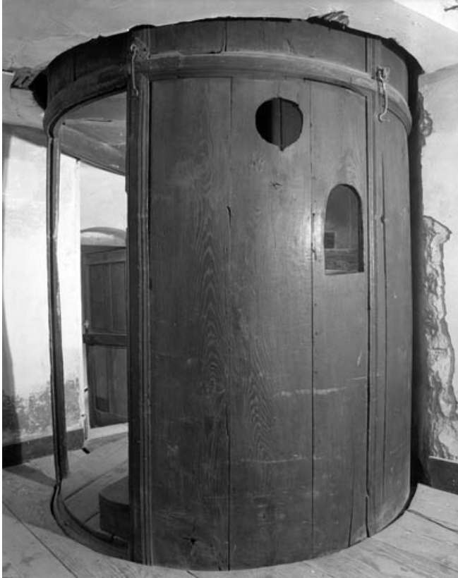
Détail du rez-de-chaussée du cylindre pivotant contenant l'escalier : partie pleine. 70, Gray, 4, 6, 8 rue du Marché
