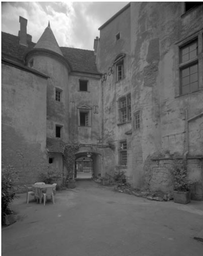
Bâtiment droit : vue du passage couvert depuis le fond de la cour intérieure. 70, Gray, 4, 6, 8 rue du Marché
