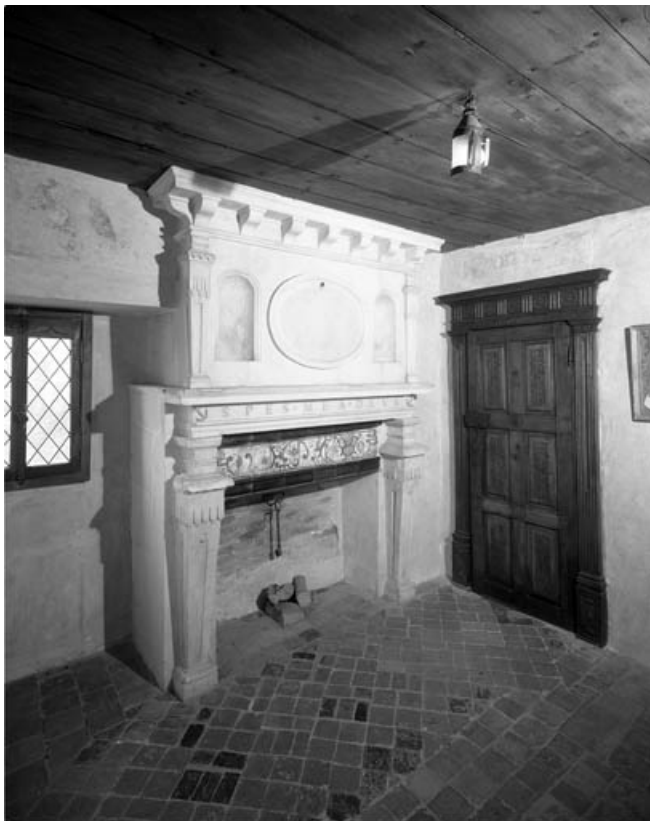
Cellule de saint Pierre Fourier : détail de la cheminée.
