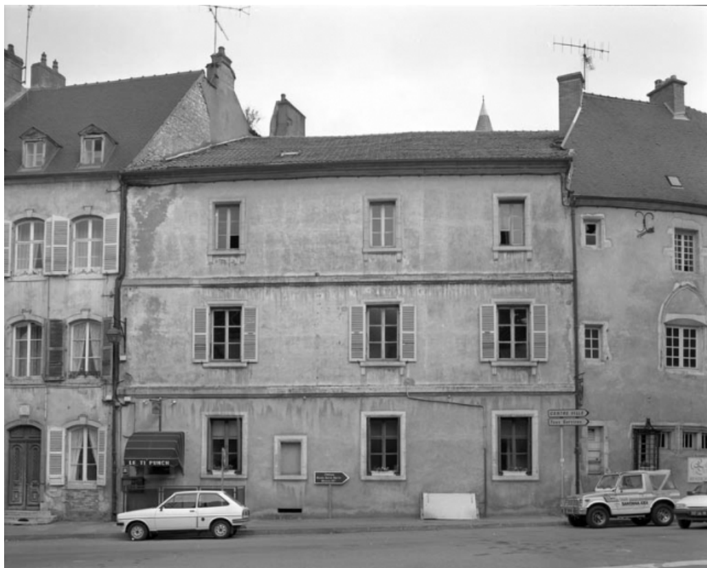
Bâtiment central : façade antérieure, de face.
