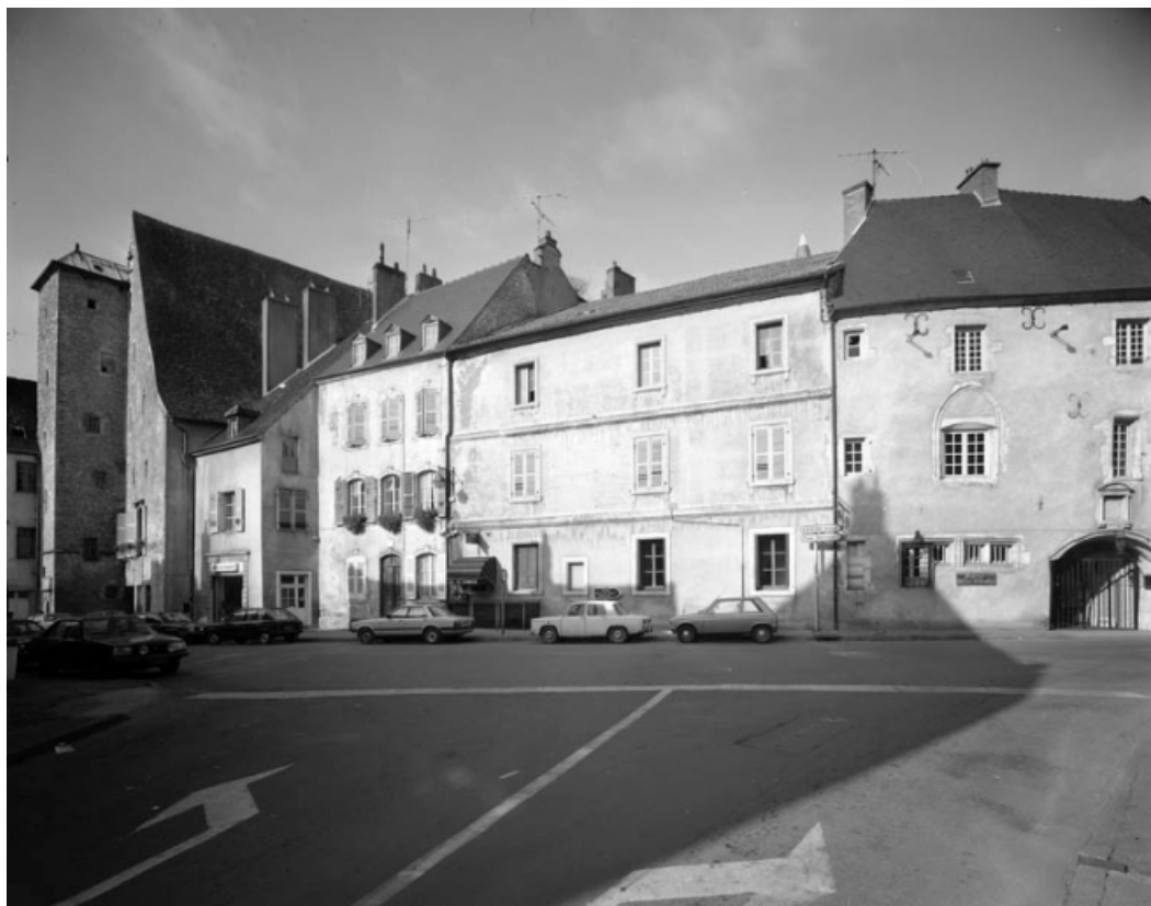
Vue d'ensemble des façades antérieures constituant l'ancien hôtel Gauthiot d'Ancier. 70, Gray, 4, 6, 8 rue du Marché
