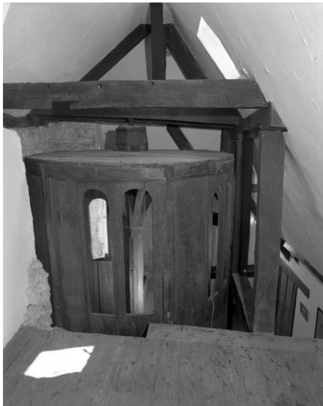
Sommet du cylindre depuis les combles.
