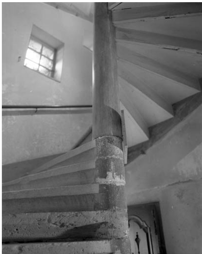
Tour Saint Pierre Fourier : détail de l'escalier en vis, en pierre puis en bois donnant accès à l'escalier pivotant. 70, Gray, 4, 6, 8 rue du Marché
