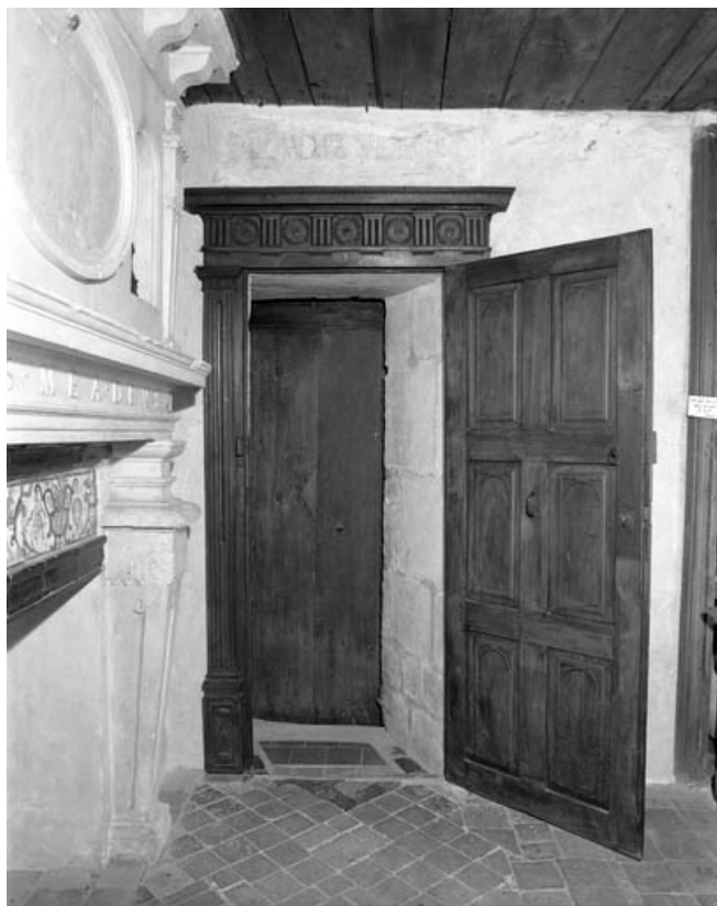
Cellule de saint Pierre Fourier, porte ouverte avec cylindre pivotant présentant sa face pleine. 70, Gray, 4, 6, 8 rue du Marché
