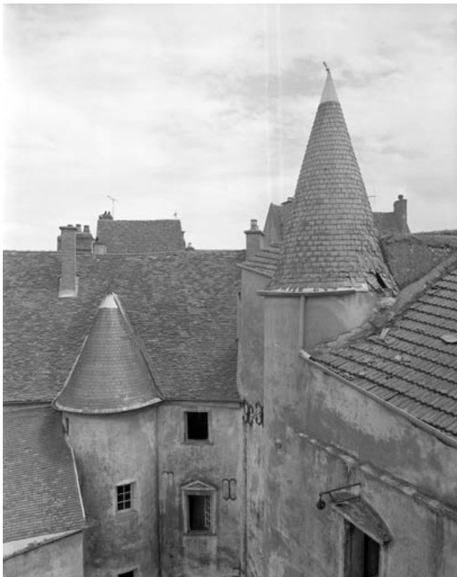
Bâtiment droit : vue des toitures, depuis la cellule de saint Pierre Fourier. 70, Gray, 4, 6, 8 rue du Marché
