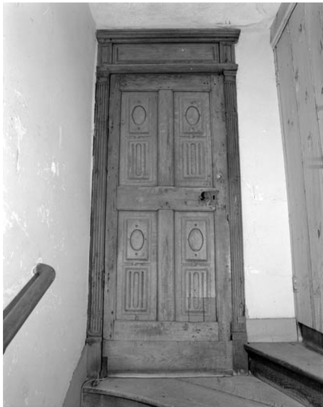
Porte d'entrée masquant l'escalier pivotant en bois.
