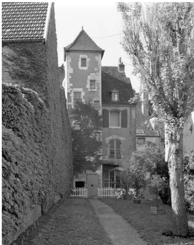
Façade postérieure du n° 8 de la rue du Marché, avec la tour Saint Pierre Fourier : vue rapprochée. 70, Gray, 4, 6, 8 rue du Marché
