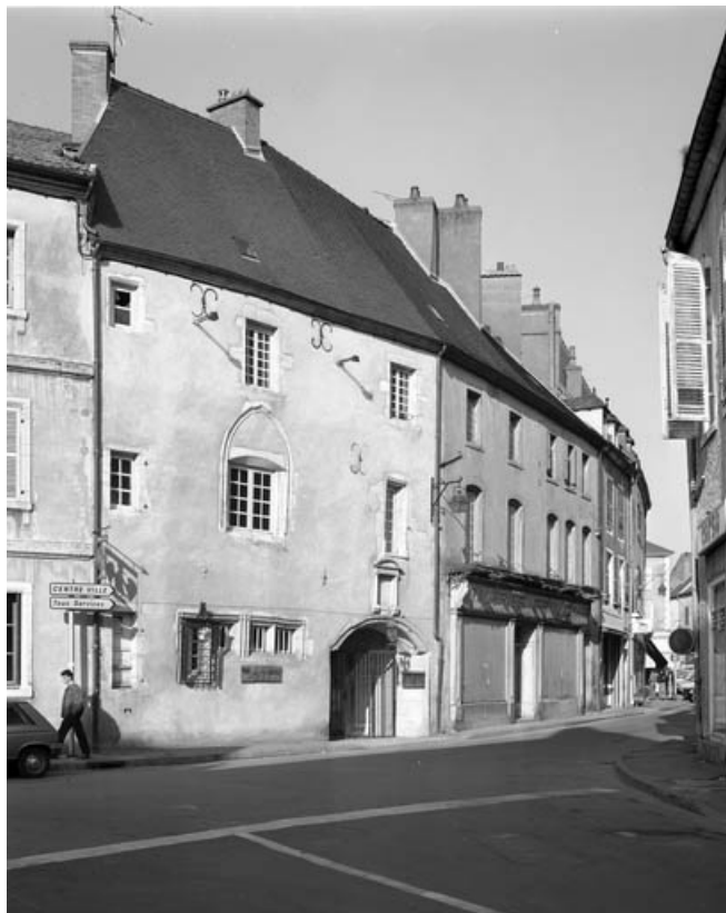
Façade antérieure : partie droite, vue rapprochée.
