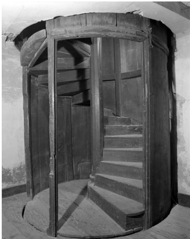
Détail du rez-de-chaussée du cylindre pivotant contenant l'escalier : partie libre donnant accès à l'escalier. 70, Gray, 4, 6, 8 rue du Marché
