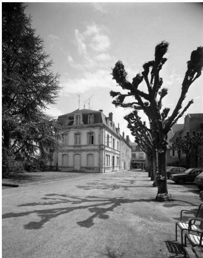
Bâtiment administratif : vue d'ensemble.
