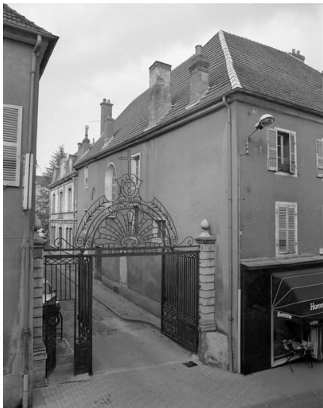
Grille d'entrée de la cour côté Grande Rue : ouverte et de trois quarts droite. 70, Gray Grande Rue 87
