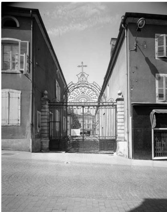
Grille d'entrée de la cour côté Grande Rue : fermée et de face. 70, Gray Grande Rue 87
