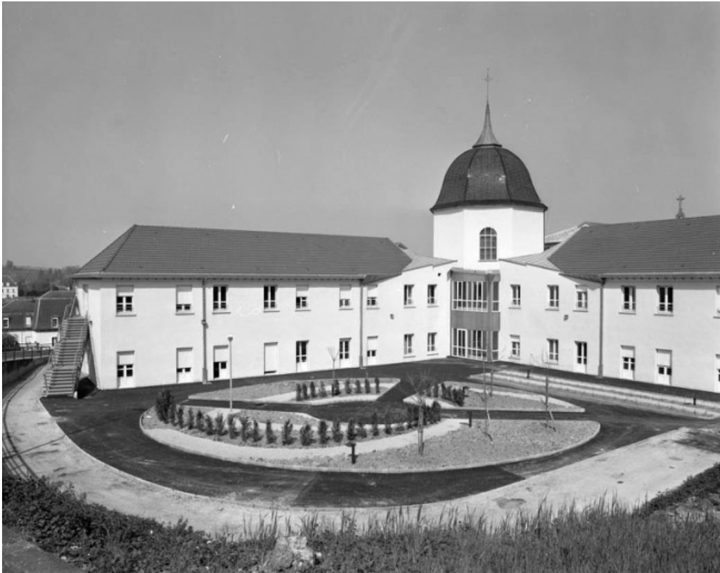
Cour à l'arrière de l'édifice : vue rapprochée.
