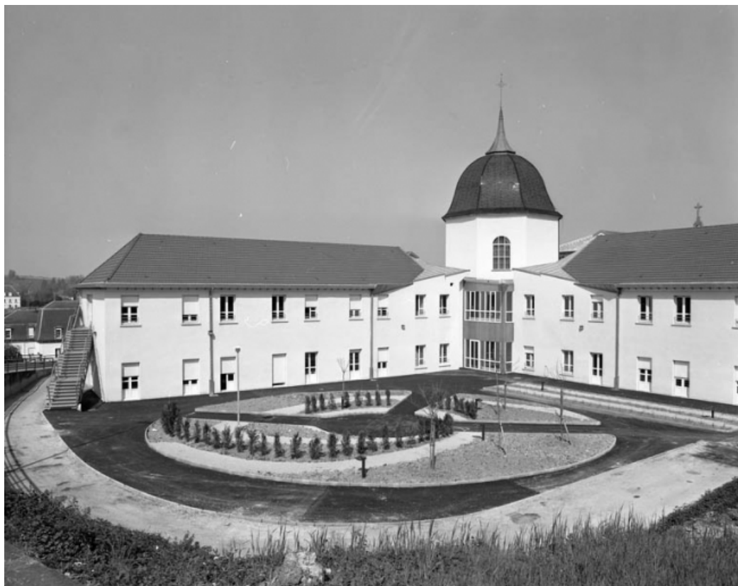
Cour à l'arrière de l'édifice : vue rapprochée.
