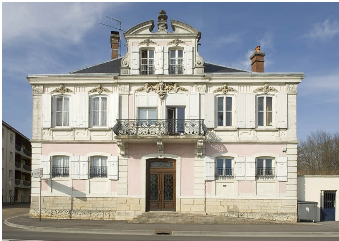
Pignon du logement patronal. 70, Gray
