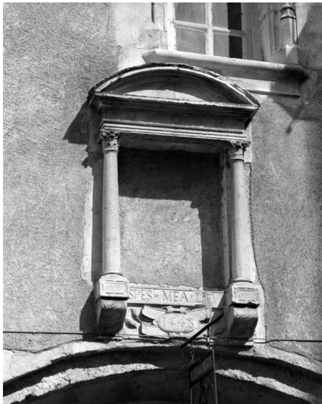
Façade antérieure : partie droite, détail de la niche au dessus du portail d'entrée. 70, Gray, 4, 6, 8 rue du Marché
