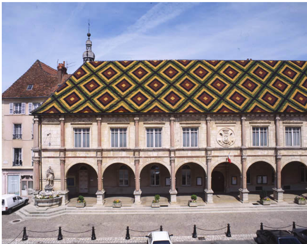
Vue de face : partie gauche. 70, Gray place De Gaulle
