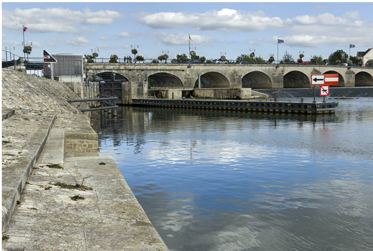
L'écluse, vue aval.
