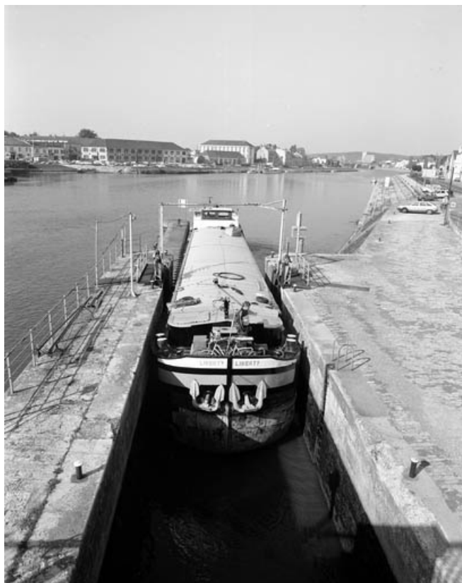
L'écluse, de face, avec péniche au premier plan engagée dans le chenal. 70, Gray quai de l' Ecluse
