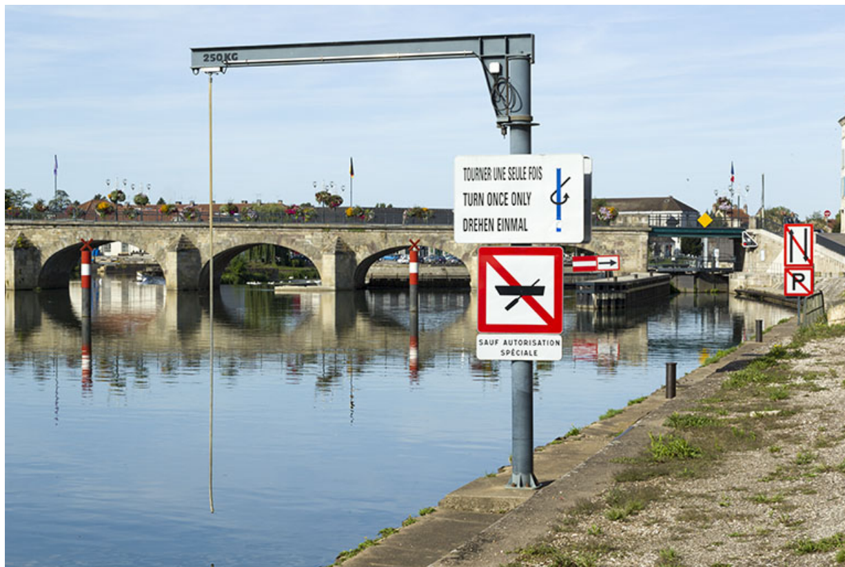
Instrument permettant d'ouvrir l'écluse de manière automatique.
