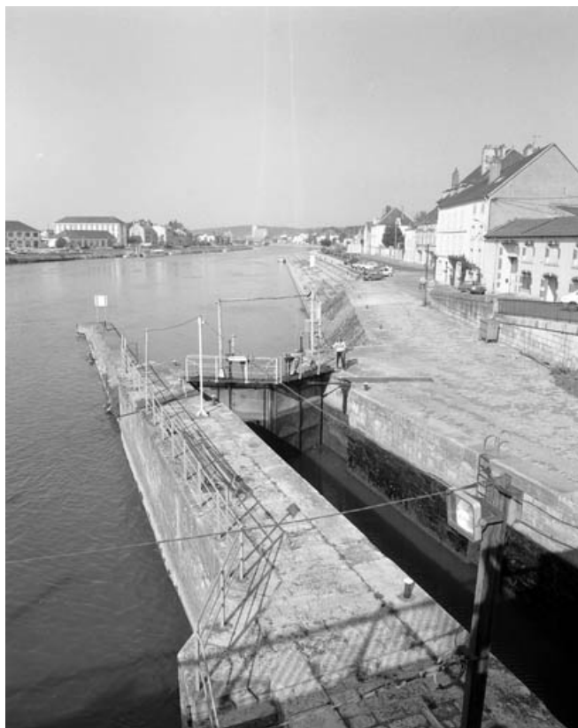
Vue d'ensemble rapprochée avec le quai Villeneuve.
