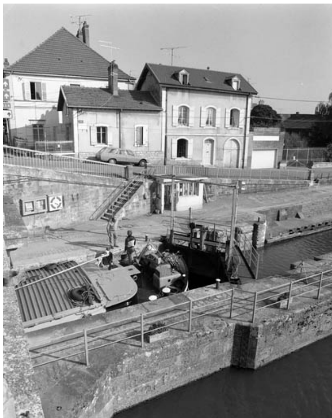
La maison de l'éclusier avec l'écluse au premier plan.
