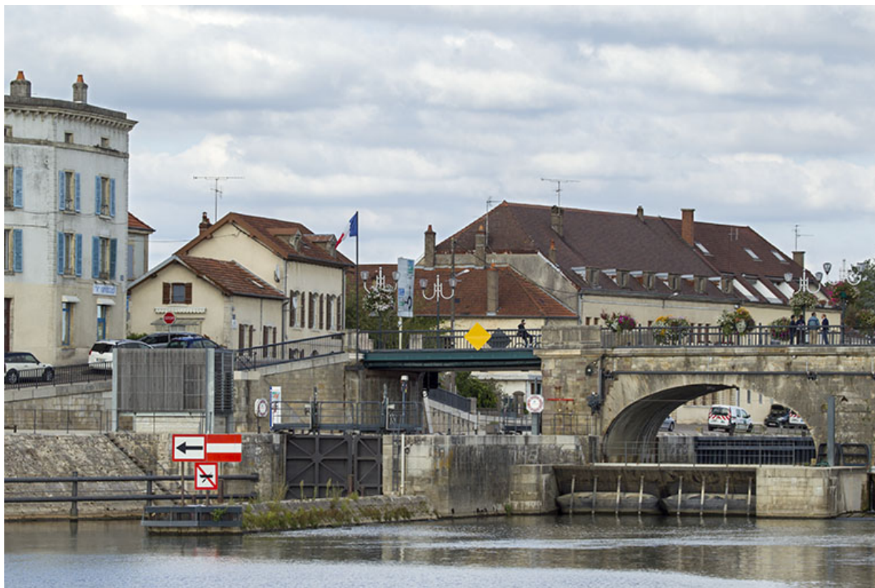
Le site d'écluse, vue aval.
