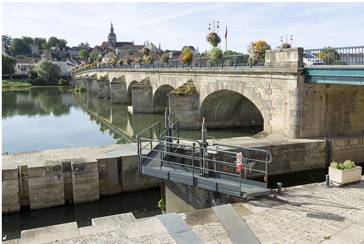
L'écluse avec ses portes busquées et le pont en arrière-plan.
