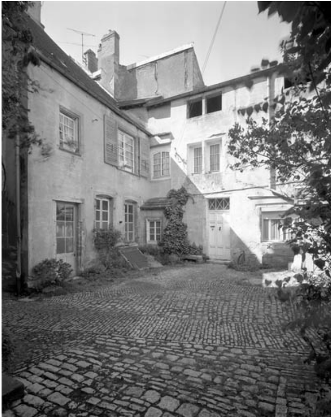
Façades sur cour : vue d'ensemble.
