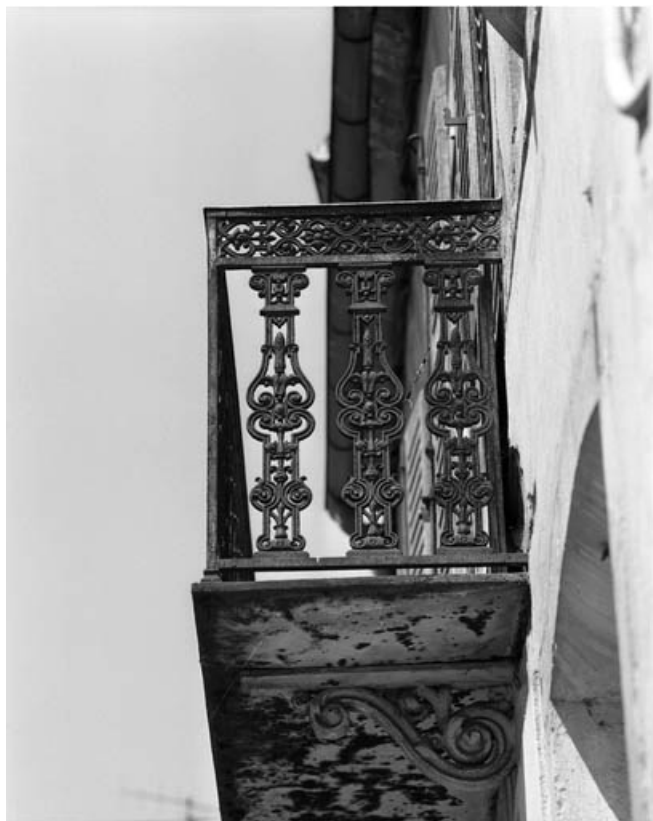
Façade sur rue : détail du balcon côté gauche.
