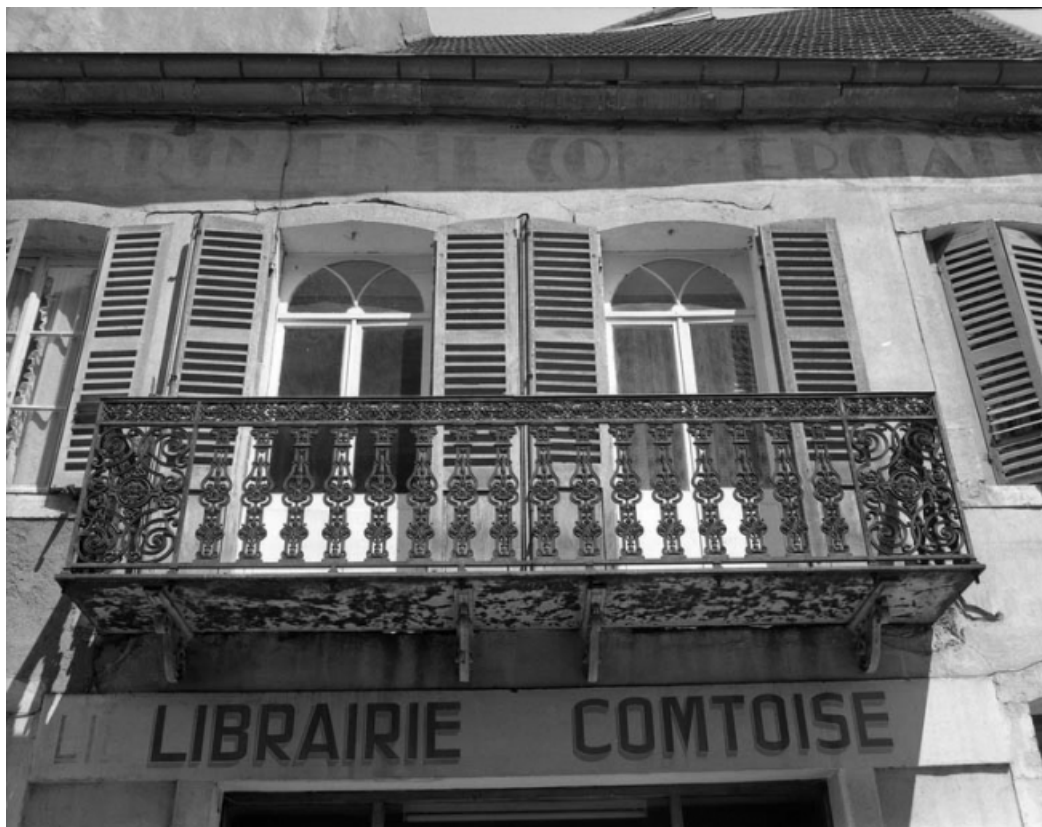
Façade sur rue : détail du balcon de face.
