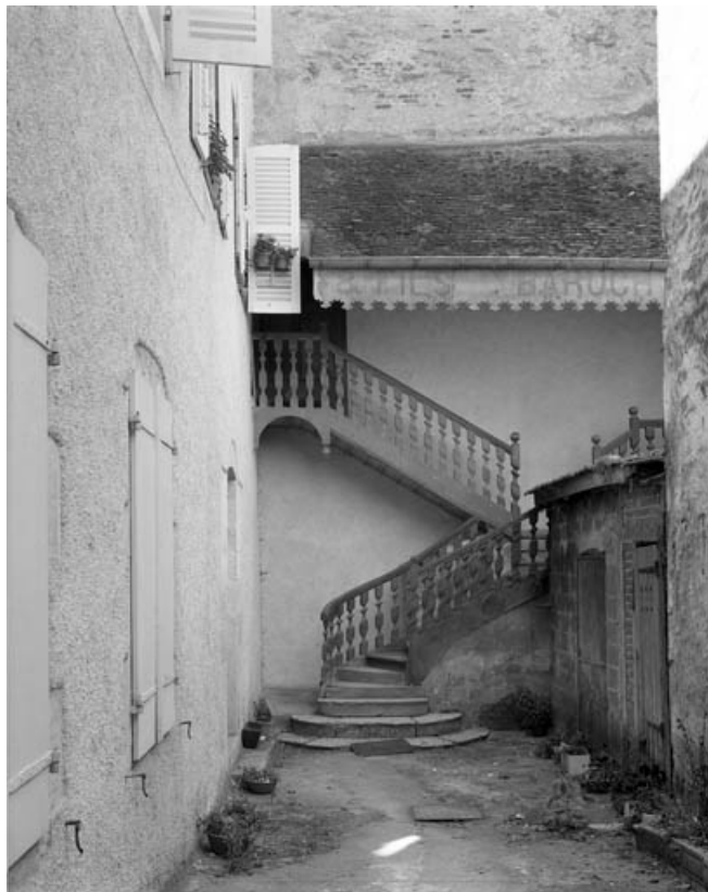
Détail de l'escalier extérieur : de face.
