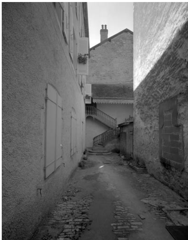
Détail de l'escalier extérieur, au fond de la cour depuis le porche d'entrée. 70, Gray, 13 rue de l' Eglise
