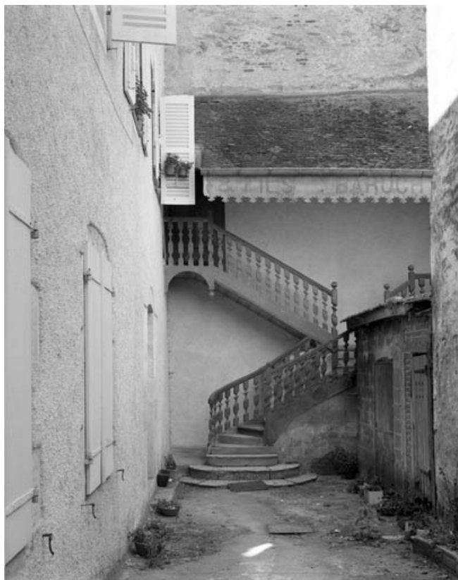
Détail de l'escalier extérieur : de face.
