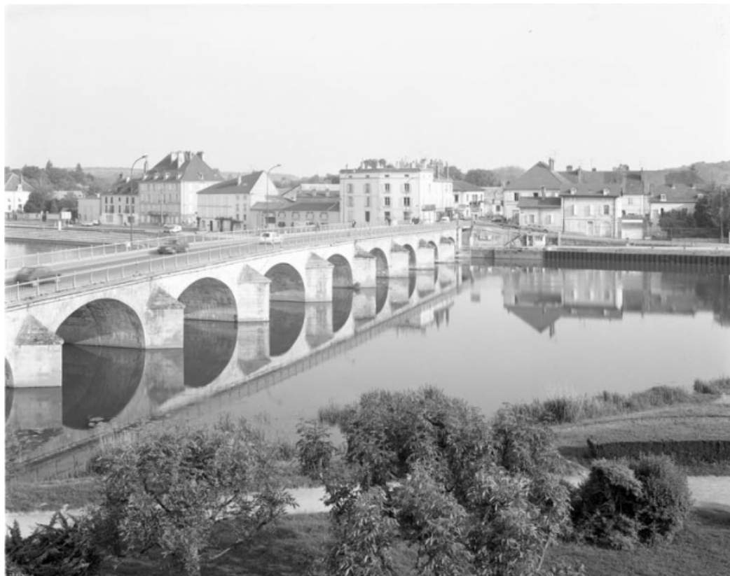
Vue d'ensemble depuis la ville basse. 70, Gray
