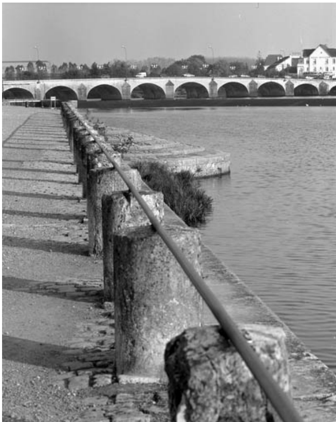
Vue d'ensemble depuis le quai de l'Ecluse. 70, Gray
