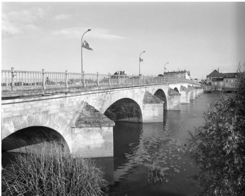
Détail des arcs et des culées de trois quarts gauche.
