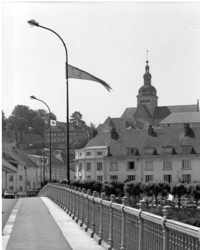
Vue du garde-corps en fonte.
