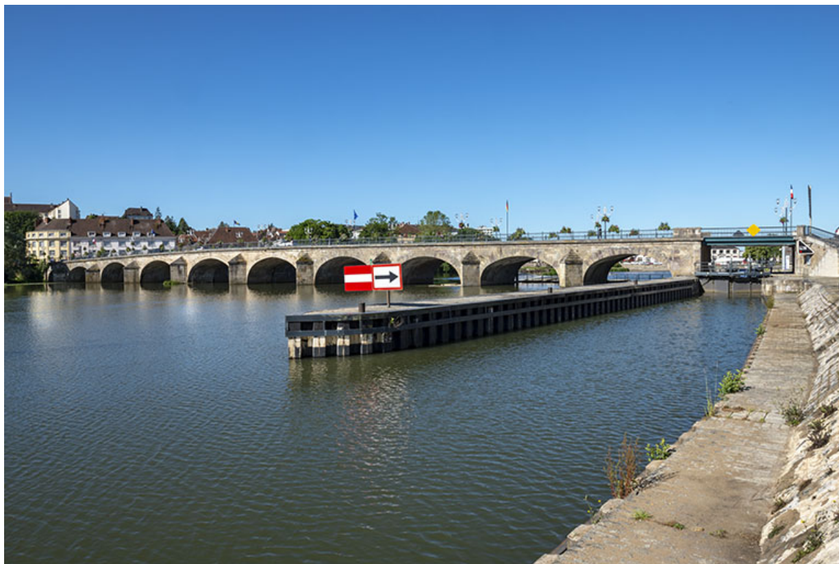
Entrée amont de l'écluse et pont en pierre. 70, Gray
