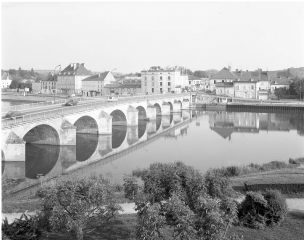
Vue d'ensemble depuis la ville basse. 70, Gray
