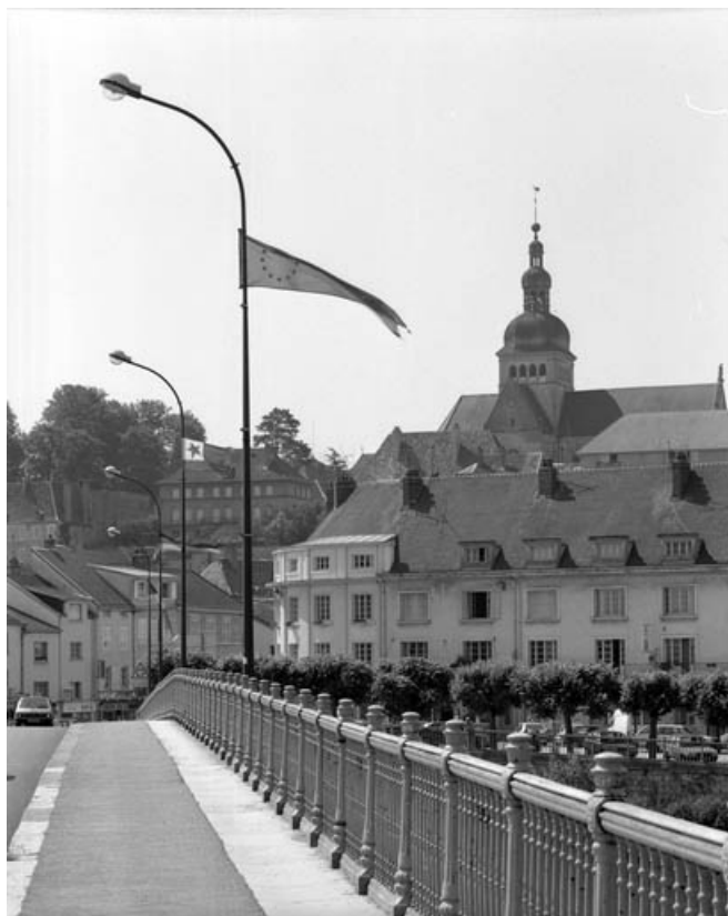
Vue du garde-corps en fonte.
