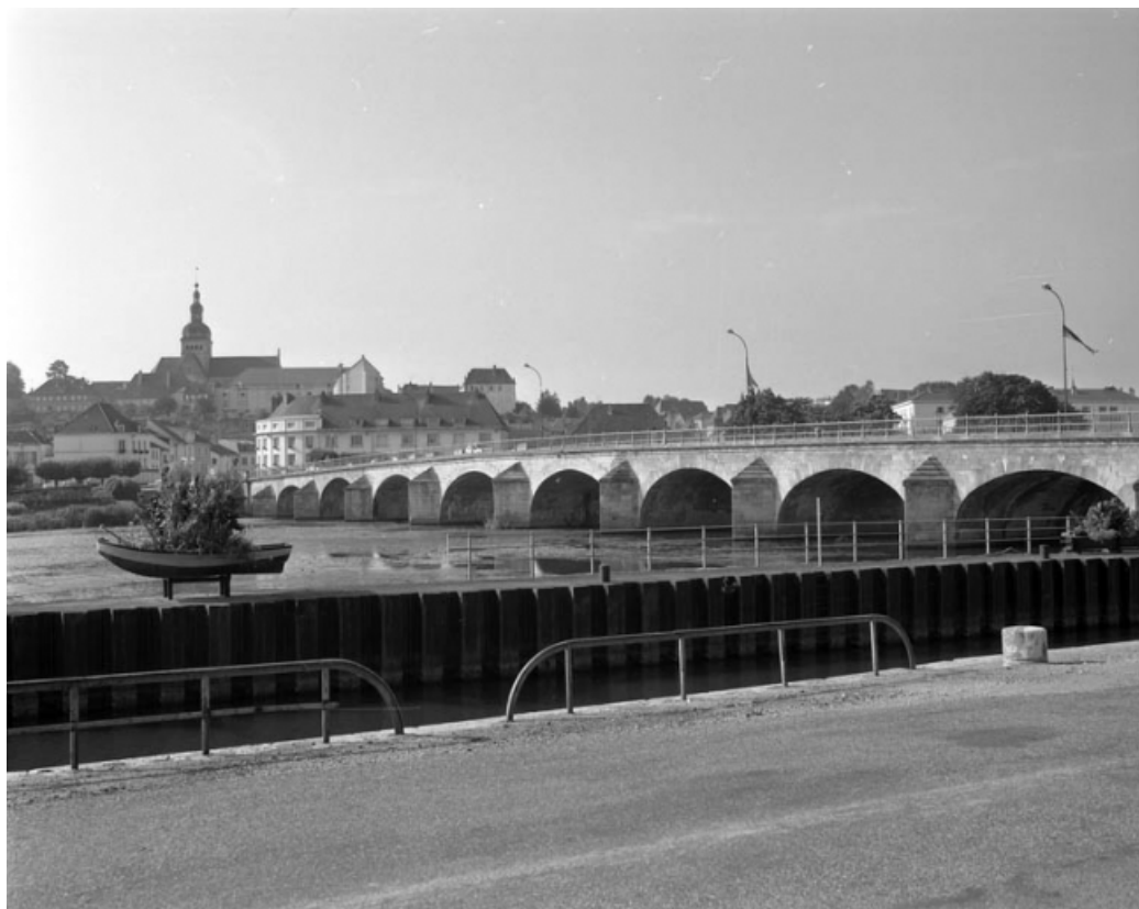
Vue d'ensemble depuis le quai Vergy. 70, Gray
