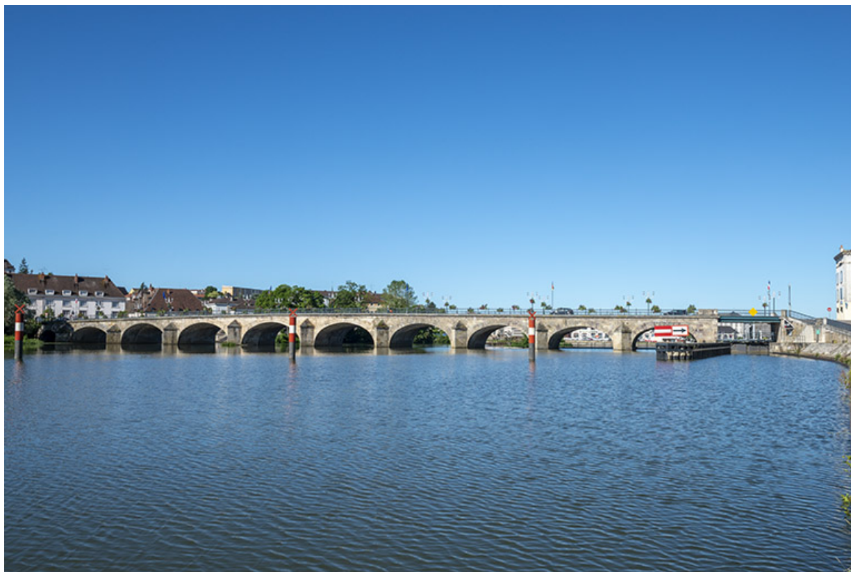
Vue d'ensemble du pont en pierre de Gray. 70, Gray
