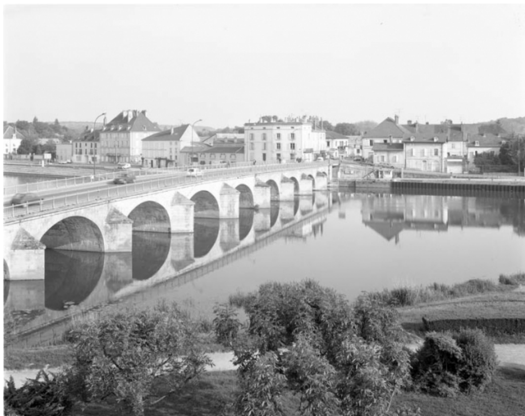
Vue d'ensemble depuis la ville basse. 70, Gray
