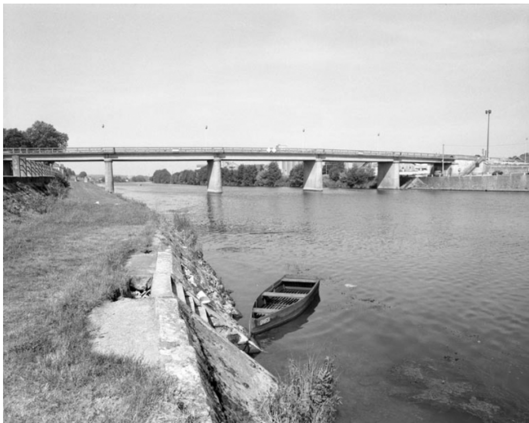
Pont reconstruit en 1945 en remplacement du pont suspendu : vue éloignée. 70, Gray
