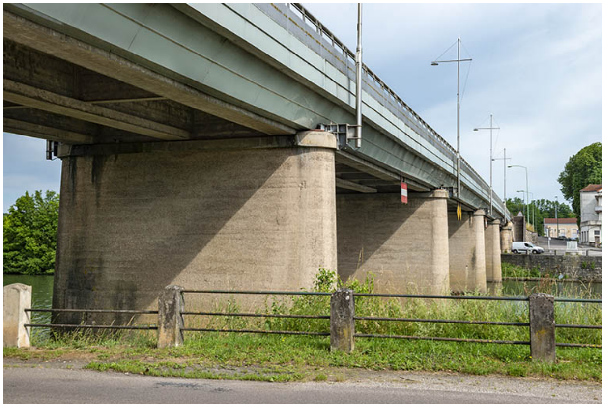
Vue de détail des piles du pont.
