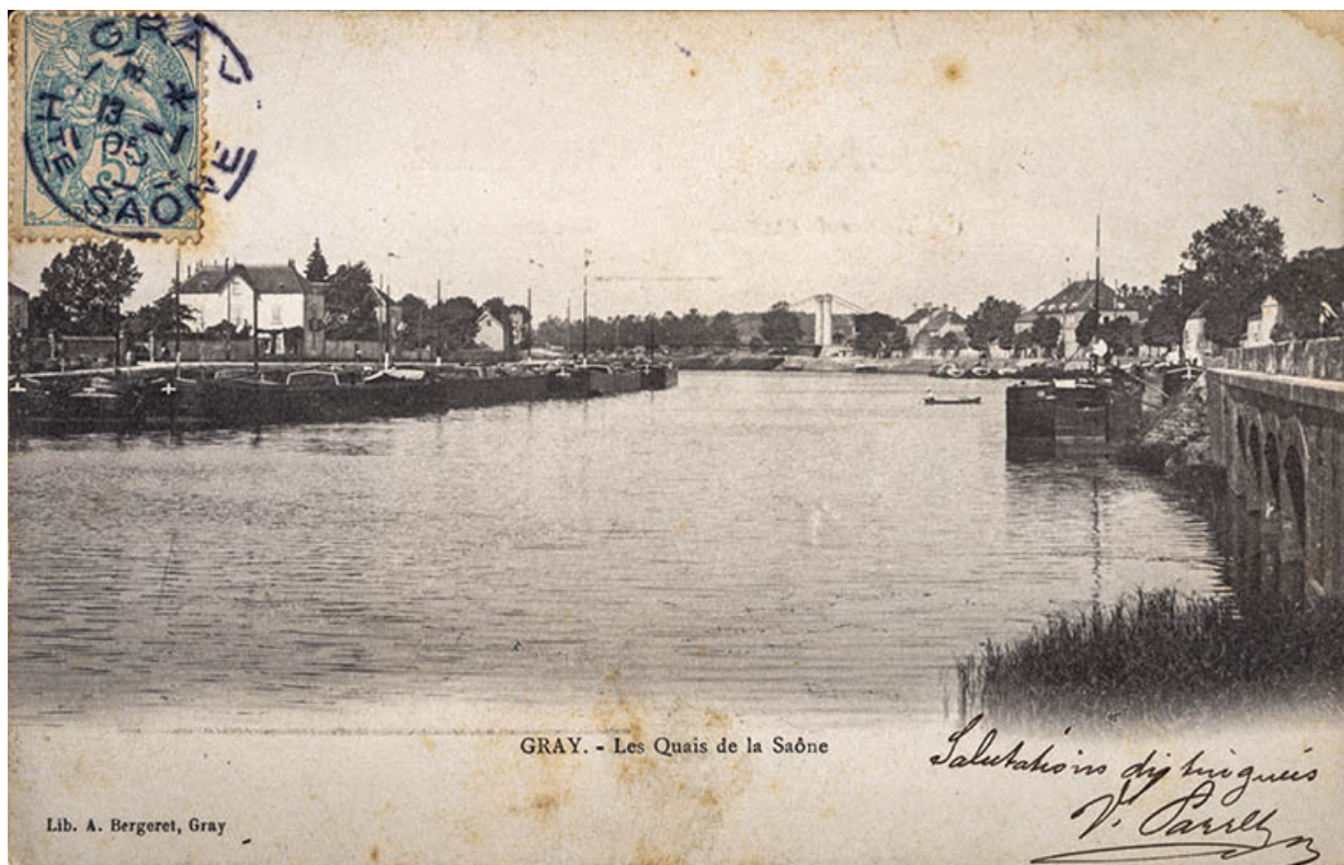
Les quais avec le pont au premier plan.
