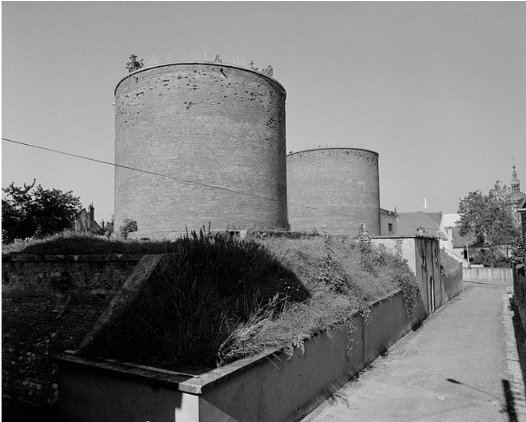
Vue des réservoirs depuis le revers.
