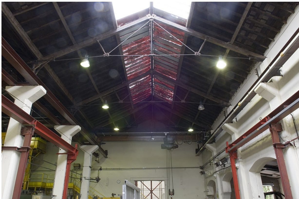
Intérieur de l'atelier et charpente Polonceau. 70, Gray, 3 rue de la Plage
