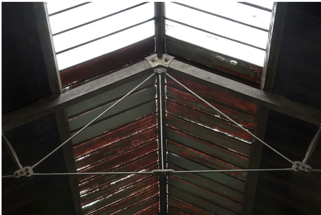
Détail de la charpente Polonaise de l'atelier.
