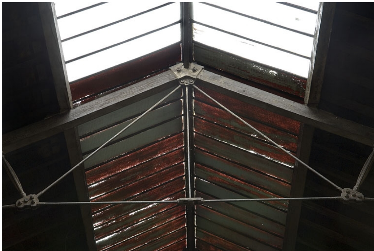
Détail de la charpente Polonceau de l'atelier.
