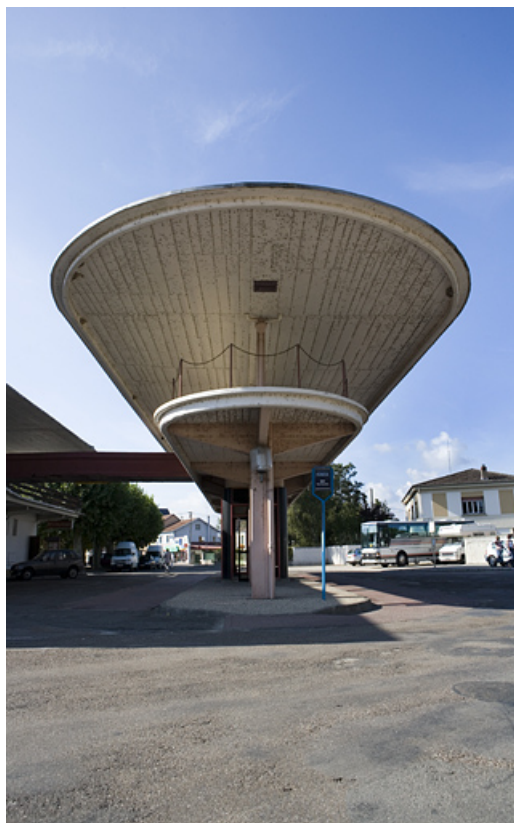
Station bus avec auvents.
