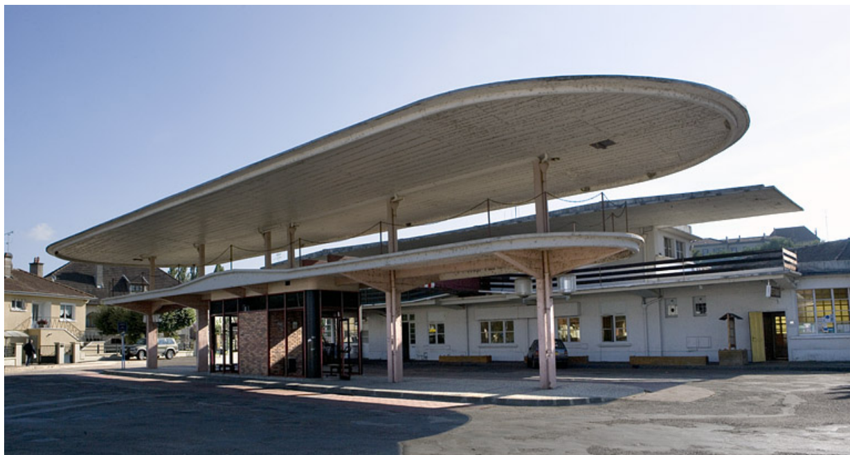
Station bus avec auvents.
