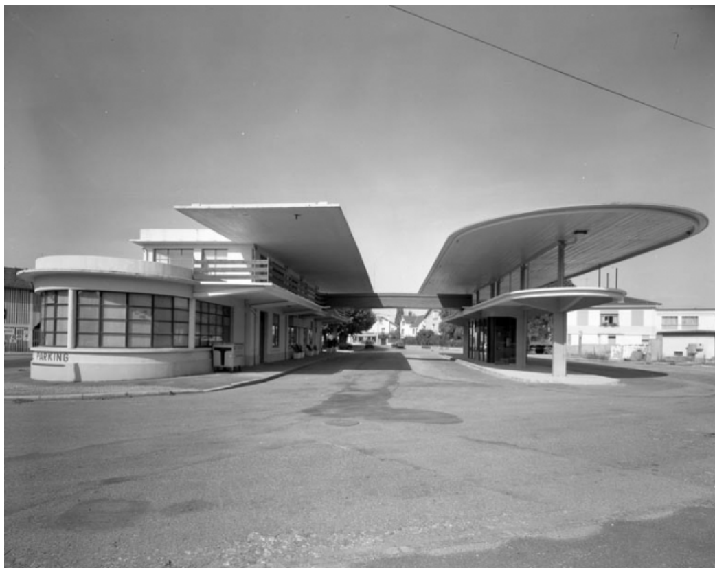
Façade latérale droite de l'édifice avec le quai de débarquement.
