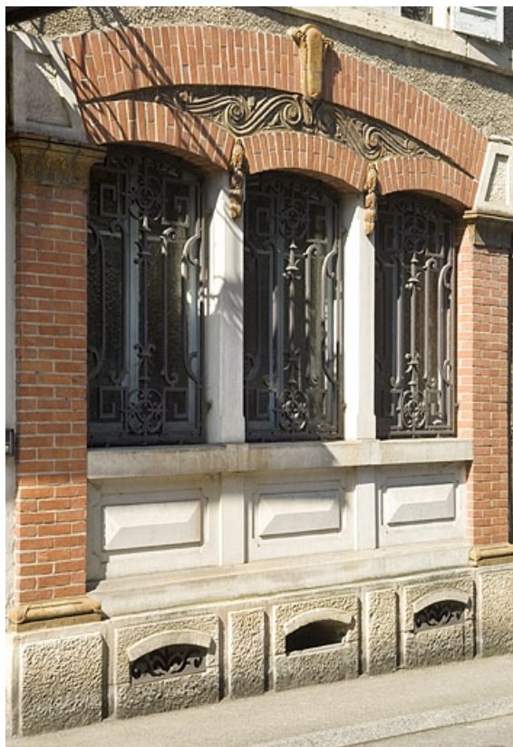
Détail d'une baie triple.
