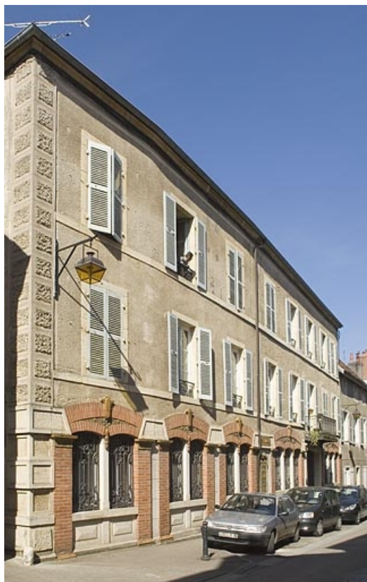
Façade antérieure vue de trois quarts droite. 70, Gray Grande Rue 47
