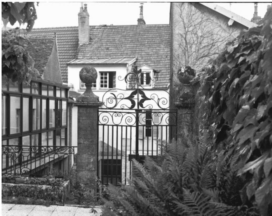
Détail de la grille d'entrée du jardin.
