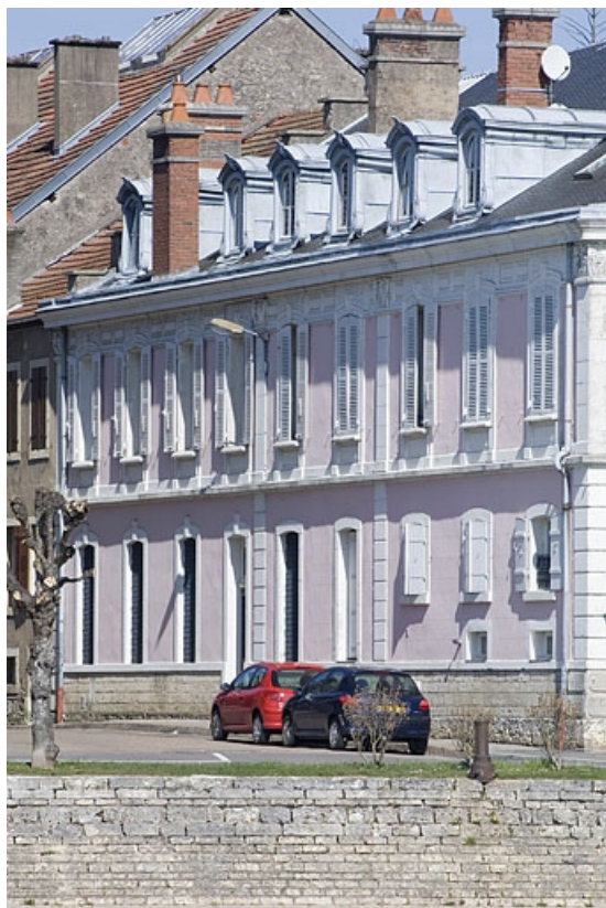
Façade ouest du logement patronal.
