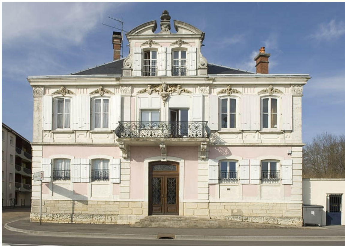
Pignon du logement patronal. 70, Gray
