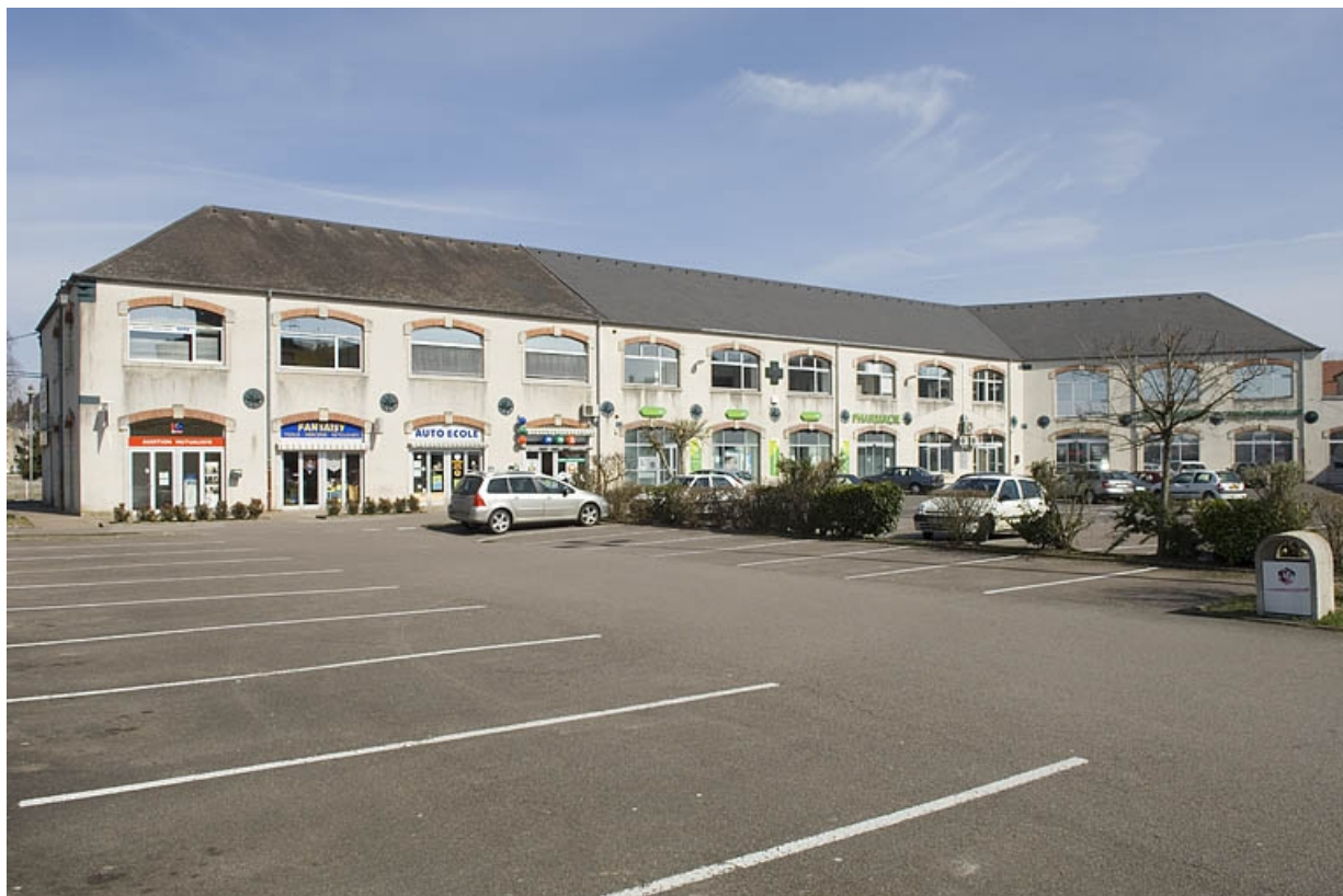
Atelier de fabrication (montage et ajustage) vu depuis le sud-ouest. 70, Gray, 5, 7 quai Mavia
