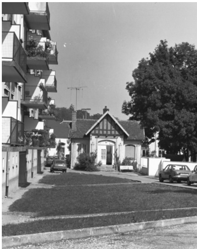
Ancien local de la pompe à incendie en 1988.
