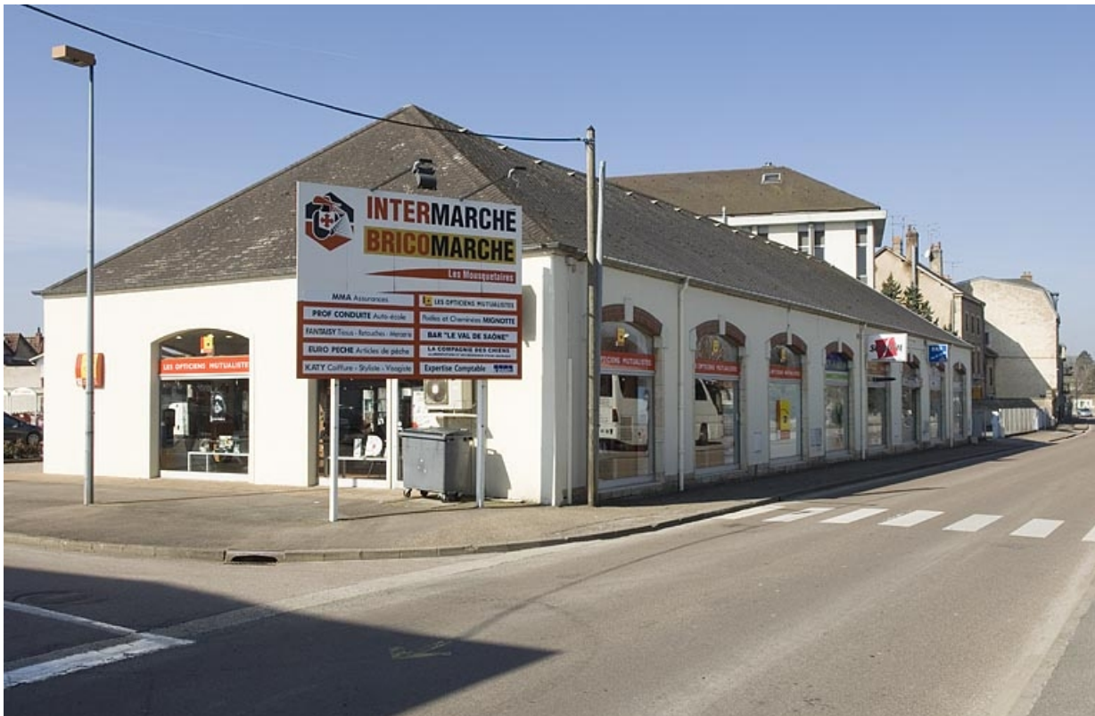
Atelier de fabrication (machines-outils) vu de trois quarts.
