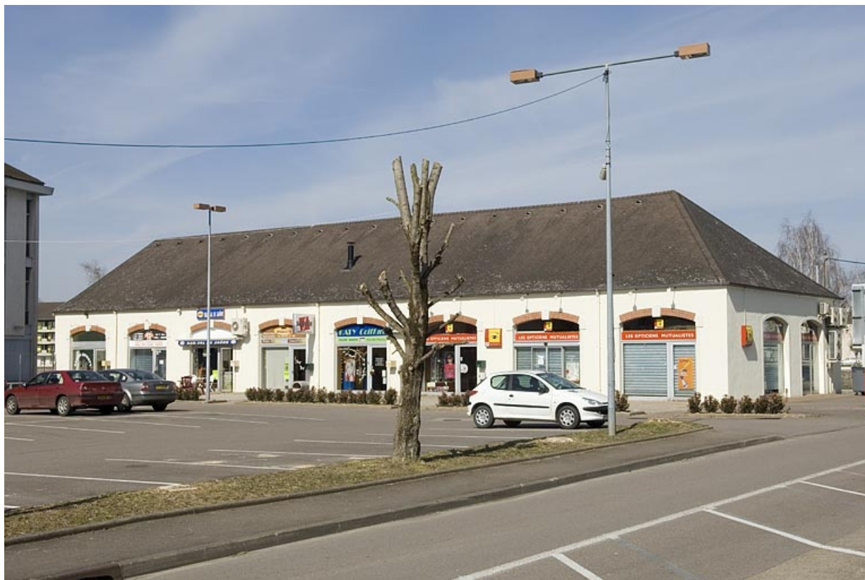
Atelier de fabrication (machines-outils). Façade sud. 70, Gray, 5, 7 quai Mavia
