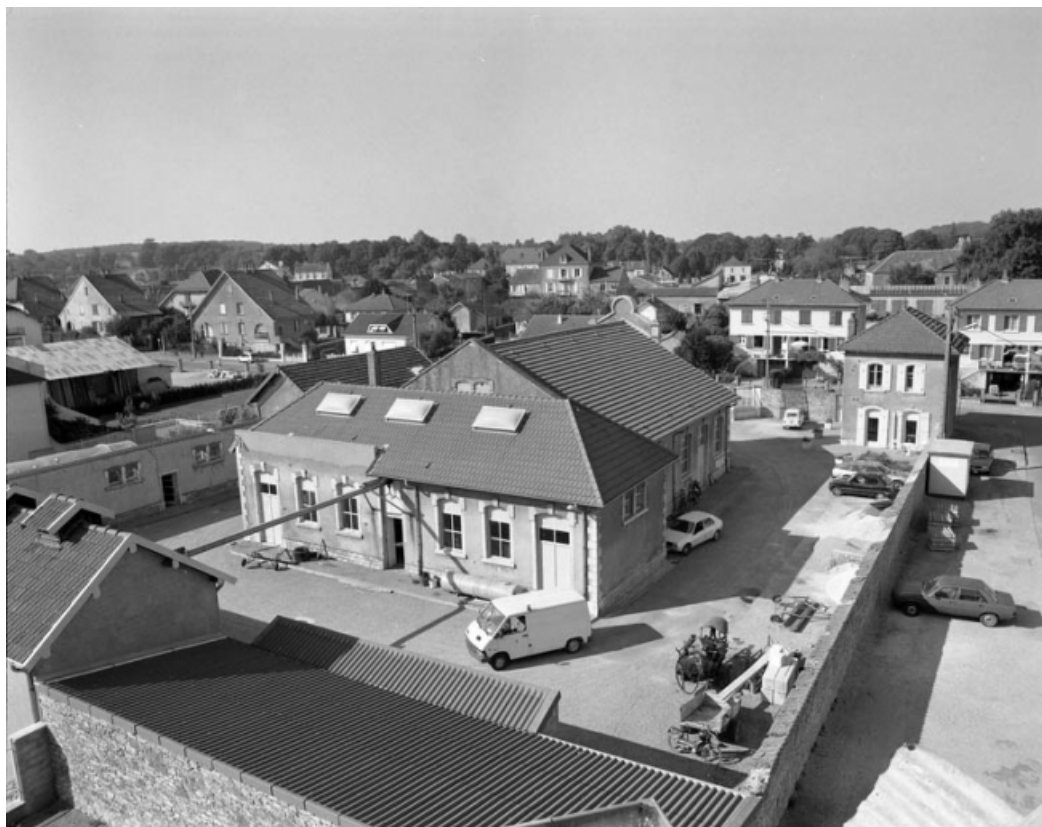
Vue d'ensemble depuis l'arrière de l'édifice. 70, Gray
