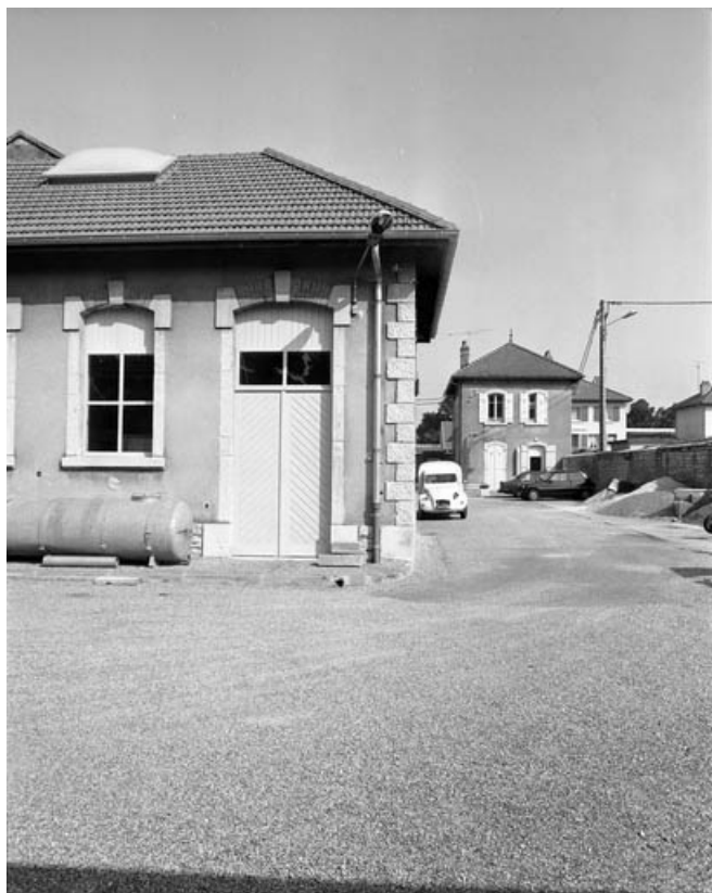
Détail d'une partie de la façade postérieure du bâtiment principal avec la maison du gardien à l'arrière-plan. 70, Gray rue Devosge
