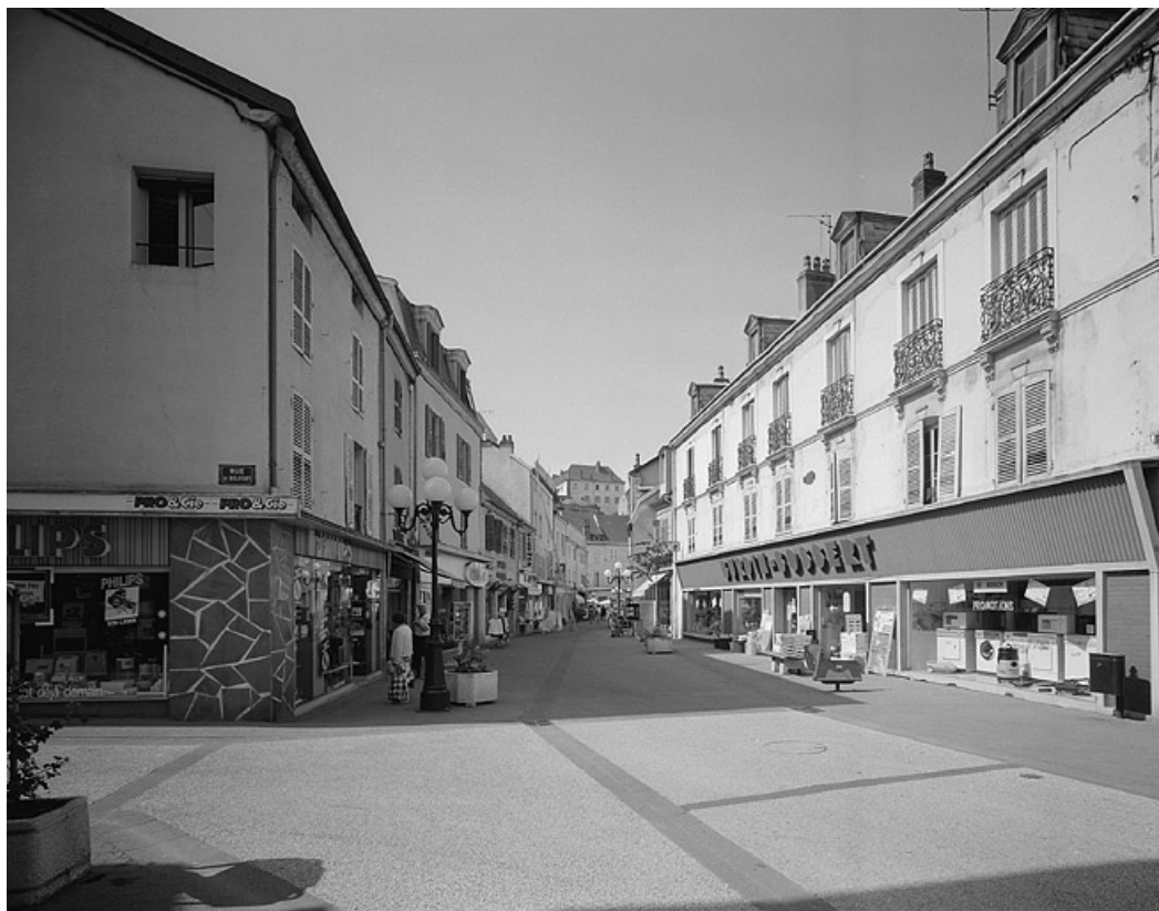
Façade antérieure depuis le carrefour entre rue de Belfort et rue Thiers. 70, Gray
