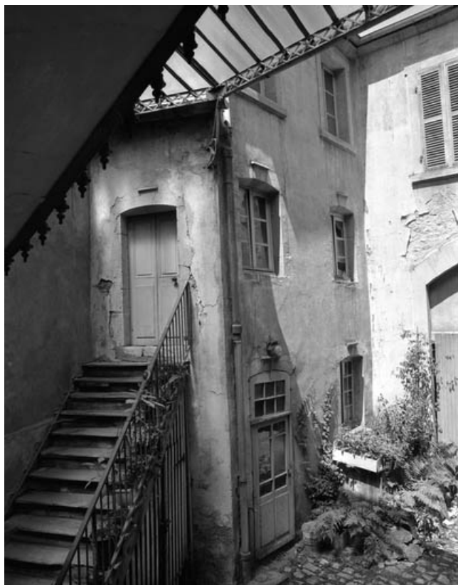
Logement indépendant à droite de la cour : de trois quarts gauche. 70, Gray, 11 rue Thiers
